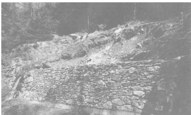
**Figure 2.26 :** Barrage dont le but est de stabiliser le profil en long du torrent et de stopper le phénomène d'érosion régressif, dans le Vicdessos en Pyrénées Ariégeoise (Bonnet, 1986).
