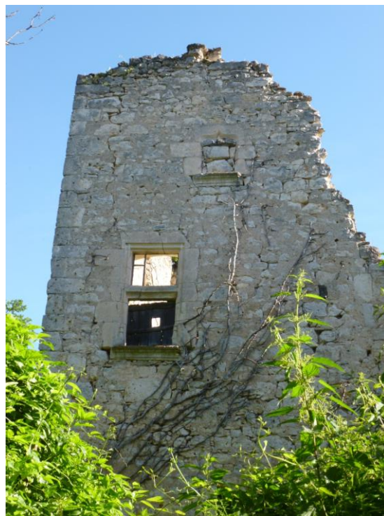
Fig. 20 : Seconde extension sud, mur sud.
