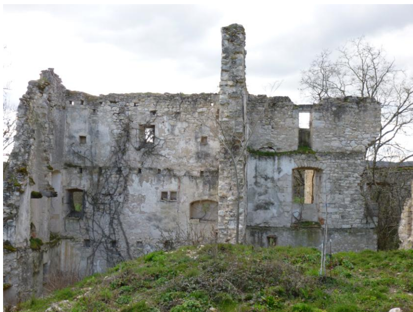
Fig.23 : les extensions sud, vues de l'est.
