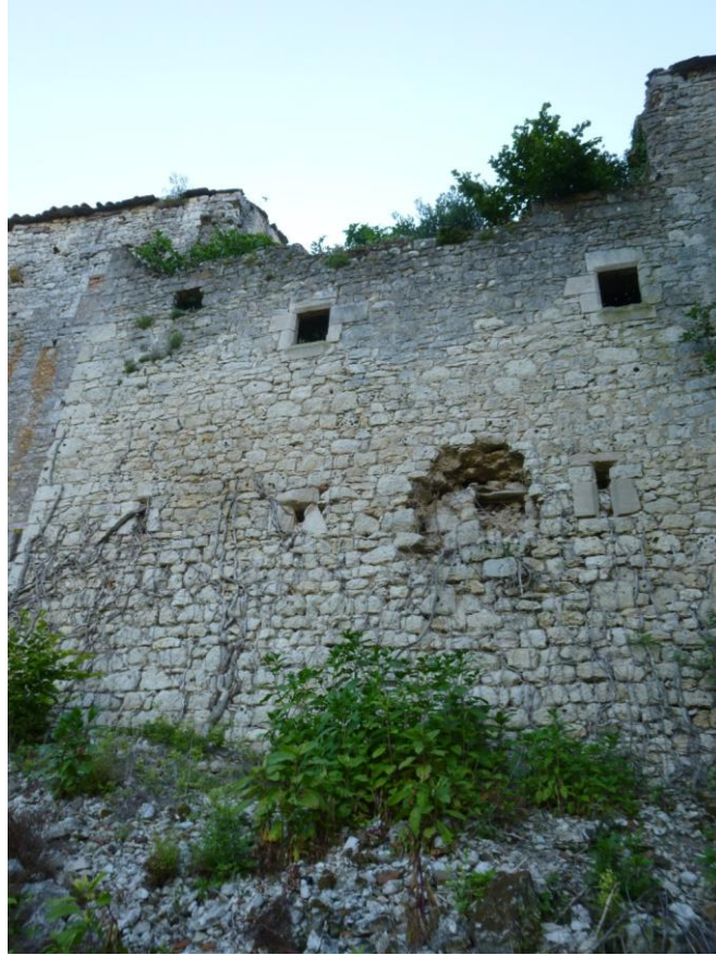
Fig.15 : La tour, partie nord de la façade ouest.
