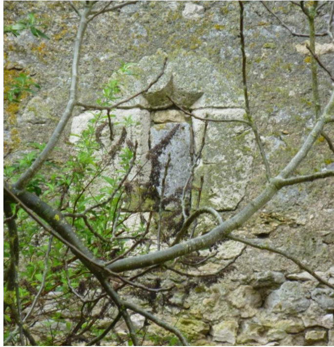
Fig. 21 : Face nord de l'extension nord.
