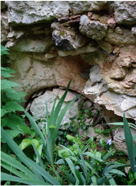
Fig. 30 : Un four au niveau du sol.
