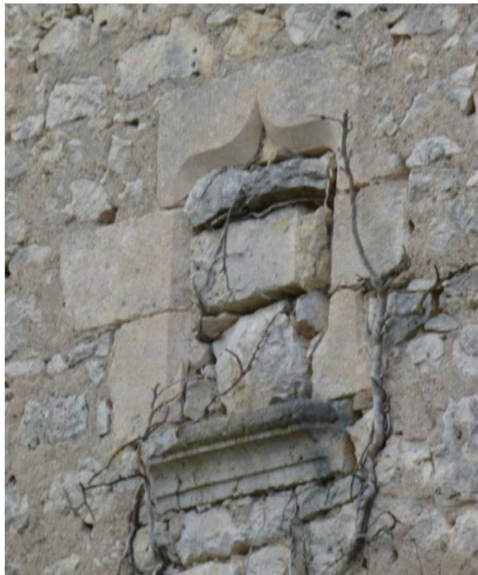
Fig. 22 : Face sud de l'extension sud (234).
