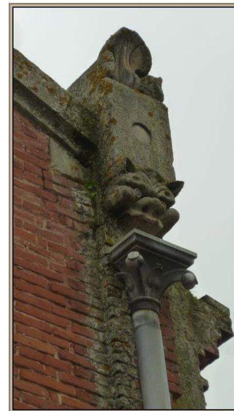
Figures 54 et 55 - Colonnes de fonte et gargouilles en pierre
