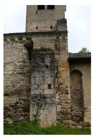
Fig. 80 : Contrefort et mur dans l'axe du clocher coup de sabre entre les deux appareils
