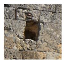
Fig. 81: Trou pour l'ancienne poutre faîtière
