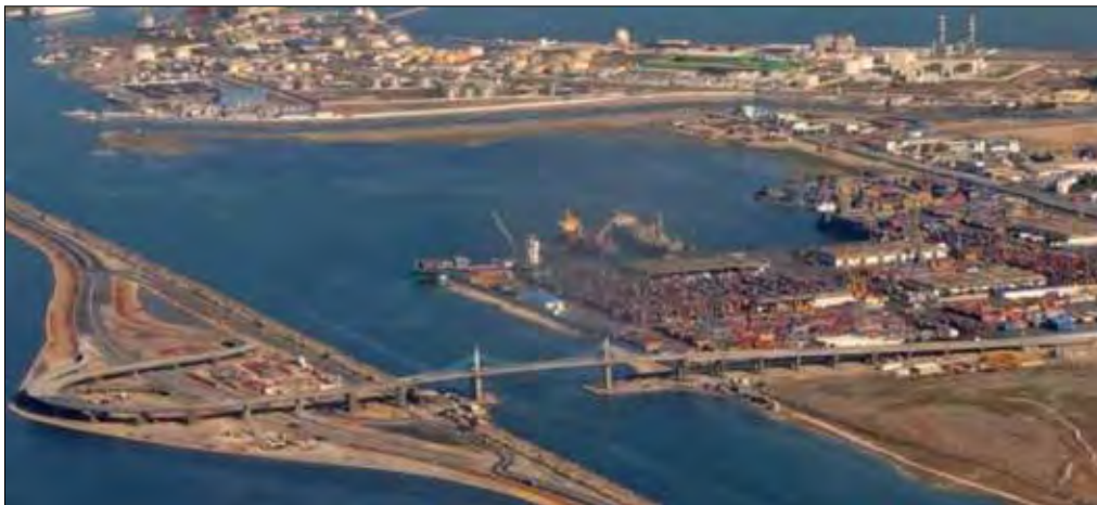
Figure 17: Vue aérienne du pont de Radès.
