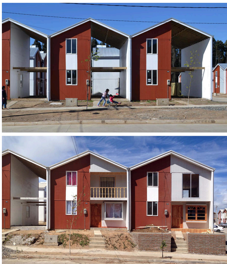
Logement par Elemental à Constitution, Chili. Demi-maisons individuelles de deux étages pour une auto-construction informelle et progressive par les résidents (2010). Aravena a défendu une approche qu'il décrit comme « progressive », dans laquelle les gouvernements financent la construction d'une « moitié de bonne maison », les résidents complétant l'autre partie auto-construite de manière informelle, dans la mesure où les ressources le permettent (Source : Elemental).
