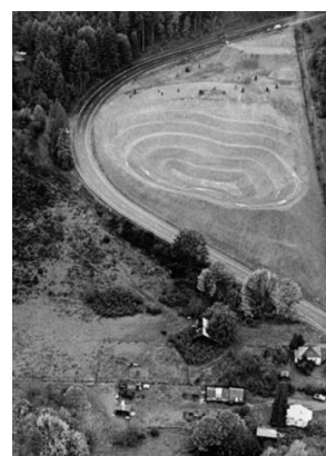
FIGURE 7 : ABATTAGE DES ARBRES AUTOUR DE LA CARRIÈRE POUR LA METTRE EN VALEUR
