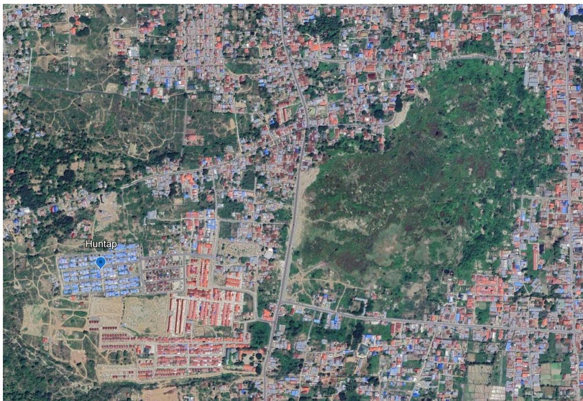
Fig. 1 : Photographie satellite du quartier de Balaroa. En vert, la zone de liquéfaction aujourd'hui recouverte d'une végétation luxuriante et requalifiée en zone rouge. En bas à gauche, le huntap de Balaroa est en bleu, avec les nouveaux complexes d'habitations privés en orange (Google Earth, capture d'écran réalisée le 29/06/24).
