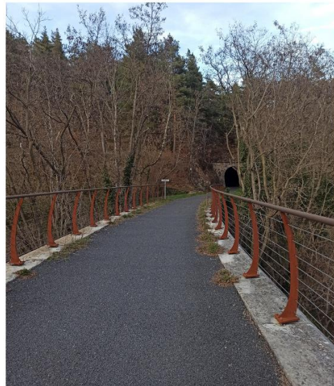
Figure 1 : La Dolce Via en direction de Lamastre
