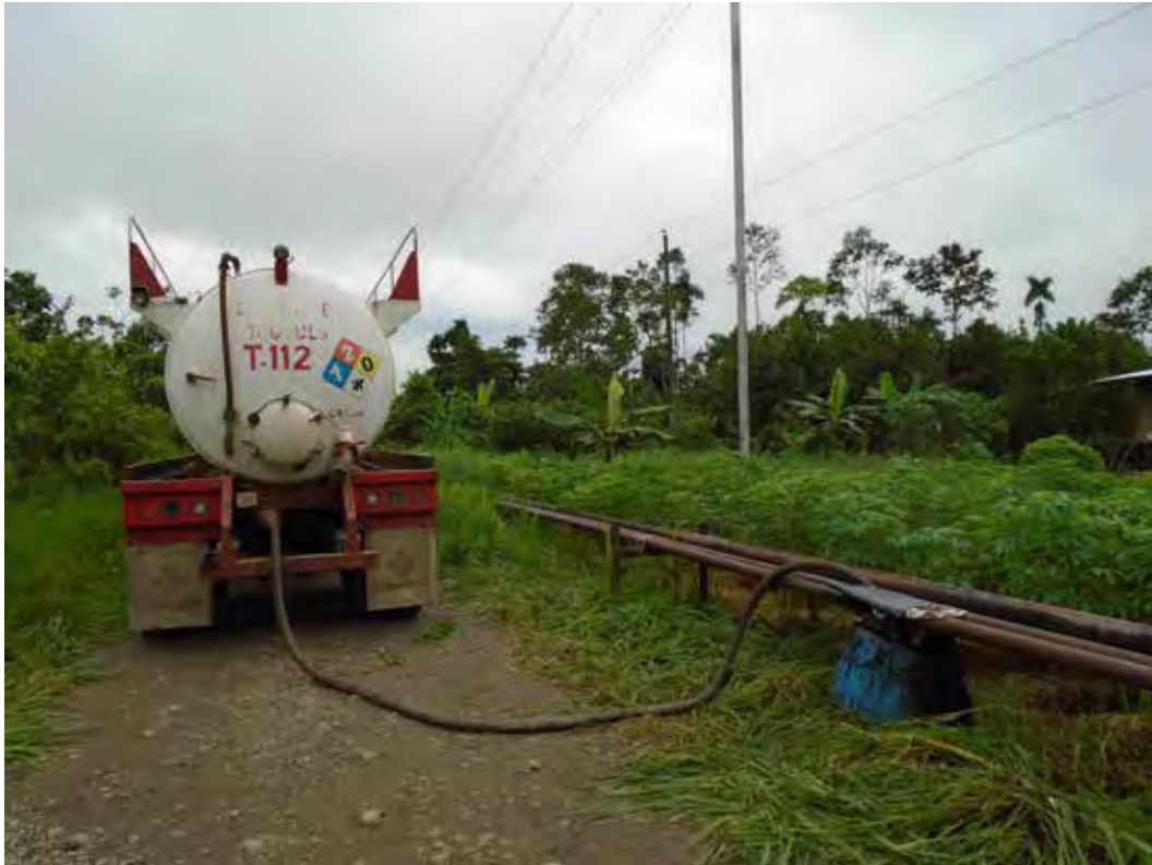
Image 5 : Gestion d'une fuite d'eau de formation à l'entrée d'une ferme (Communautés 9 de diciembre, Pacayacu, 2016)
