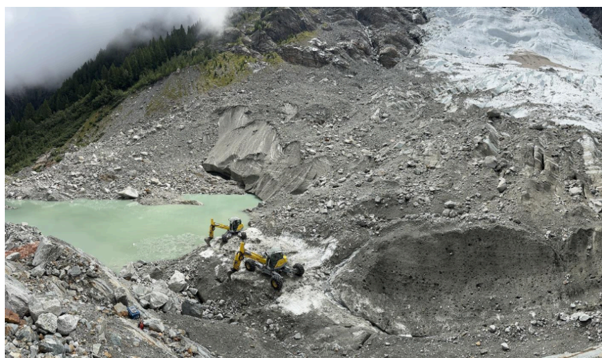
Figure 19 : travaux de vidange à la pelle araignée, Radio Mont Blanc, 2 août 2023
