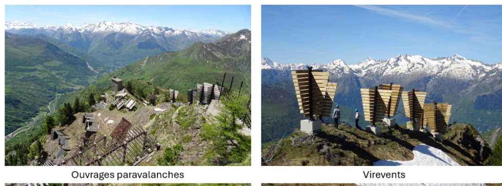
Figure 7 : suivi d'ouvrages paravalanches au Capets (65)
