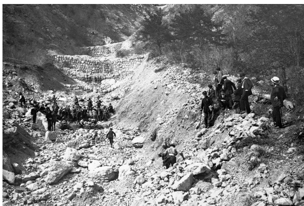
Figure 2 : Construction d’un barrage de correction torrentielle, Saint Nazare les Eymes, 1921
