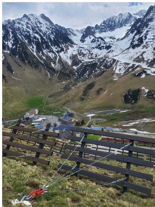
Figure 3 : ouvrages paravalanches au dessus de la Mongie, avril 2025
