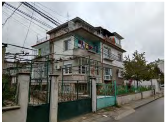
Une variété d'appropriations en façade
