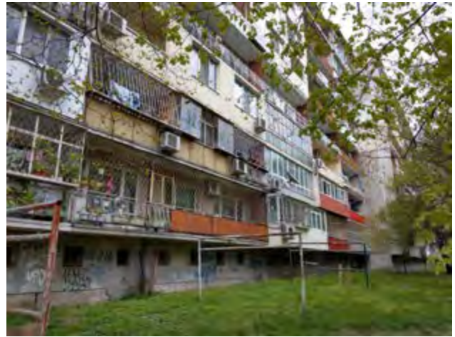
Des façades sud transformées par les habitants
