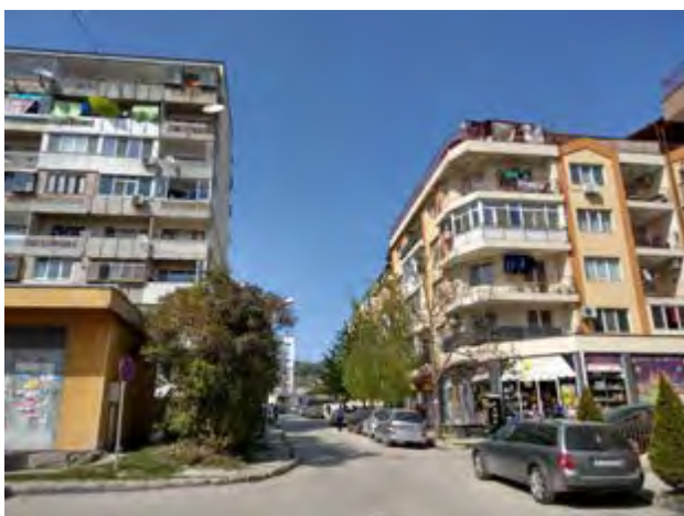
Des opérations contemporaines jouxtant les préfabriqués communistes
