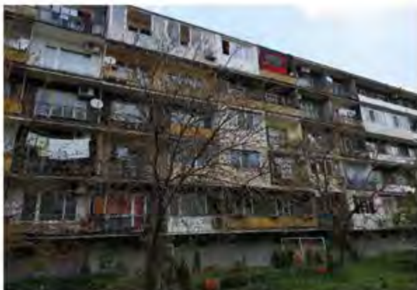
Façades sud de la typologie
