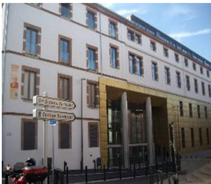
Figure 2 : façade extérieure du collège Berthelot.
