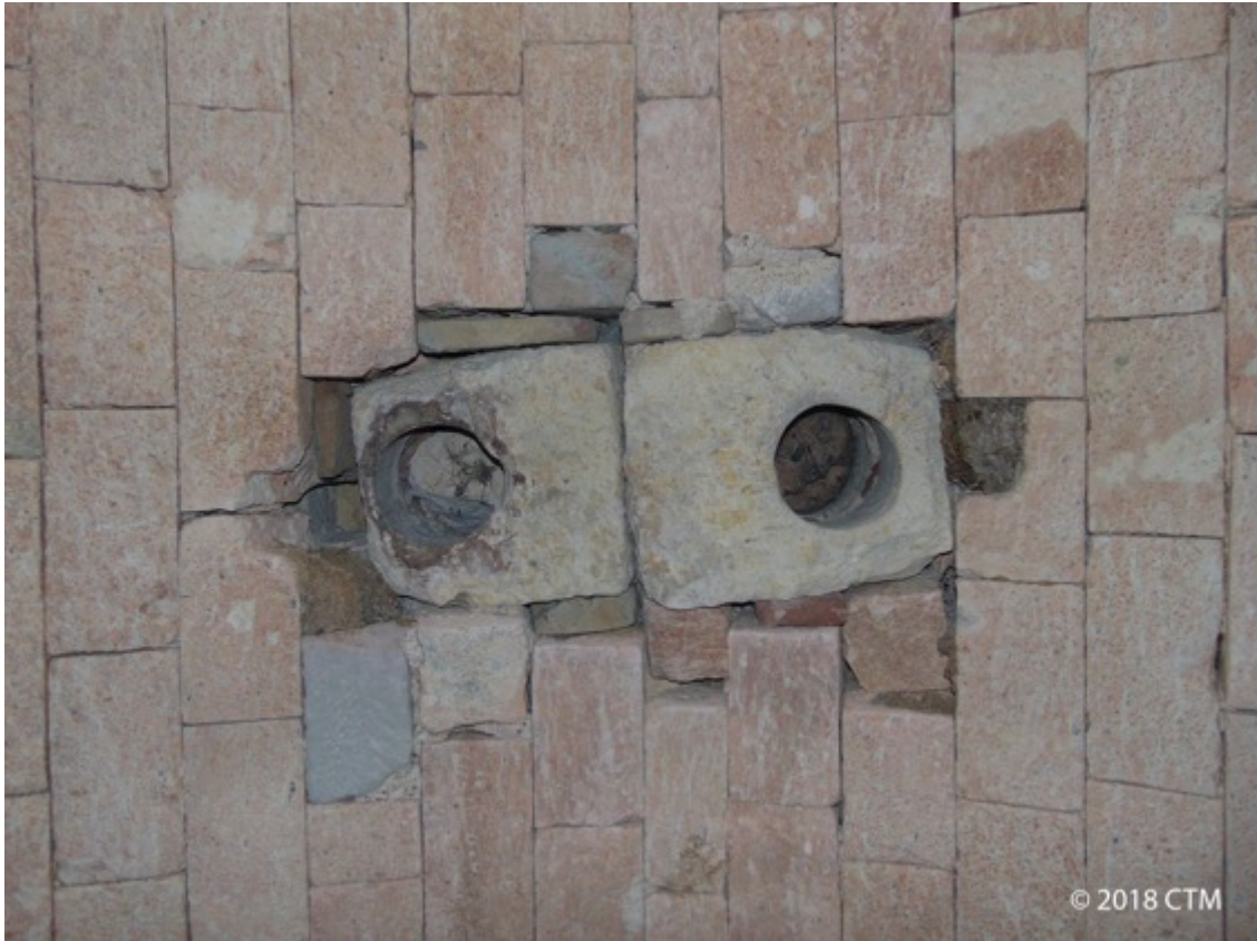
Fig. 144. Labastide-Débat, citerne, acheminement des eaux de ruissellement.
