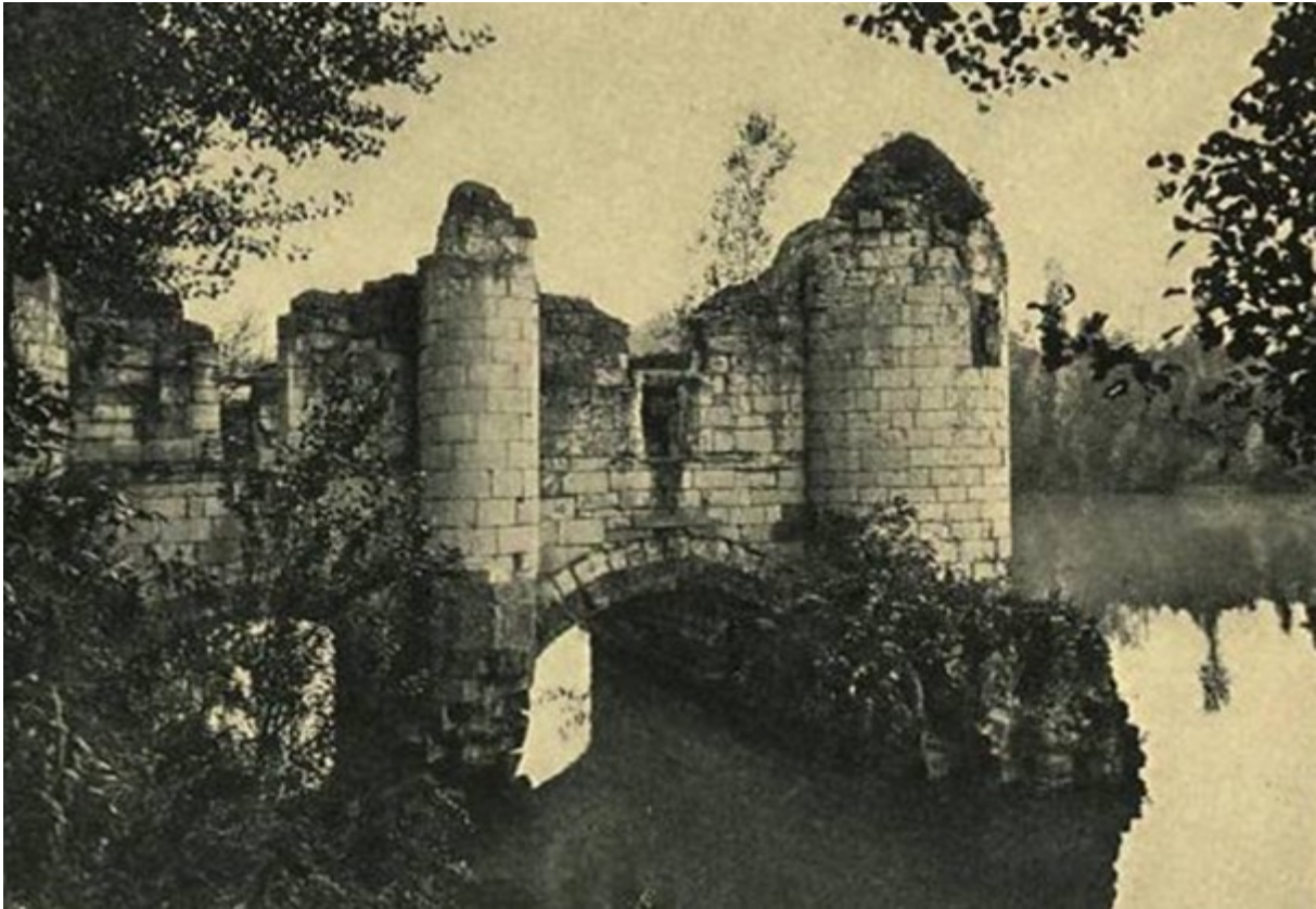
Fig. 31. Le « Vieux Moulin » de Marsac sur le Tarn.
