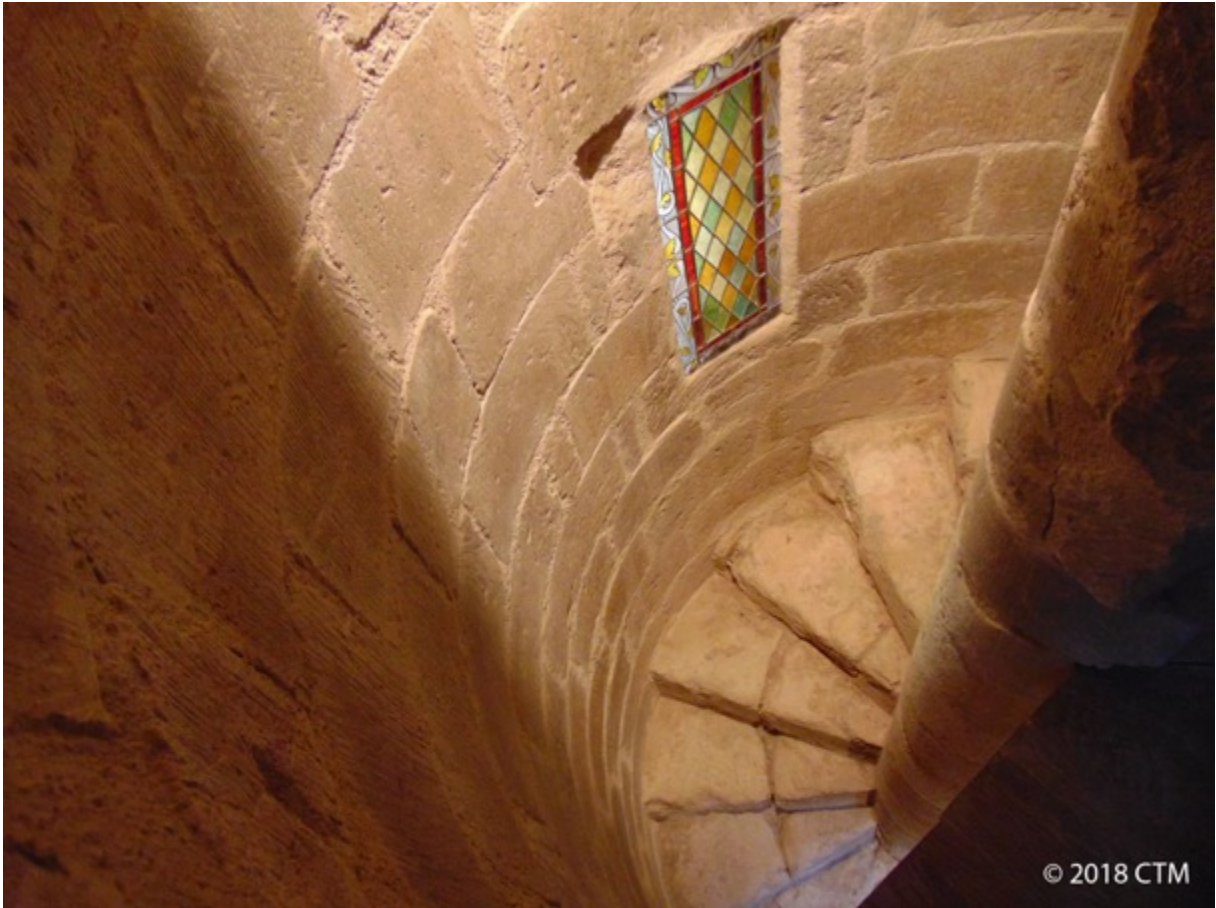
Fig. 151. Labastide-Débat, aula , escalier à vis.
