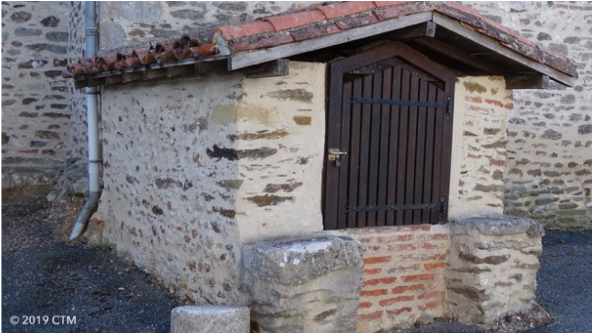
Fig. 58. Cambon, puits adossé à l'église Saint-Pierre.
