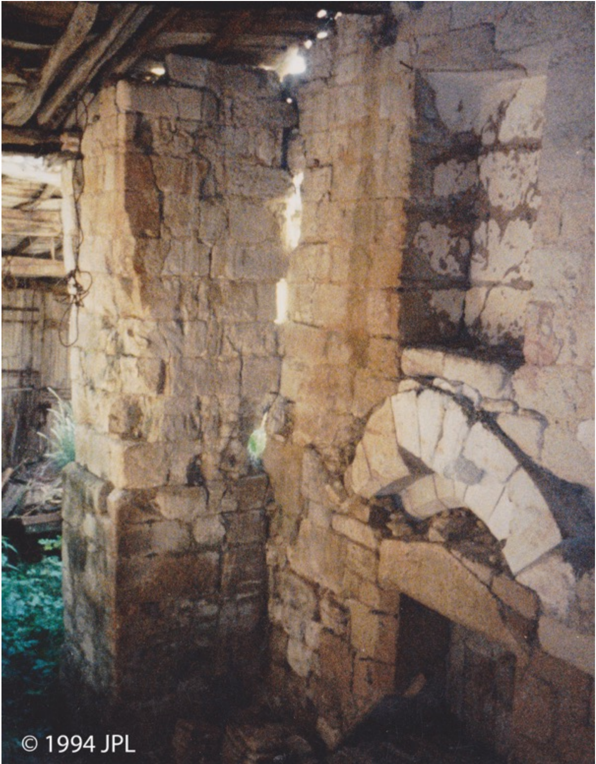
Fig. 153. Labastide-Débat, aula , porte en arc brisé à double rouleau (cliché, Jean-Pierre Lallée).
