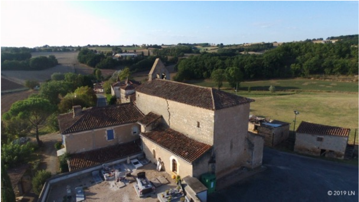
Fig. 191. Léjos, église Saint-André, espace de refuge et d'entreposage aménagé sur l'extrados de la voûte de la nef (prise de vue aérienne par drone, Laurent Nion).
