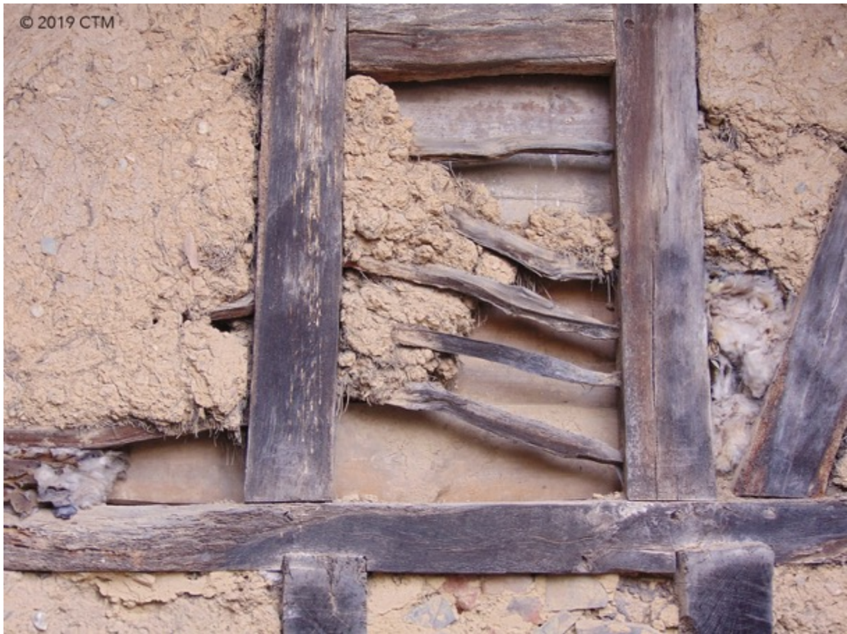
Fig. 215. Les Avalats, clayonnage, frange occidentale de l'enceinte.
