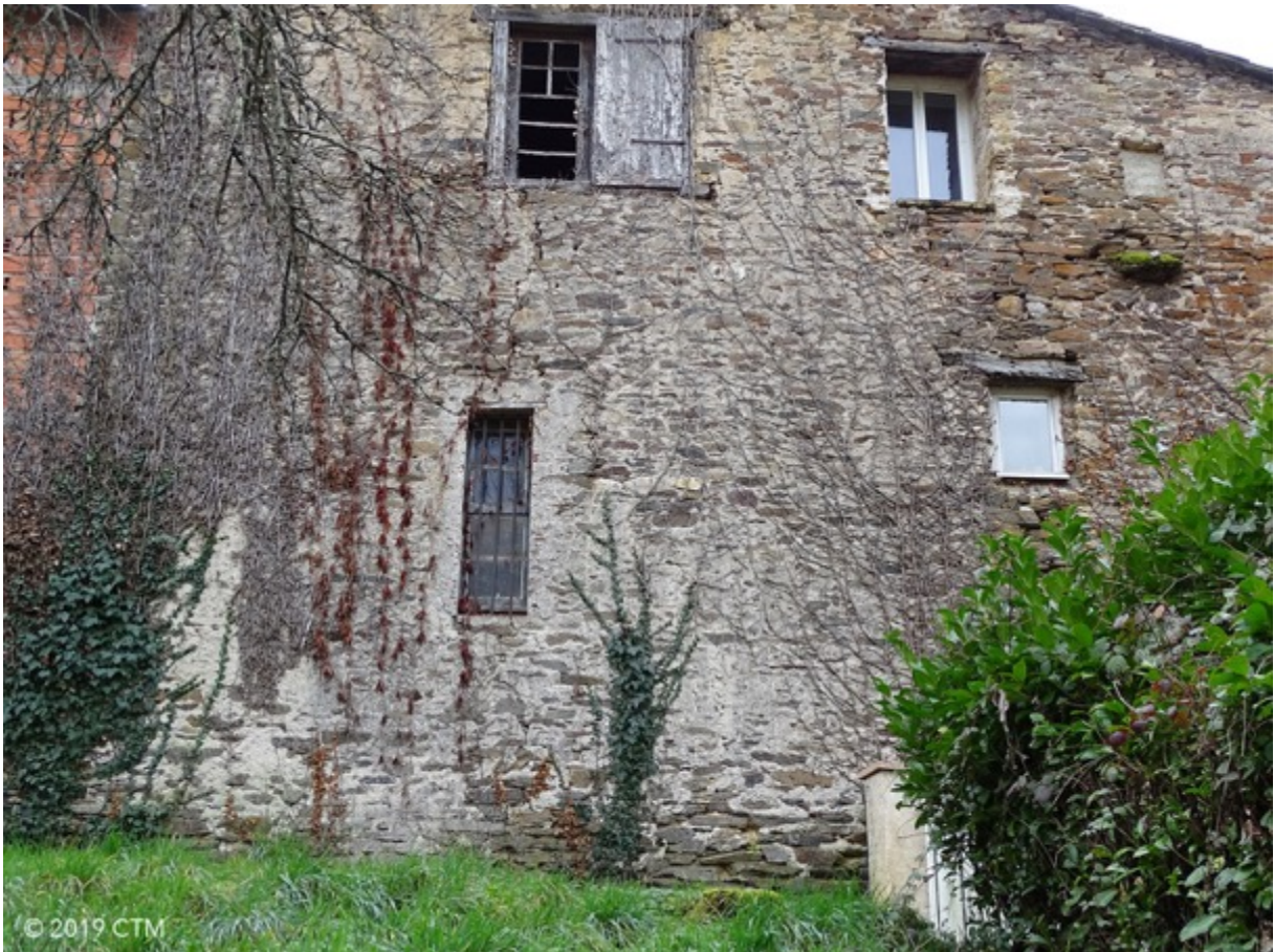
Fig. 234. Marsal, réduit collectif, portion septentrionale de la muraille.
