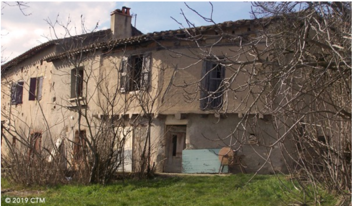
Fig. 296. Puygouzon, alignement des maisons du bourg subordonné au château (faubourg bas médiéval).
