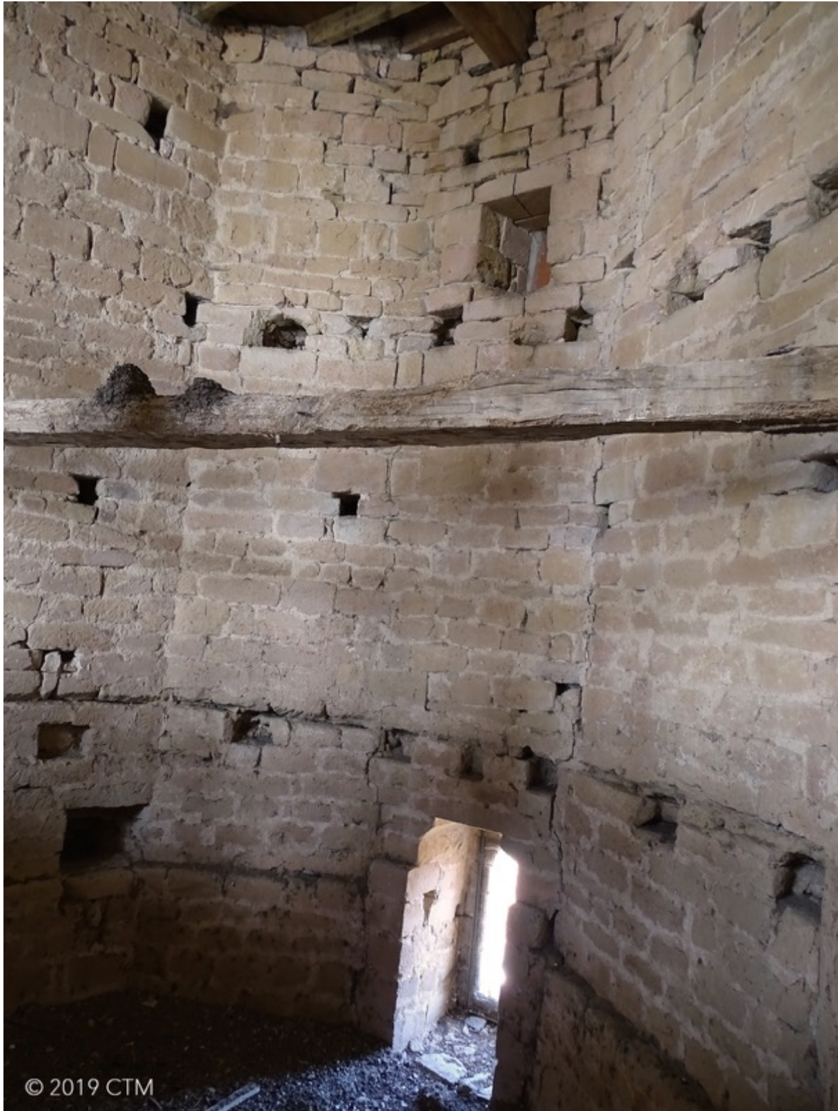
Fig. 95. Dénat, clocher fortifié, renforcements des solives des planchers des salles hautes (extension pentagonale).
