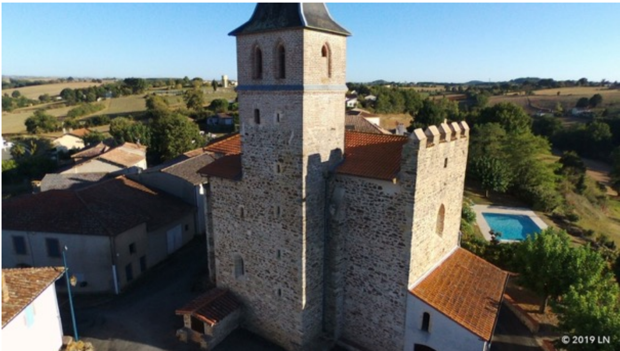
Fig. 61. Église Saint-Pierre de Cambon, parapet crénelé et tour en saillie sur la nef percée d'ouvertures de tir (prise de vue aérienne par drone, Laurent Nion).
