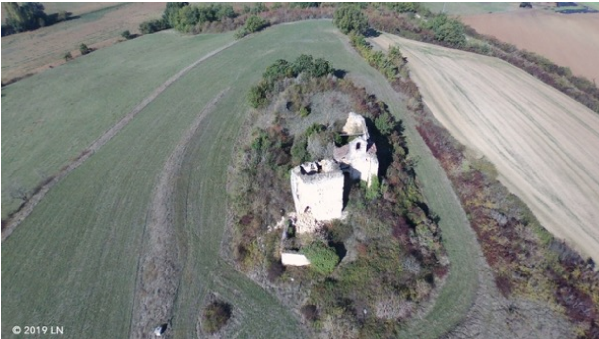
Fig. 246. Château de Montsalvy assis sur une butte oblongue (prise de vue aérienne par drone, Laurent Nion).
