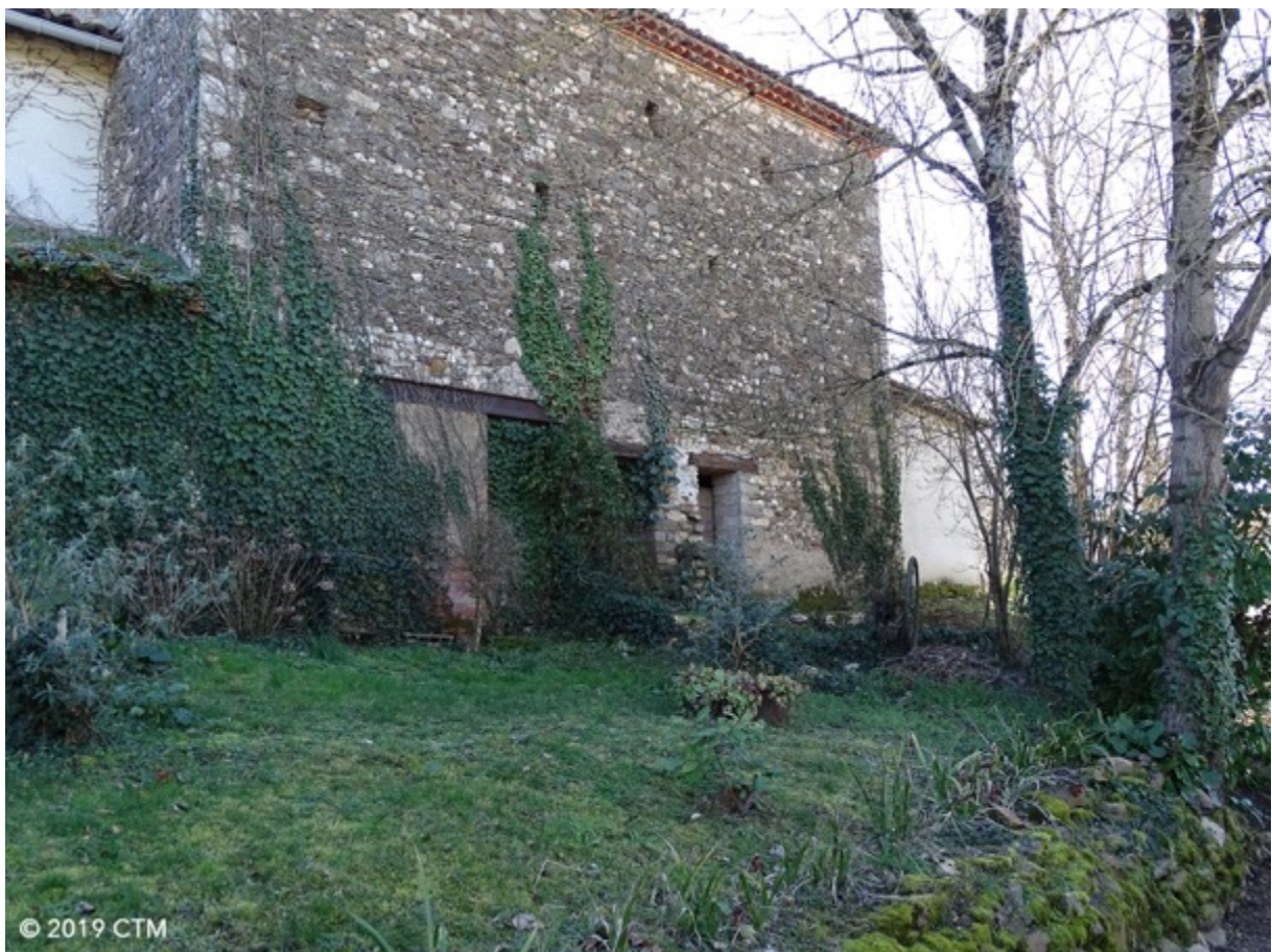
Fig. 266. Mouzieys, escarpe de la frange septentrionale du fossé du réduit.
