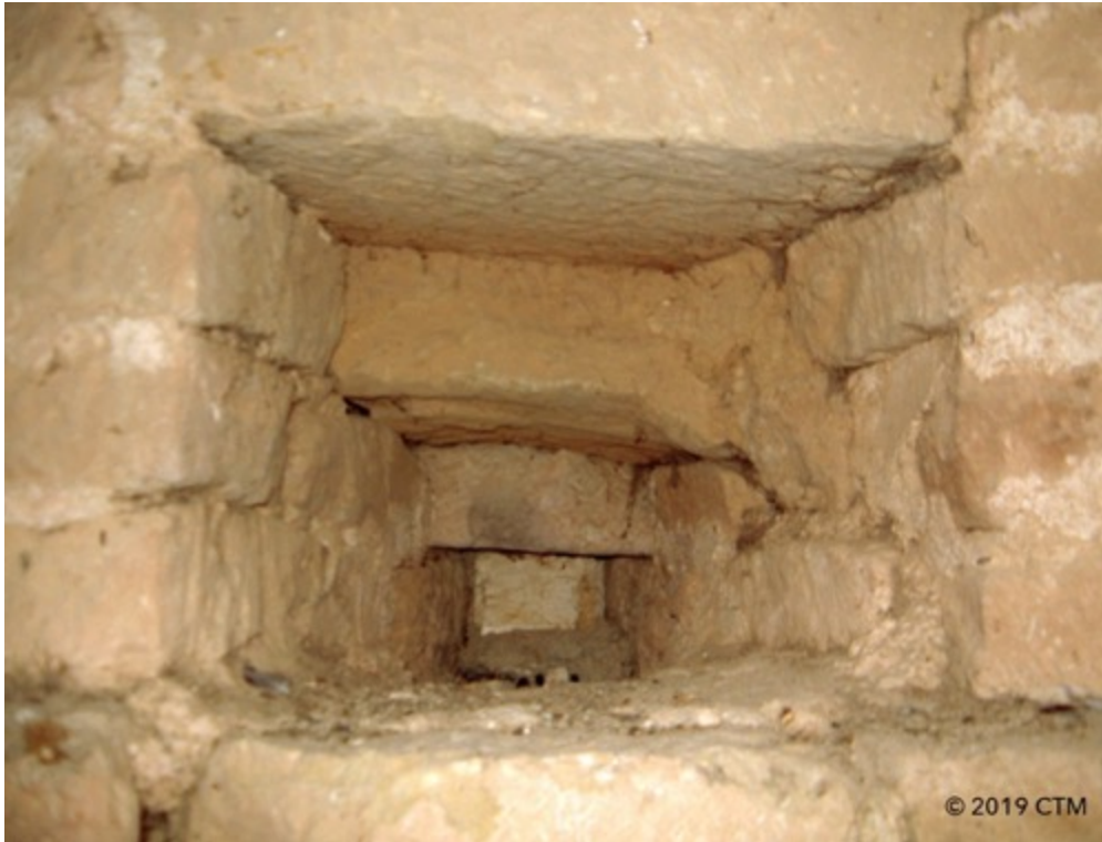
Fig. 96. Dénat, clocher fortifié, ouverture de tir obturée.
