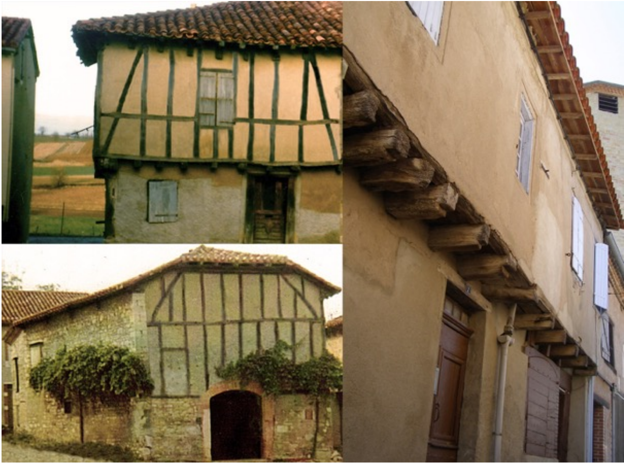
Fig. 86. Dénat, maisons à pans de bois et remplissage de terre.
