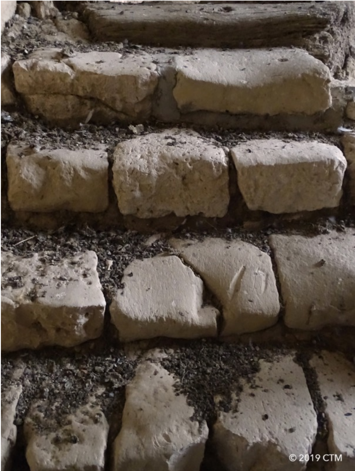
Fig. 102. Dénat, clocher fortifié, emmarchement de desserte des salles hautes.
