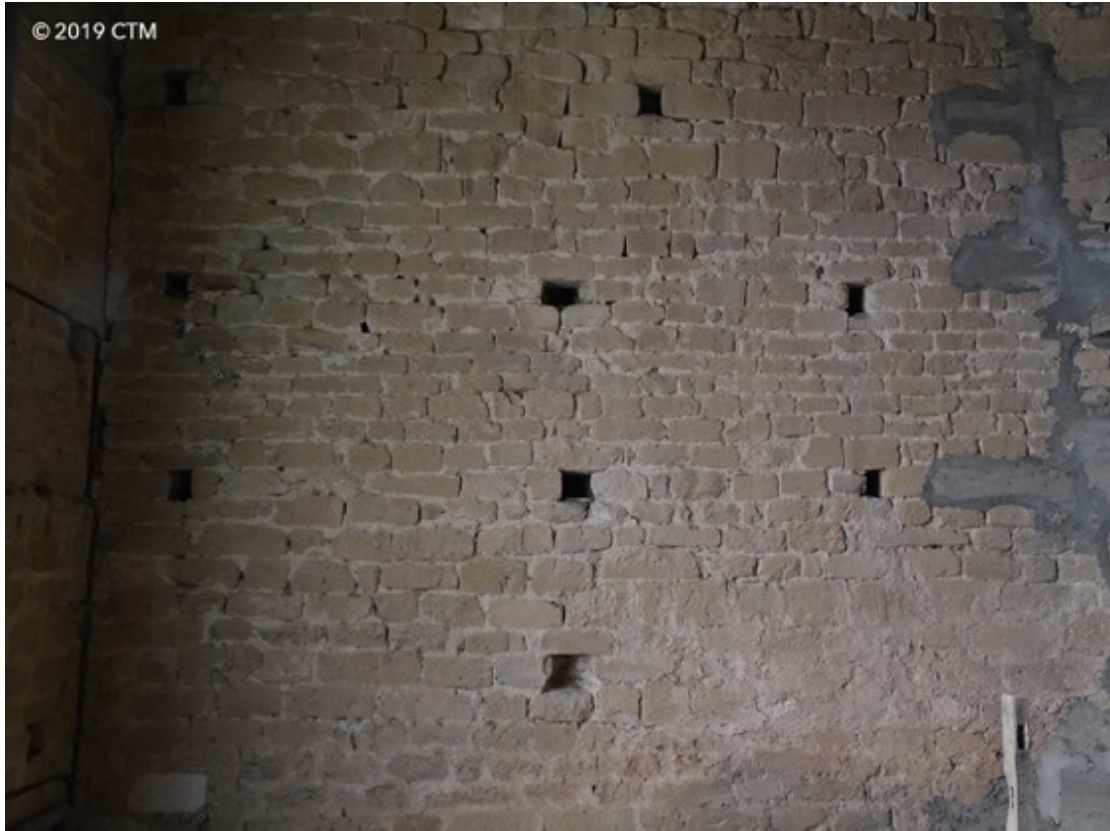
Fig. 98. Dénat, clocher fortifié, lignes de renforcements (mur septentrional).
