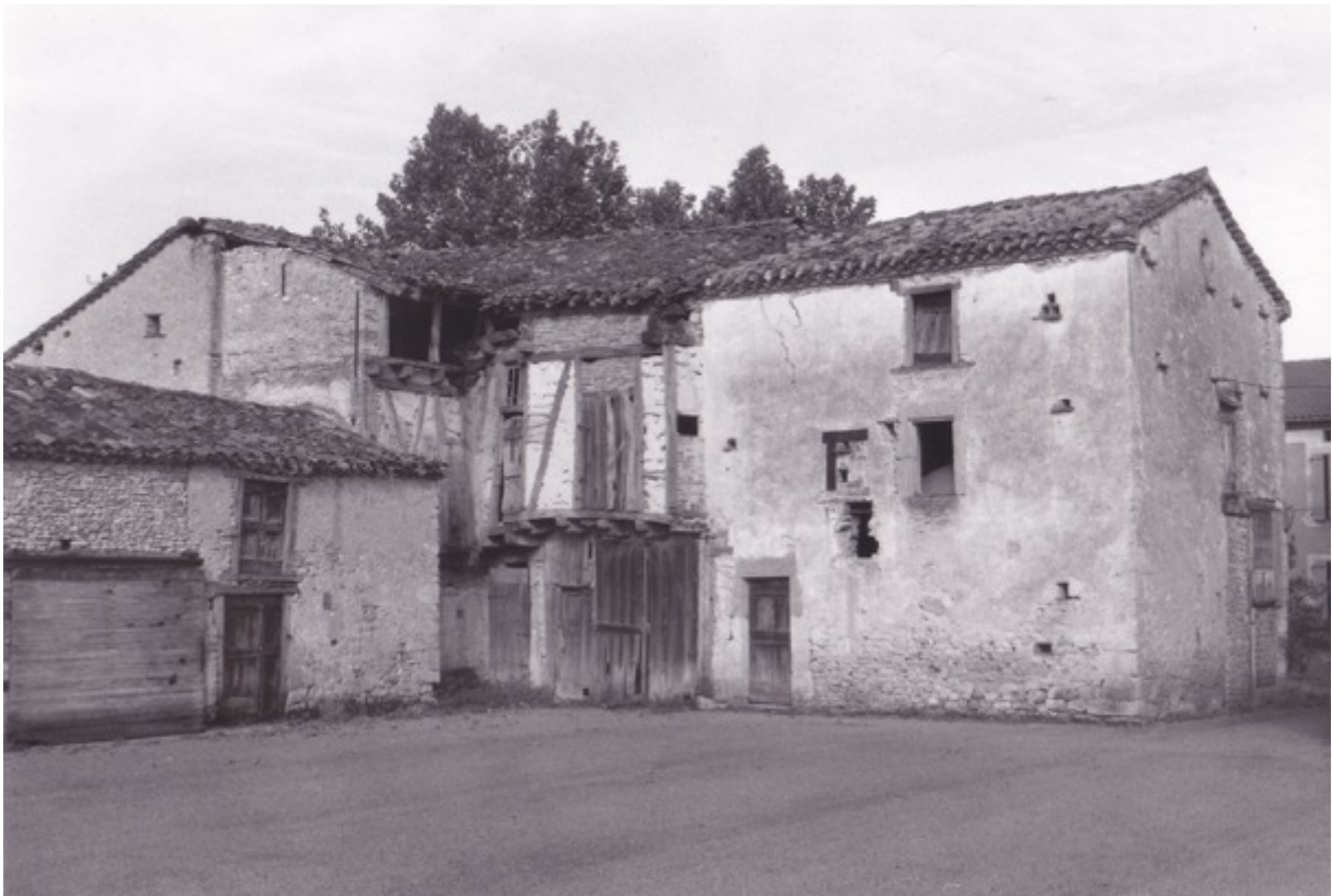
Fig. 119. Fénols, réduit collectif, angle occidental interne (cliché, Jean Gasc).
