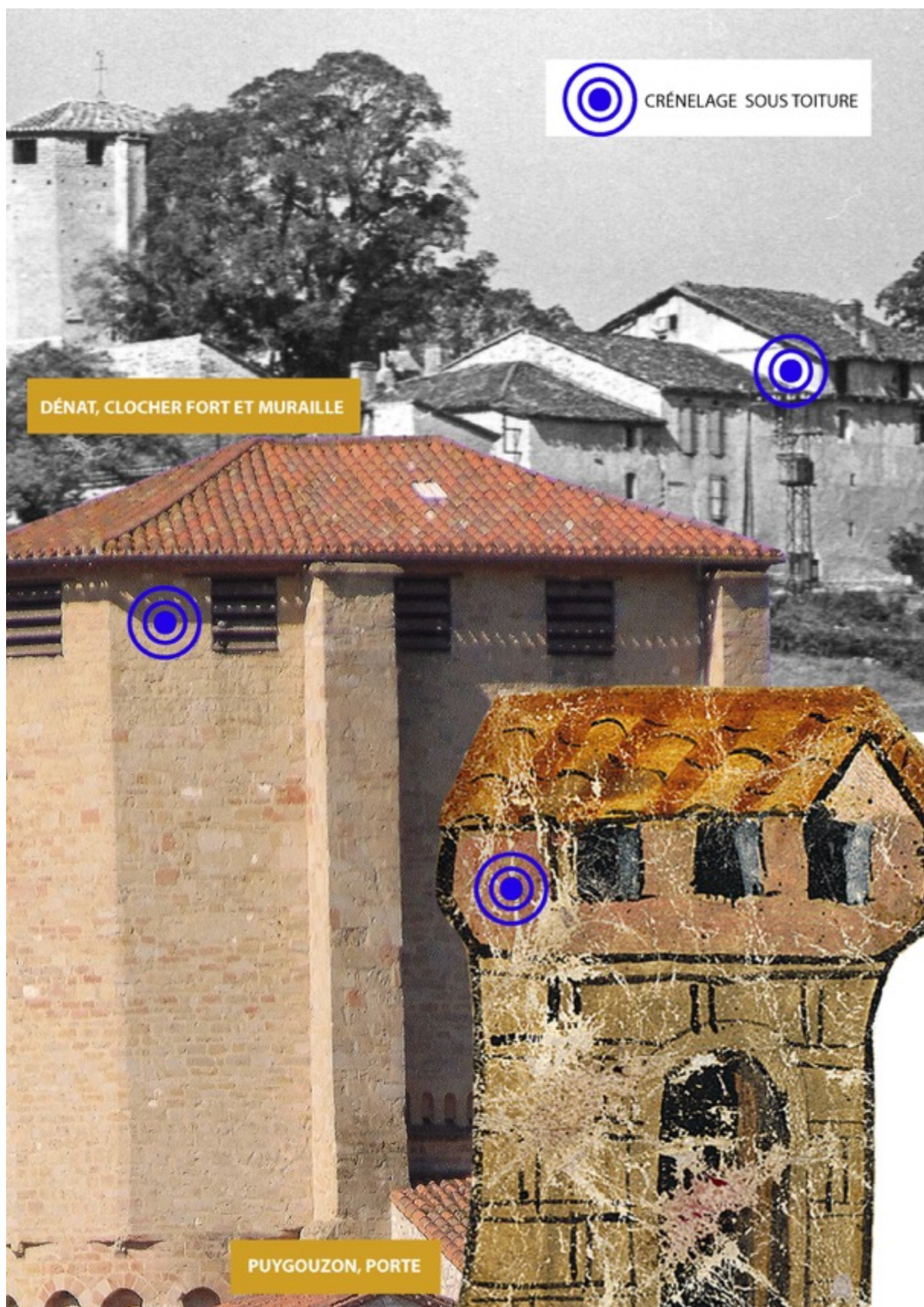
Fig. 338. Ouvertures rectangulaires sur les dispositifs sommitaux de défense ( gache , clocher fort et avans ).
