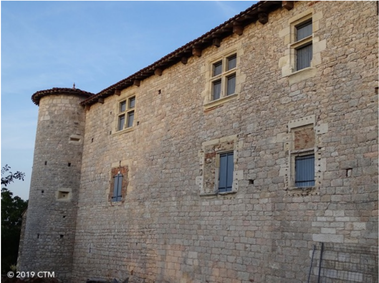
Fig. 131. Maison forte de Rayssac, corps de logis seigneurial.
