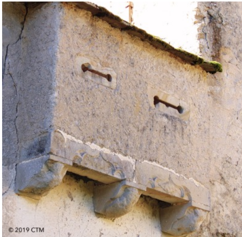
Fig. 76. Maison forte des Farguettes, bretèche du portail
