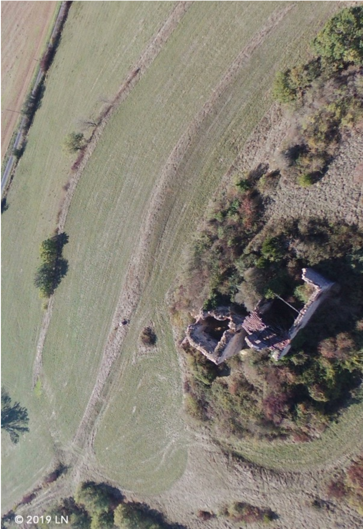
Fig. 258. Château de Montsalvy, vestiges de la tour maîtresse et du corps de logis (prise de vue aérienne par drone, Laurent Nion).
