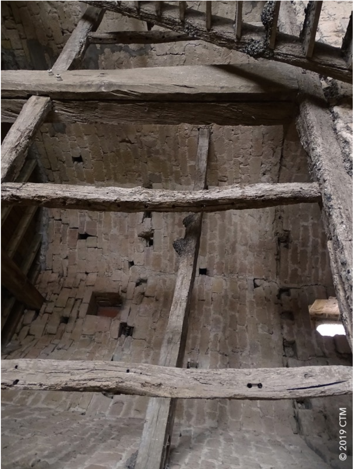
Fig. 94. Dénat, clocher fortifié, pans de bois de la cloison médiane.
