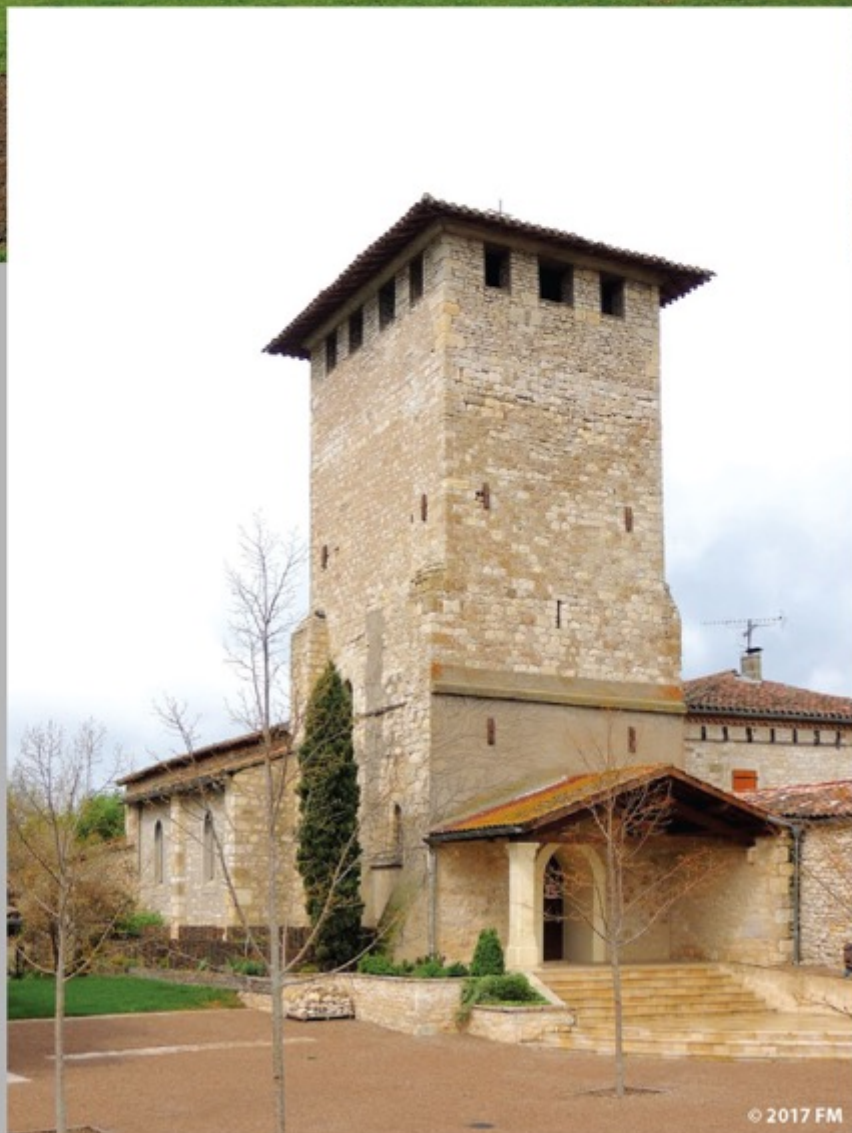
Fig. 16. Église forte Saint-Benoît de Sainte-Croix (Tarn).
