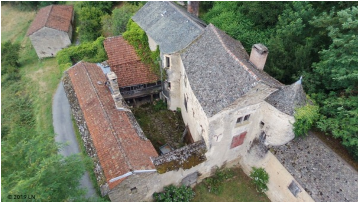
Fig. 73. Maison forte des Farguettes, cour centrale (prise de vue aérienne par drone, Laurent Nion).
