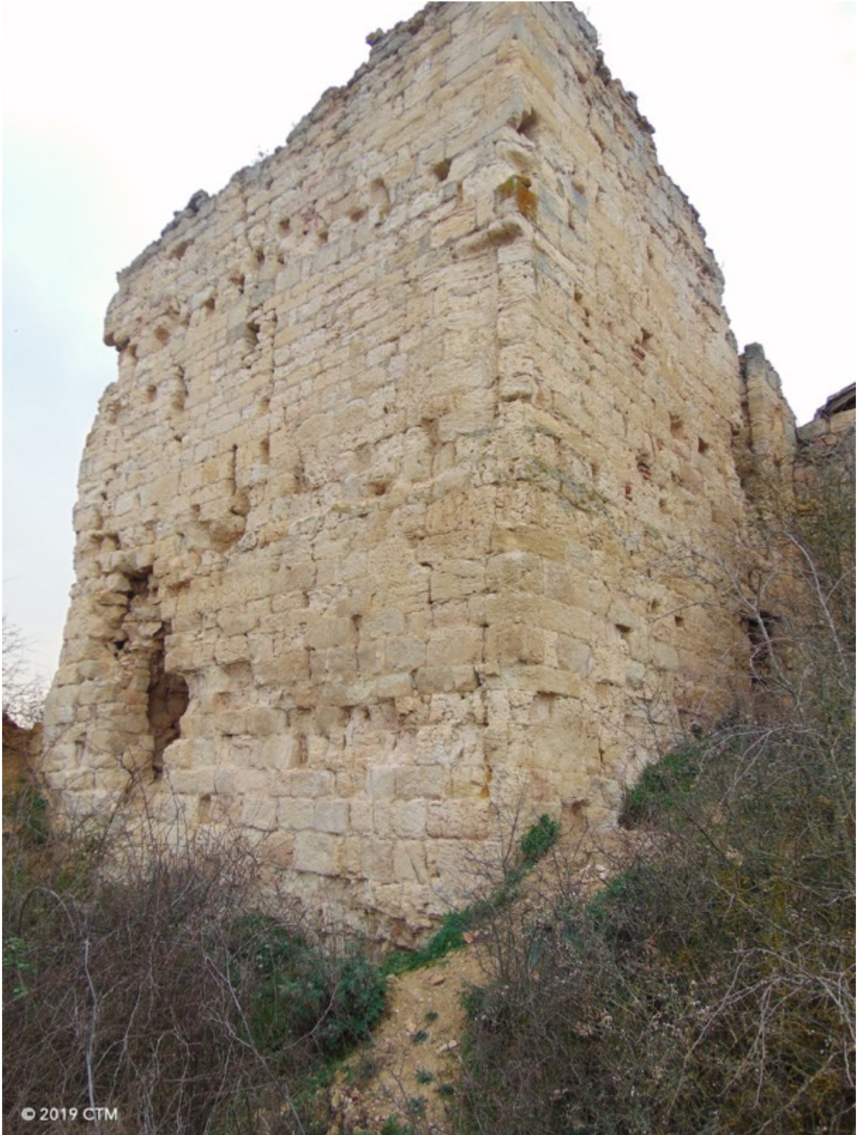
Fig. 256. Château de Montsalvy, tour maîtresse.
