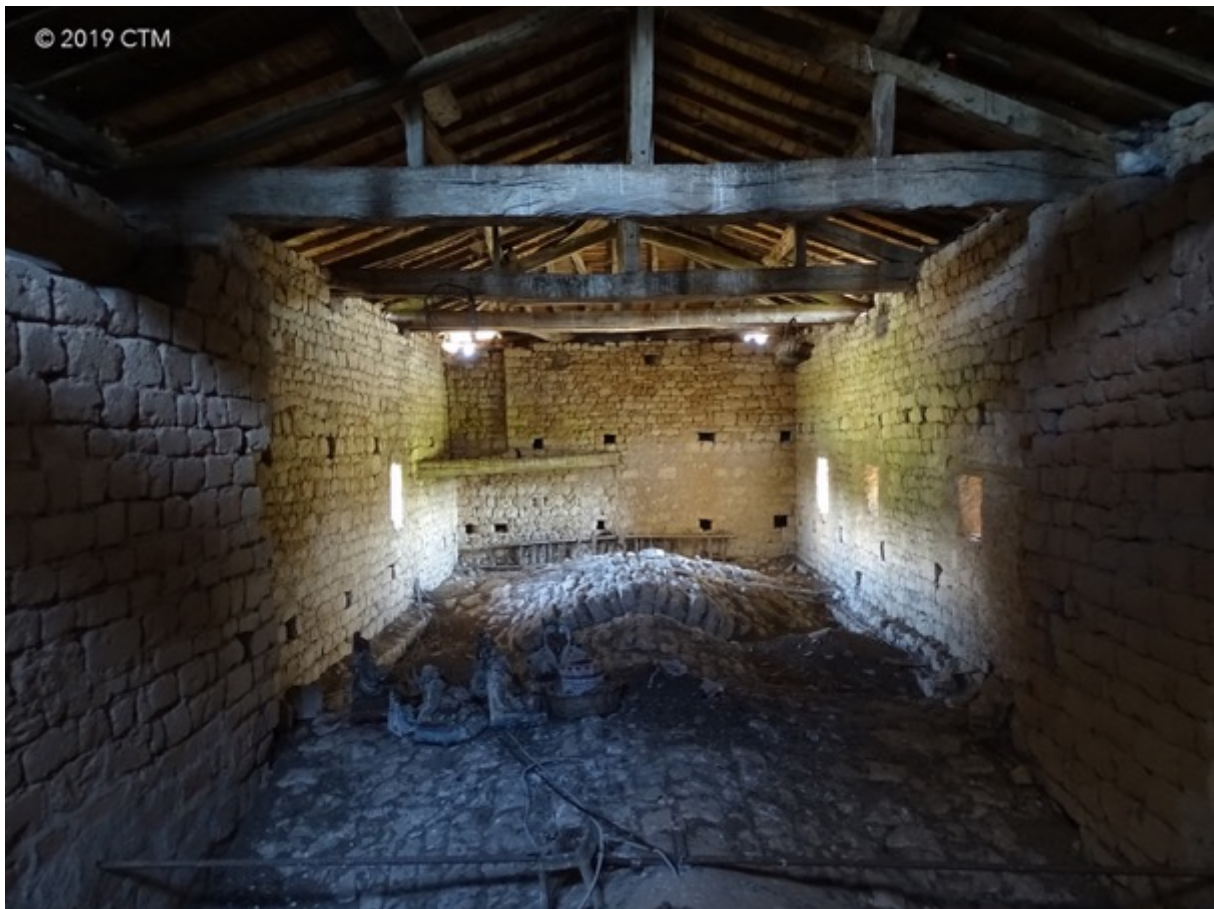
Fig. 196. Léjos, église Saint-André, espace de refuge et d'entreposage aménagé sur l' extrados de la voûte de la nef.
