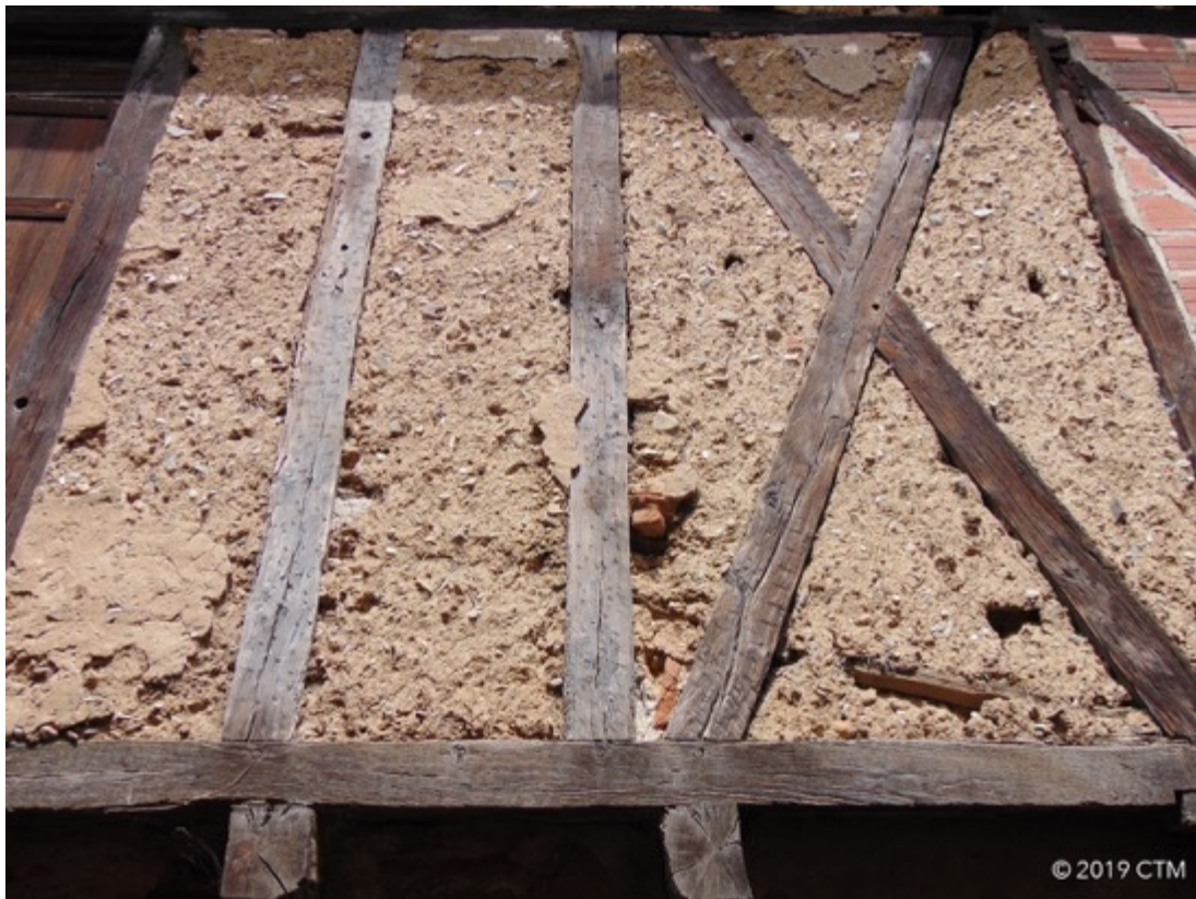
Fig. 216. Les Avalats, pans de bois, remplissage de terre et de graviers de rivière.
