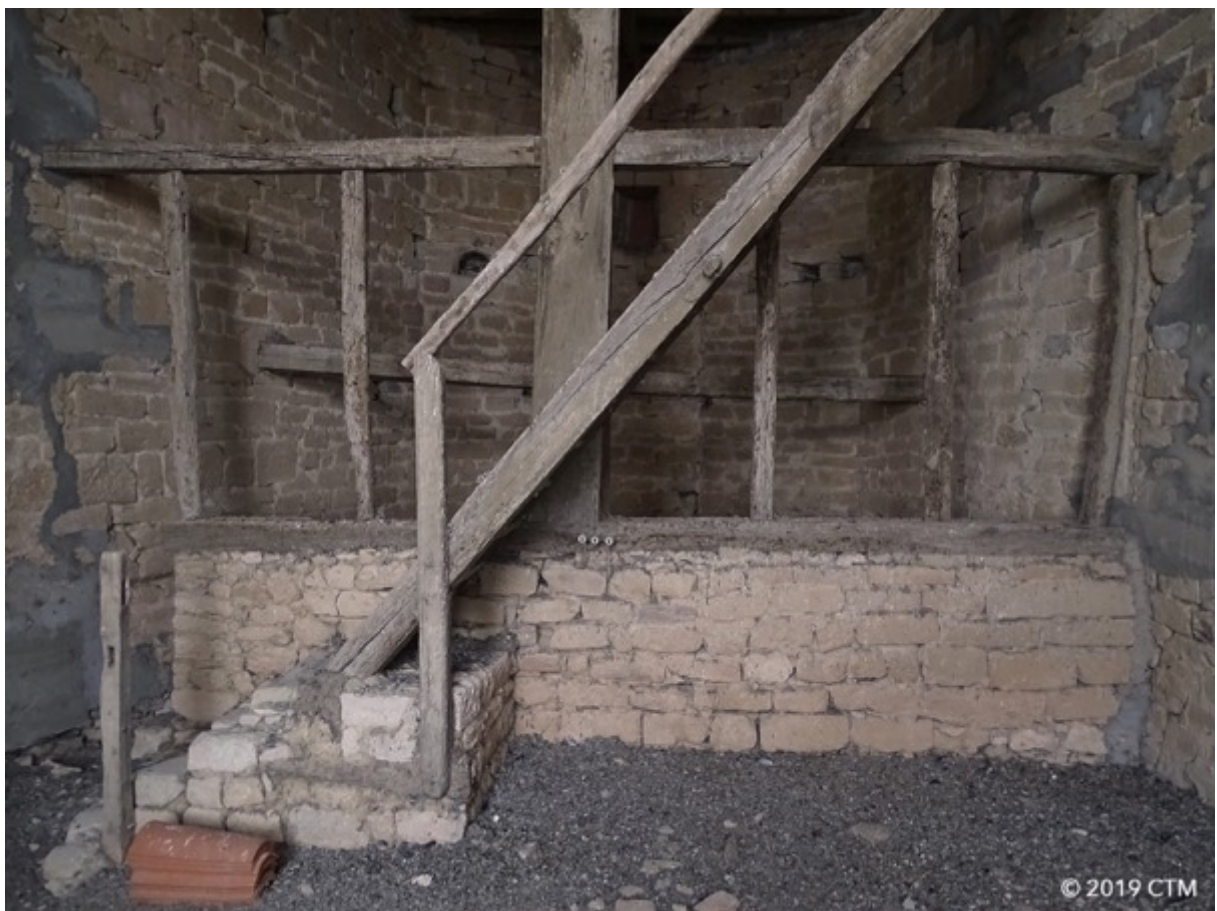
Fig. 93. Dénat, clocher fortifié, vestiges de la cloison à ossature de bois et remplissage de terre.
