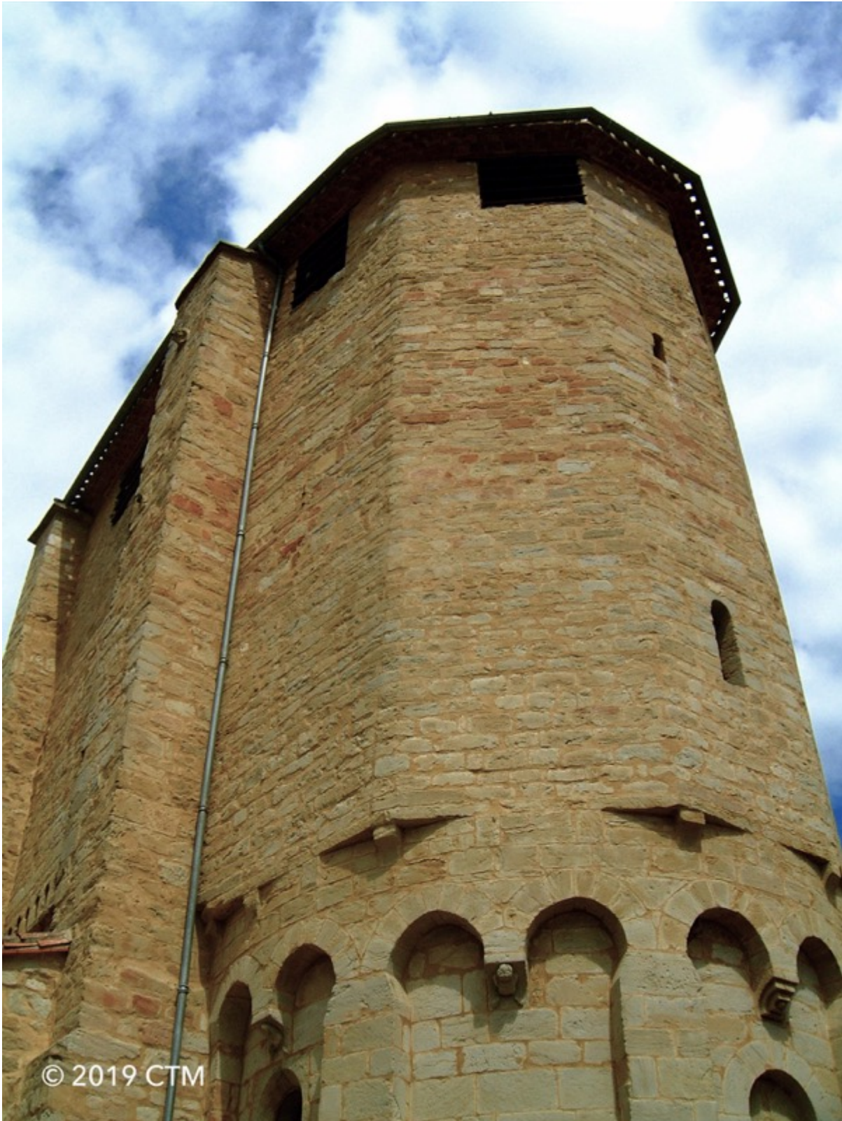
Fig. 104. Dénat, clocher fortifié, crénelage sous toiture, face est.
