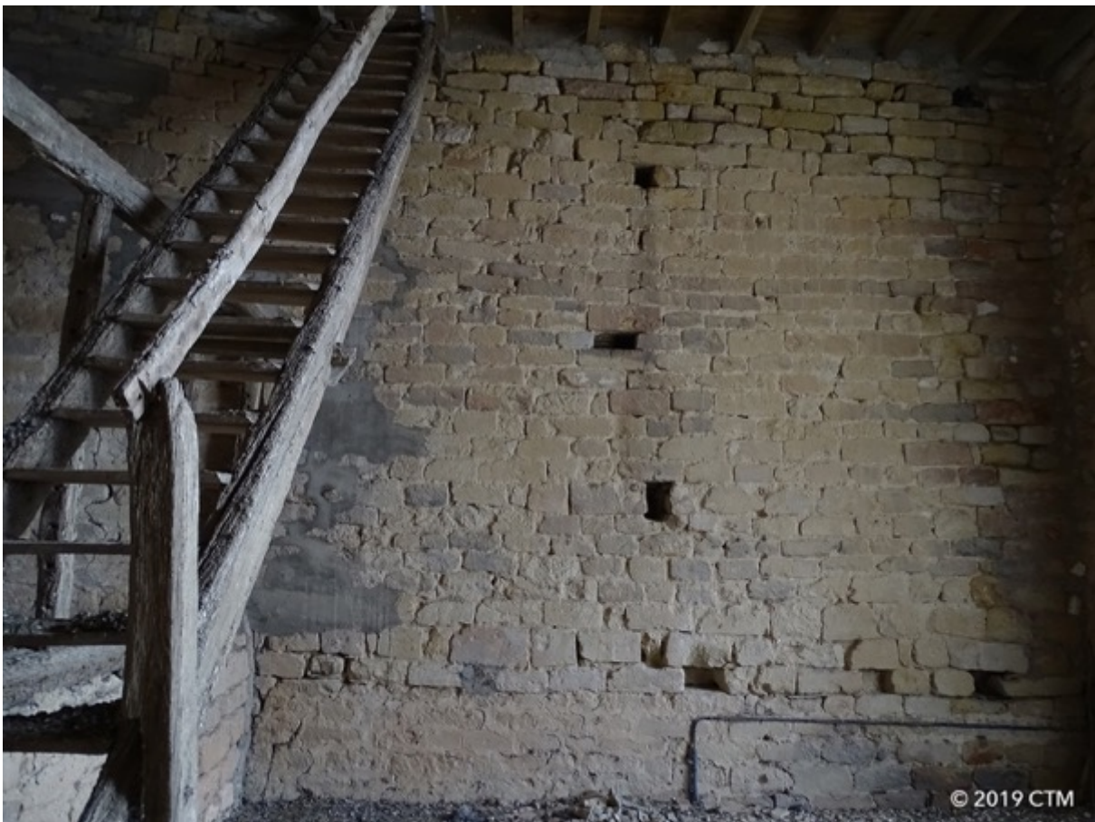
Fig. 97. Dénat, clocher fortifié, lignes de renforcements (mur méridional).
