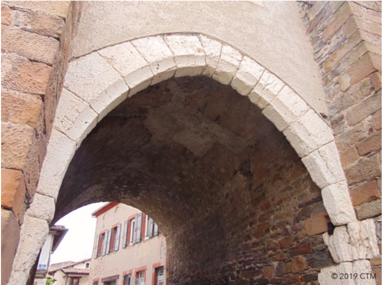
Fig. 204. Les Avalats, arc d'entrée de la porte, claveaux en pierre calcaire.
