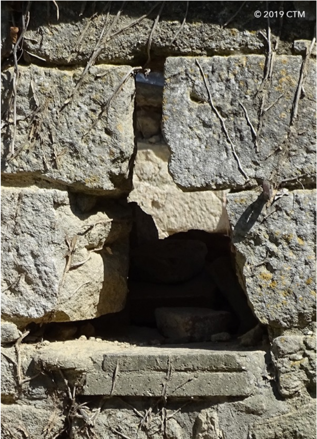
Fig. 126. Fénols, réduit collectif, muraille nord-ouest, ouverture de tir.
