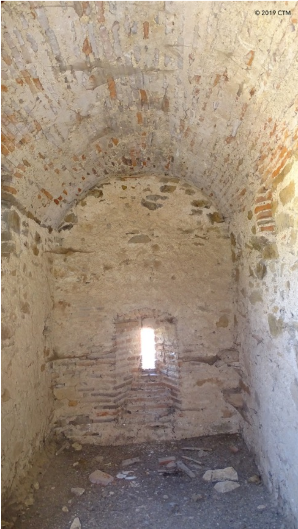
Fig. 62. Église Saint-Pierre de Cambon, salle haute aménagée sur l' extrados de la voûte de la chapelle septentrionale.
