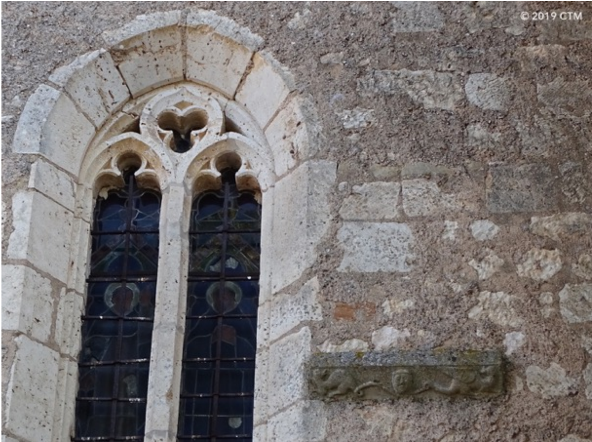
Fig. 114. Fauch, église Saint-Vincent, baie à ornementation trilobée.
