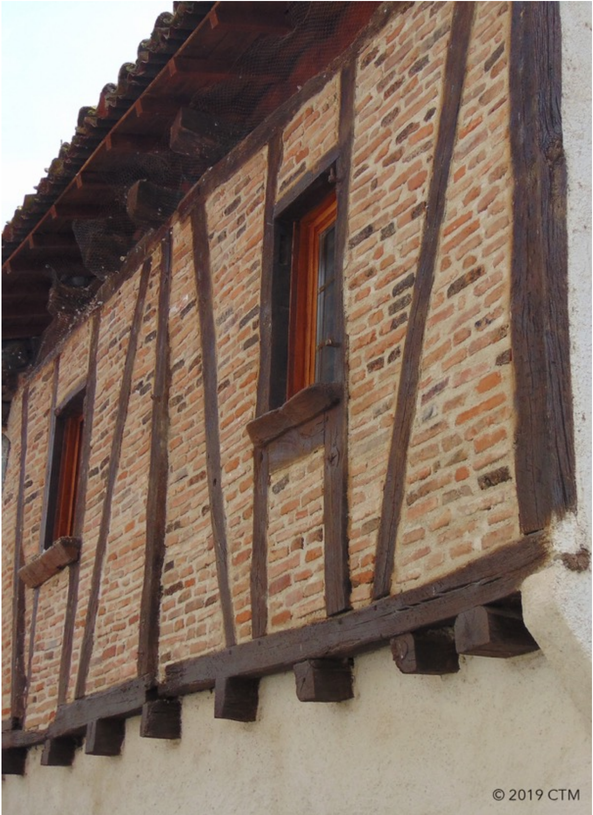
Fig. 221. Les Avalats, appuis de fenêtre en bois.
