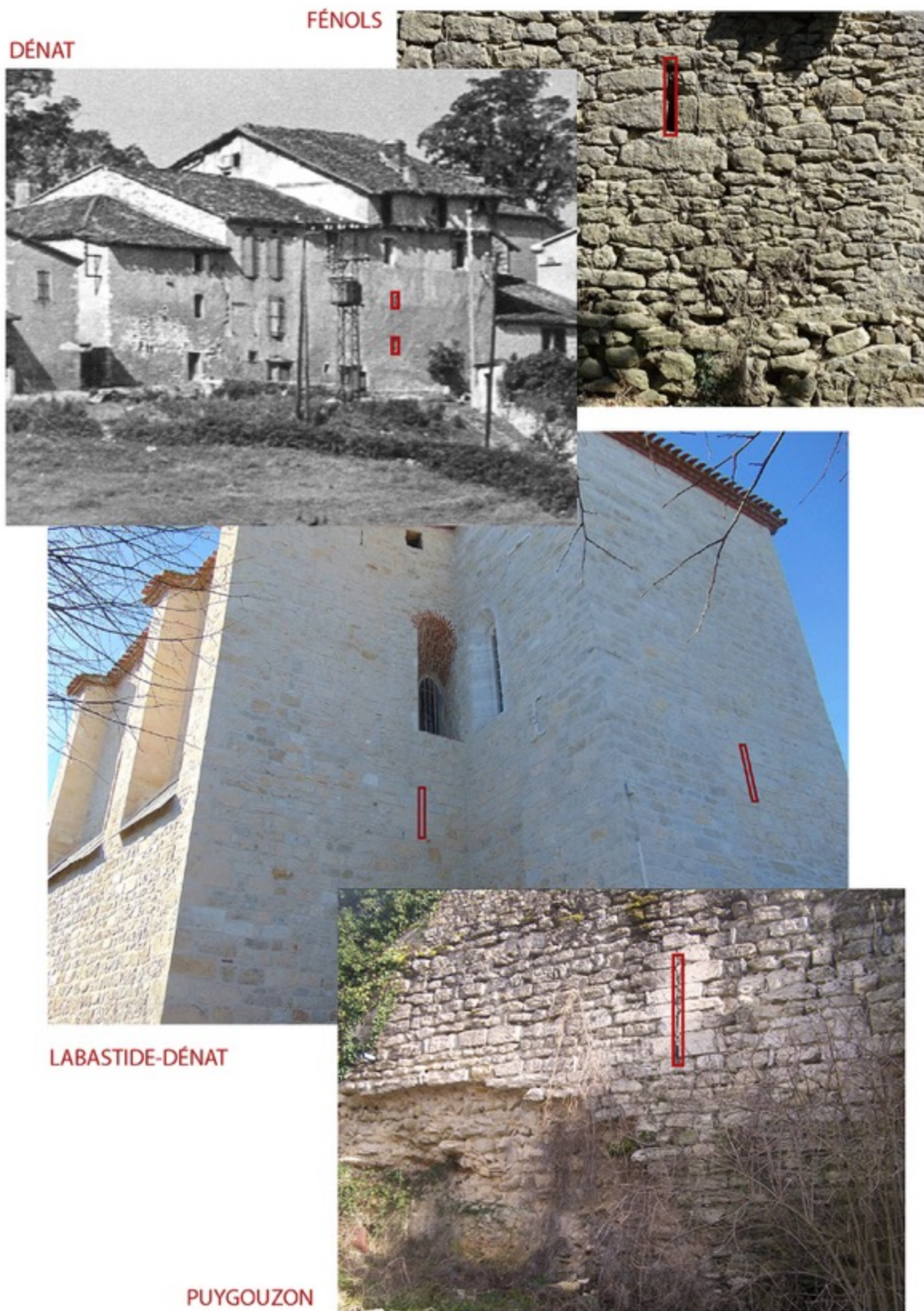
Fig. 334. Murailles collectives percées d'ouvertures de tir.
