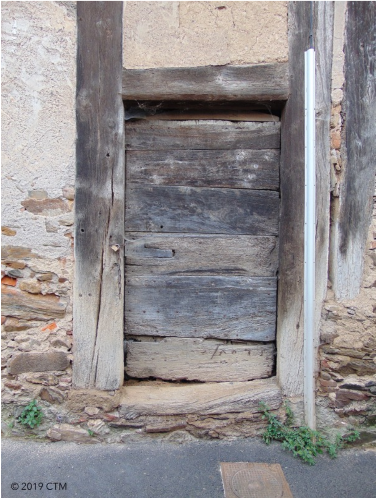
Fig. 220. Les Avalats, jambages et encadrement de porte en bois.
