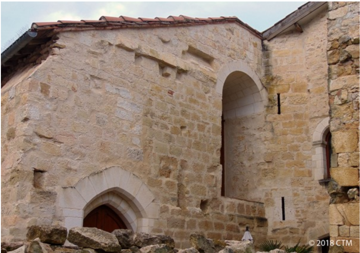
Fig. 152. Labastide-Débat, aula , tour de l'escalier à vis percée d'archères.
