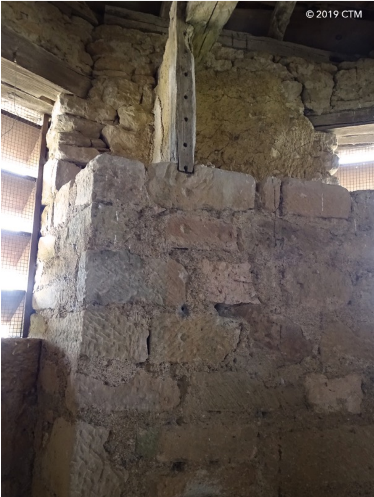
Fig. 101. Dénat, clocher fortifié, vestiges du cloisonnement sommital, renforcements du clayonnage pratiqués dans les moellons.
