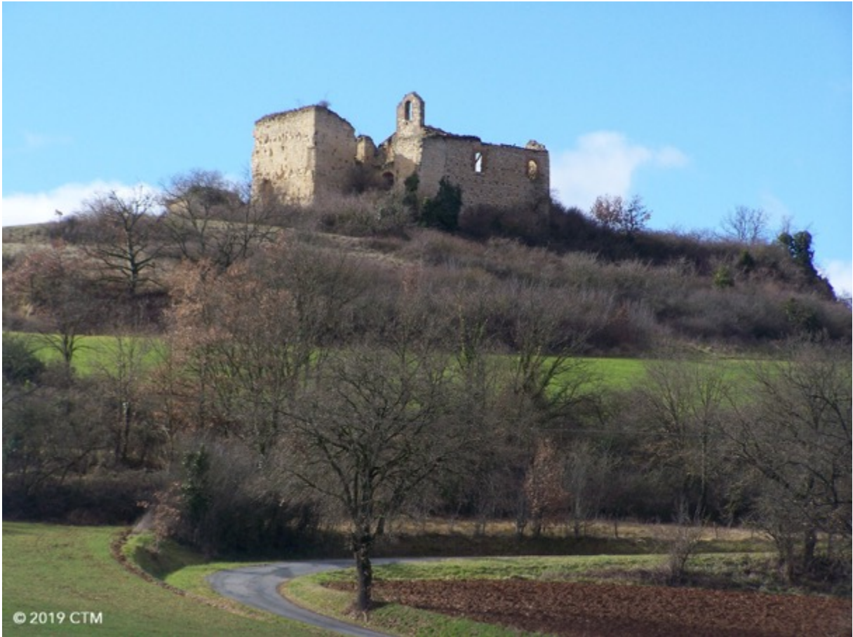
Fig. 245. Site du château de Montsalvy.
