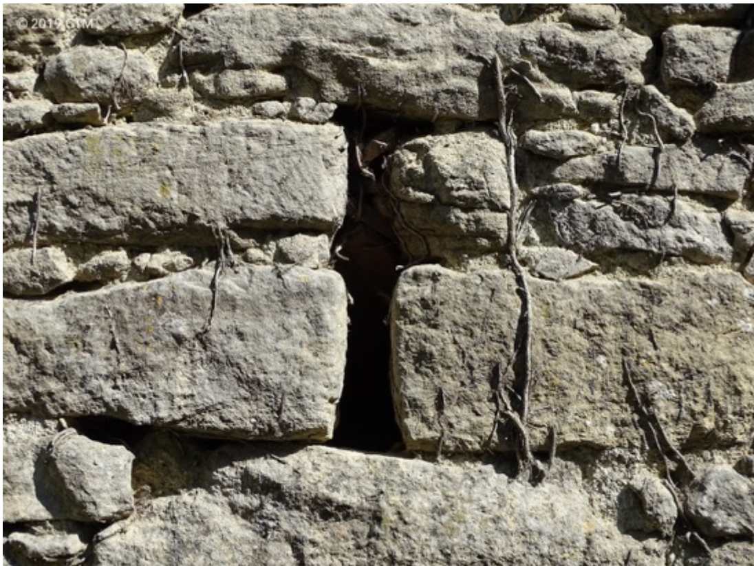
Fig. 125. Fénols, réduit collectif, muraille nord-ouest, ouverture de tir.
