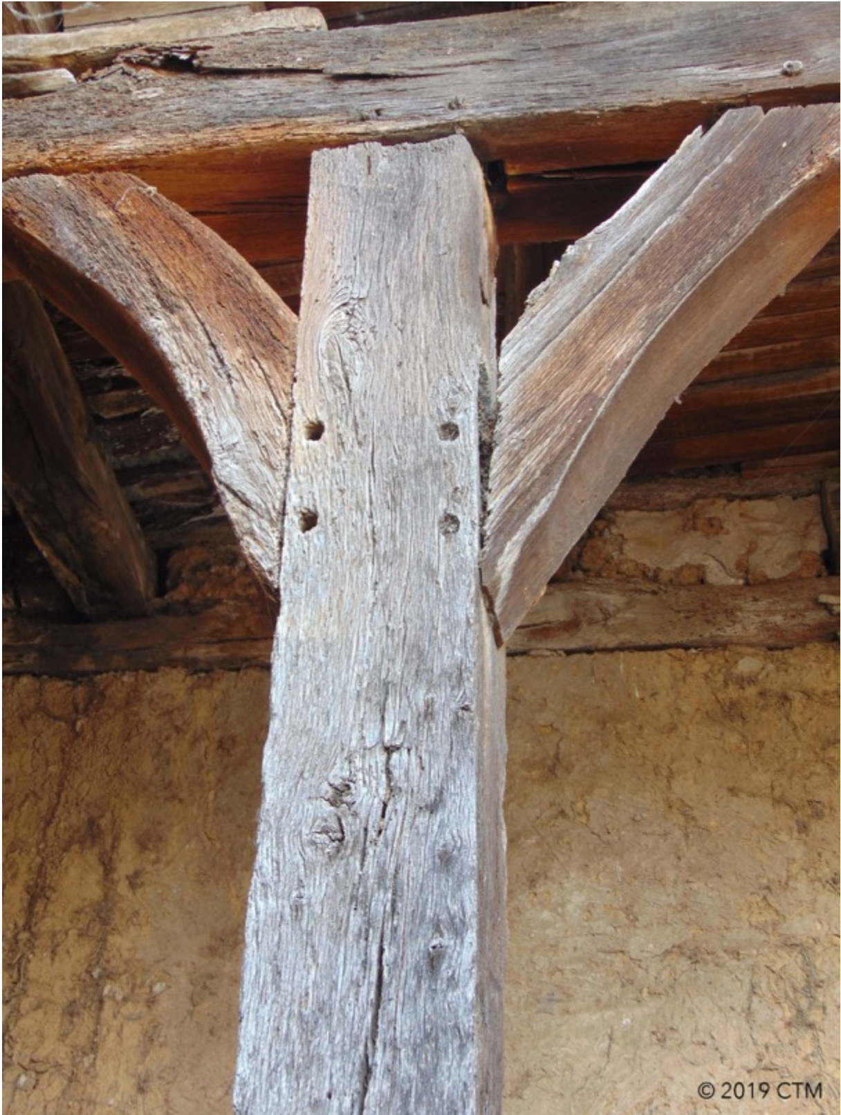
Fig. 219. Les Avalats, pilier de soutènement en bois.
