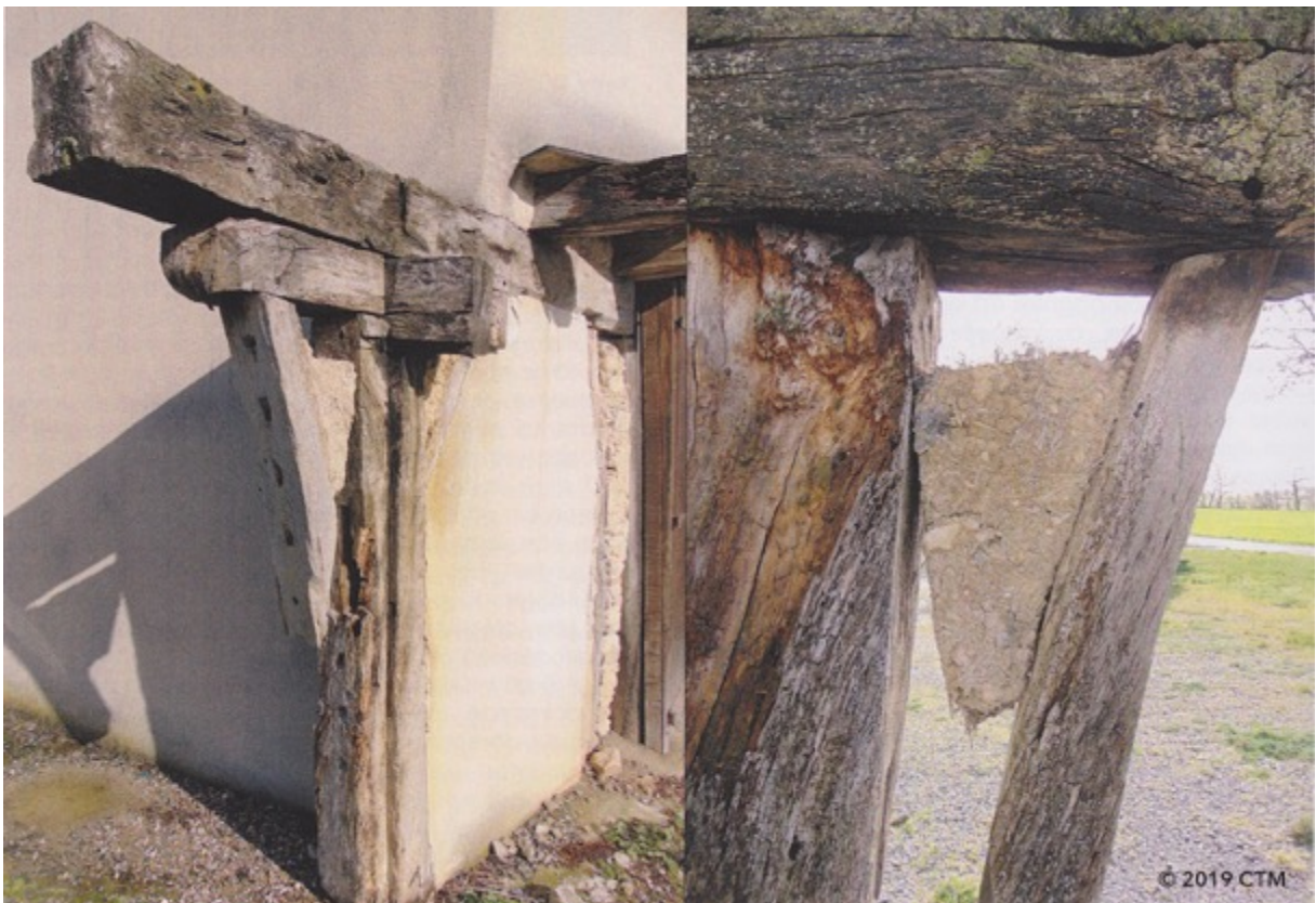
Fig. 121. Férols, réduit collectif, vestiges de la structure à pans de bois et remplissage de terre d'un module de refuge et d'entreposage.
