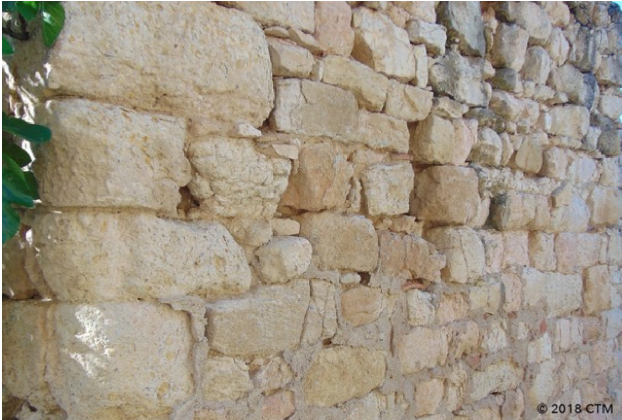
Fig. 140. Labastide-Débat, maison de la Gleye , chaînage d'angle.
