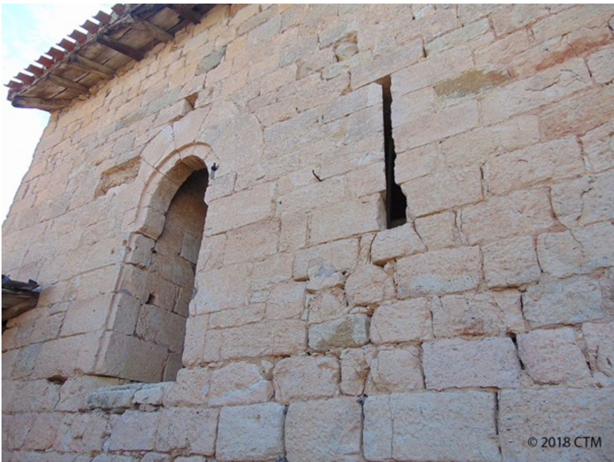
Fig. 145. Labastide-Débat, tour maîtresse, baie en plein cintre et archère à étrier.
