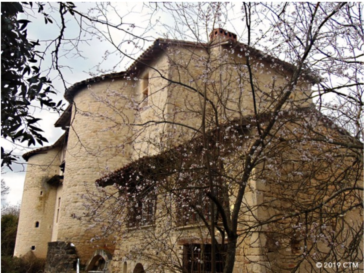
Fig. 280. Maison forte de Poulan flanquée de tours circulaires.
