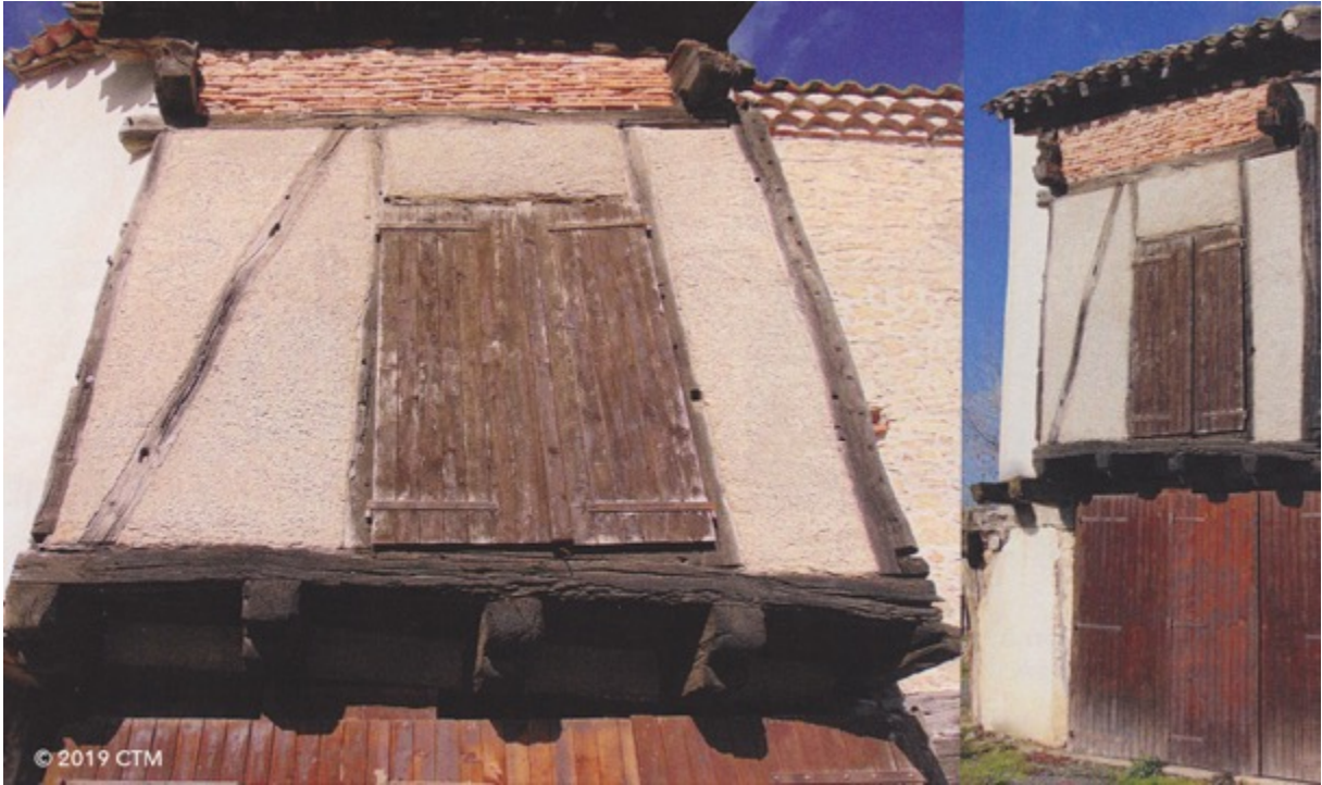
Fig. 120. Férols, réduit collectif, unité bâtie en encorbellement à pans de bois.
