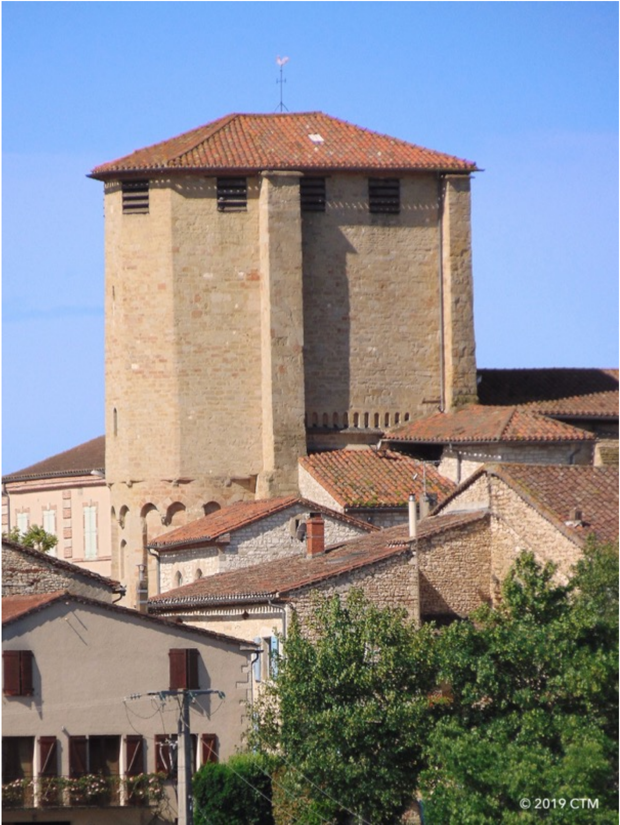
Fig. 105. Dénat, clocher fortifié, crénelage sous toiture, face nord.
