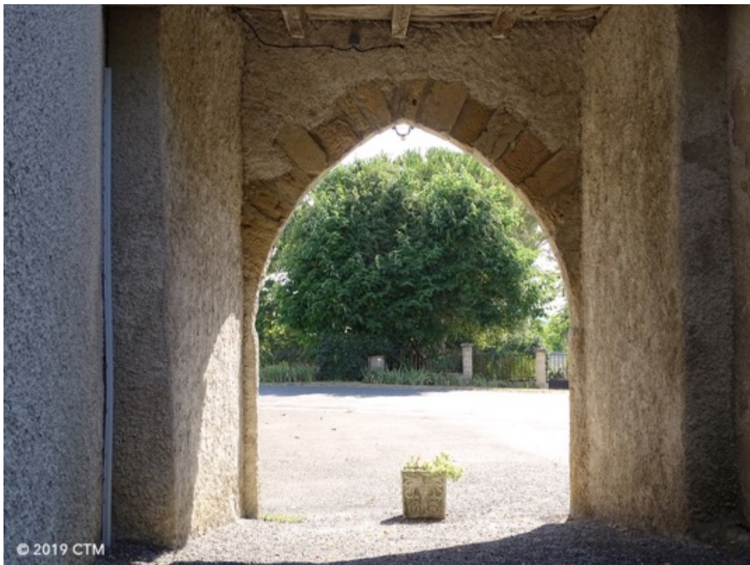
Fig. 271. Orban, réduit communautaire, entrée de la porte, vue intérieure.
