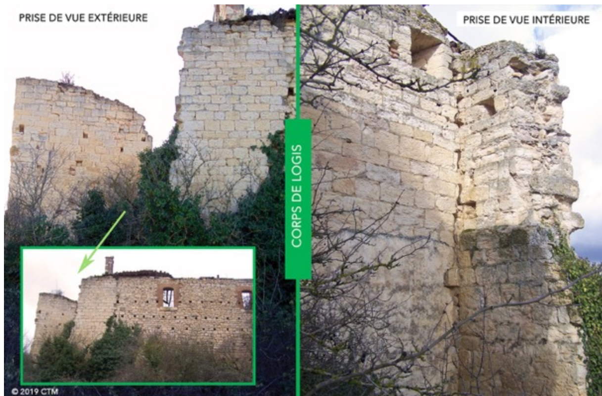
Fig. 249. Château de Montsalvy, corps de logis.
