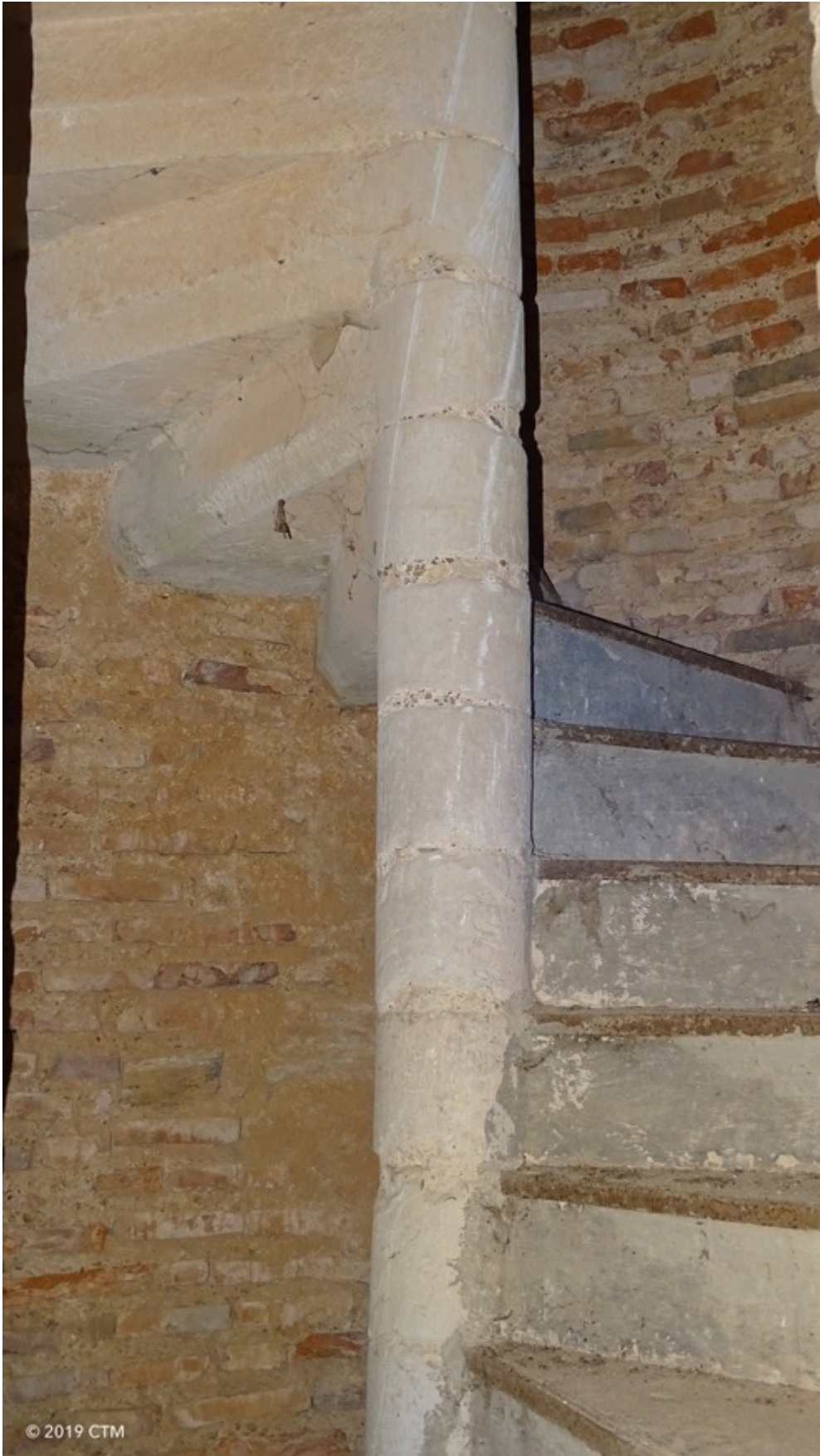
Fig. 63. Église Saint-Pierre de Cambon, escalier à vis de la tour percée d'ouvertures de tir.
