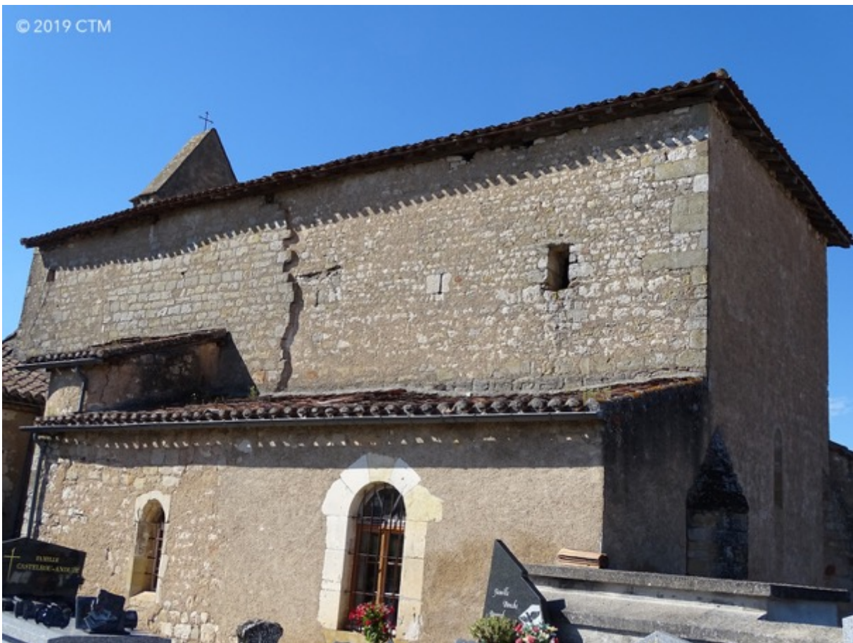
Fig. 194. Léjos, église Saint-André, reprise de maçonnerie.
