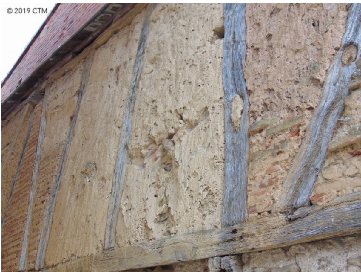
Fig. 217. Les Avalats, pans de bois, remplissage de terre et de schiste.
