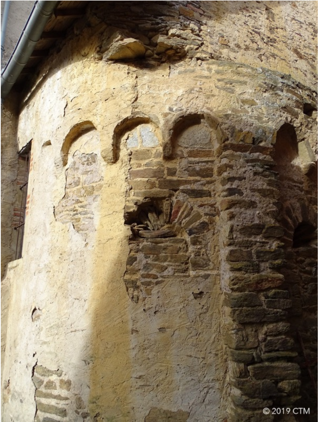
Fig. 232. Marsal, réduit collectif, église Saint-Pierre, vestiges d'un module bâti sur l'abside.
