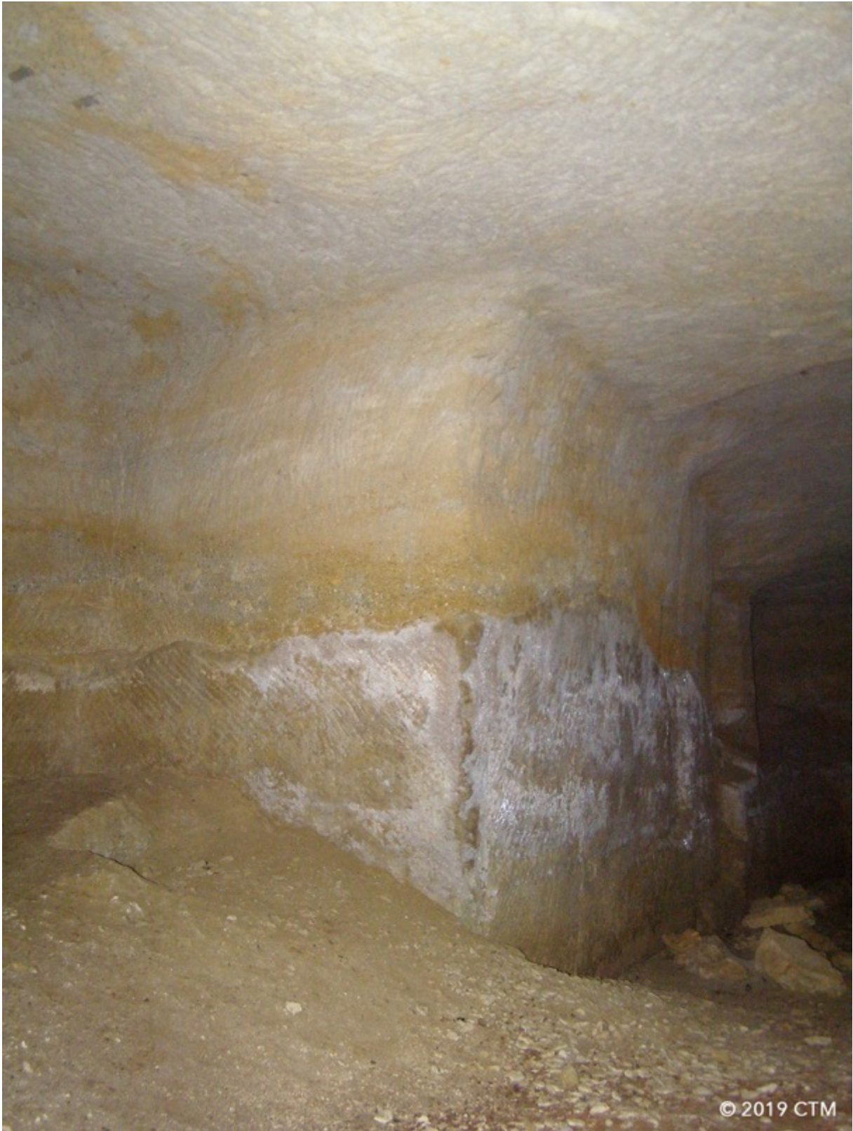
Fig. 302. Ronel, carrières souterraines.
