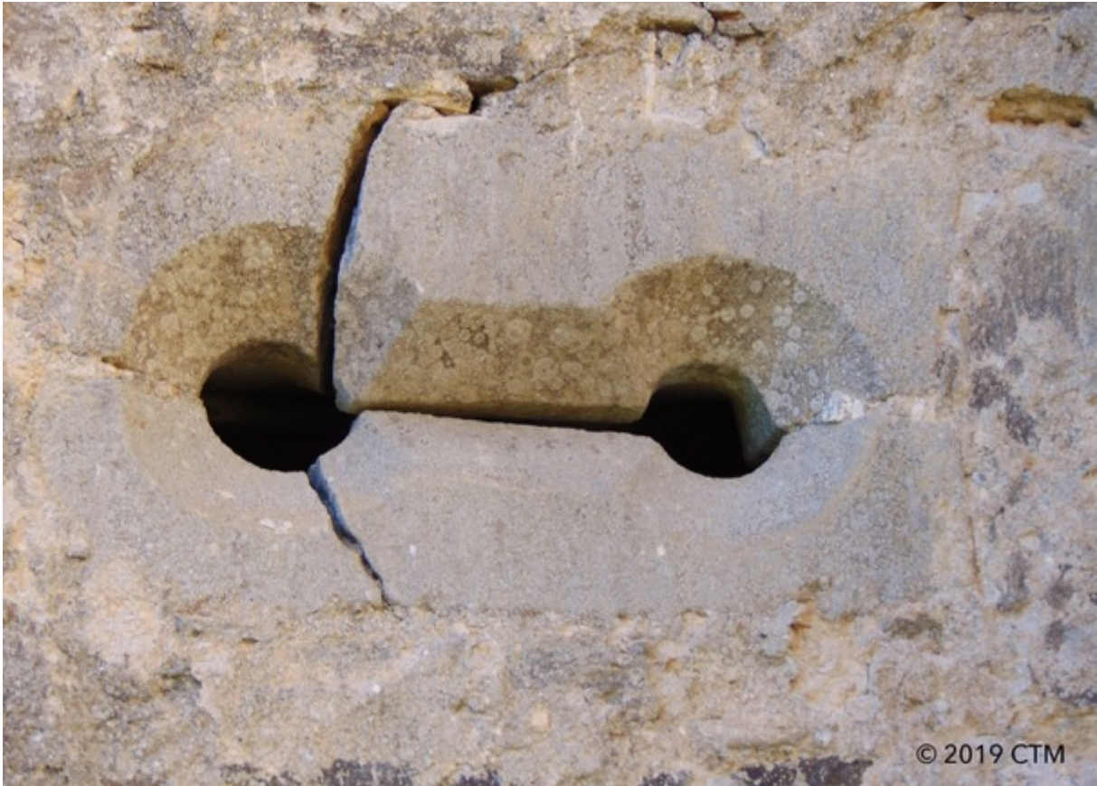
Fig. 77. Maison forte des Farguettes, flanc nord-est du corps de logis, ouverture de tir.
