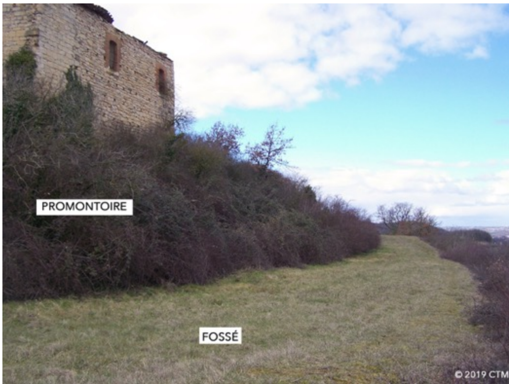
Fig. 260. Montsalvy, frange orientale du fossé.
