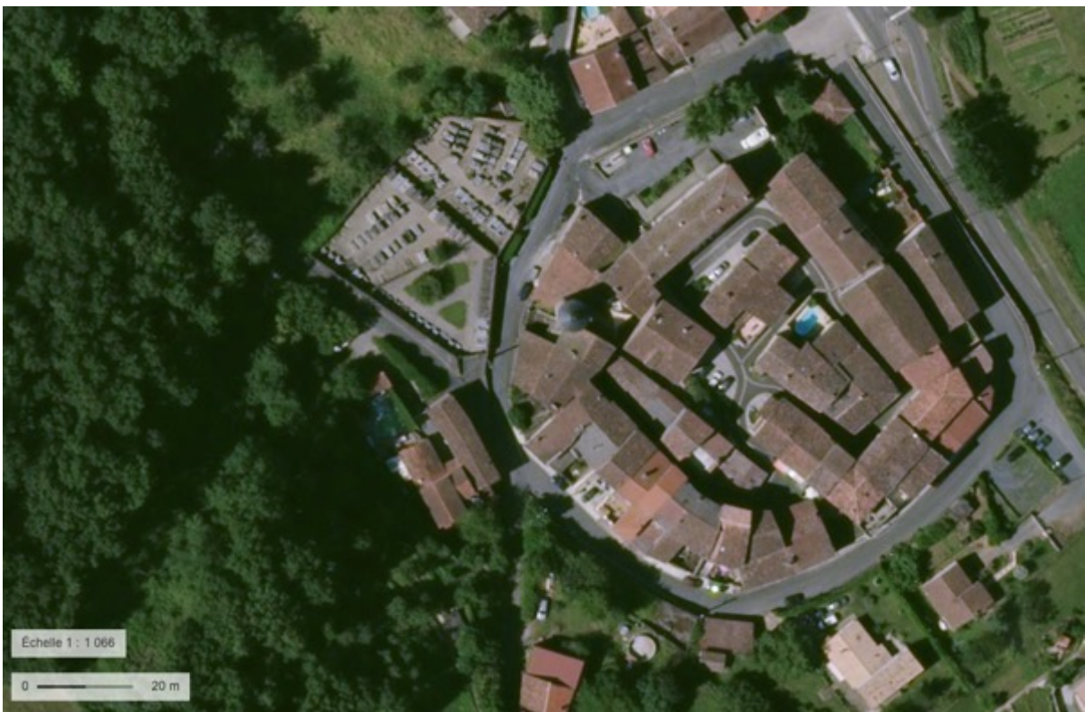
Fig. 205. Les Avalats, vue aérienne (IGN, FEDER, Région Occitanie), rangée de maisons édifiées dans le fossé (versants sud-ouest, sud et sud-est).
