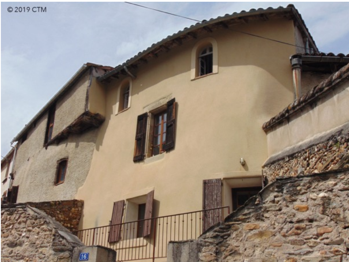
Fig. 201. Les Avalats, muraille collective, frange méridionale.
