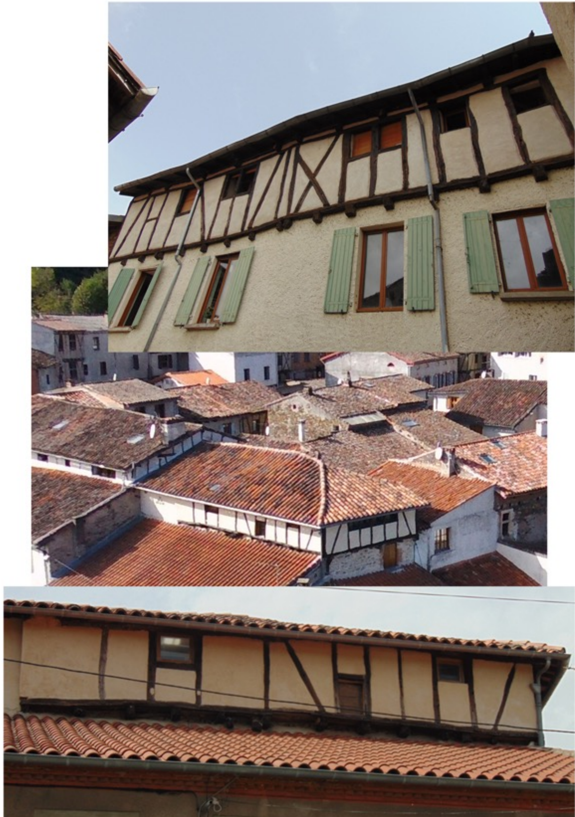
Fig. 335. Les avans des Avalats (parement interne, vue aérienne et parement externe).
