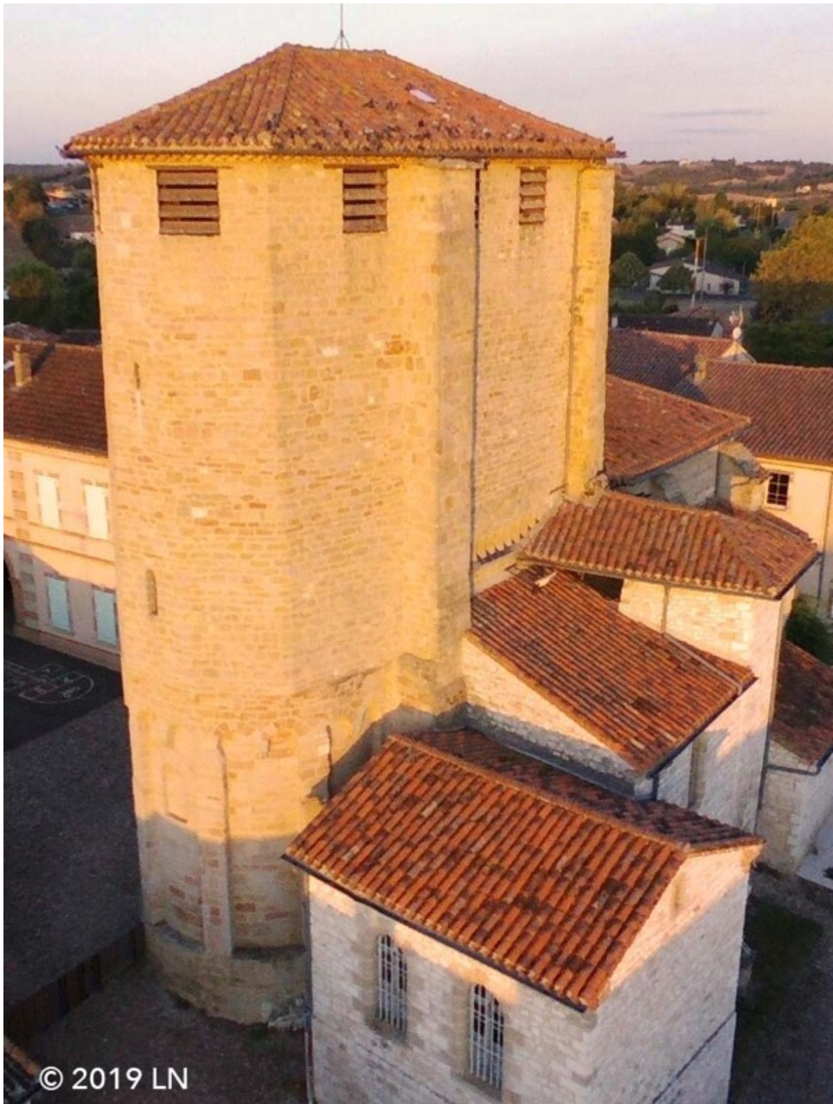
Fig. 90. Dénat, clocher fortifié par une extension à cinq pans édiflée sur le chevet roman (prise de vue aérienne par drone, Laurent Nion).
