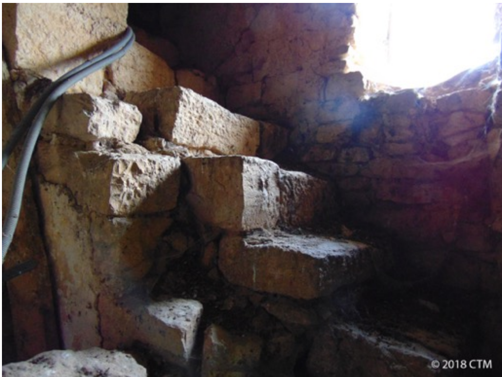
Fig. 175. Labastide-Débat, église Sainte-Catherine, vestiges d'un escalier conduisant sur le chœur.
