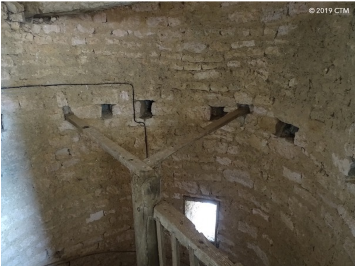
Fig. 108. Dénat, tour d'accès au clocher, renforcements du plancher sommital.
