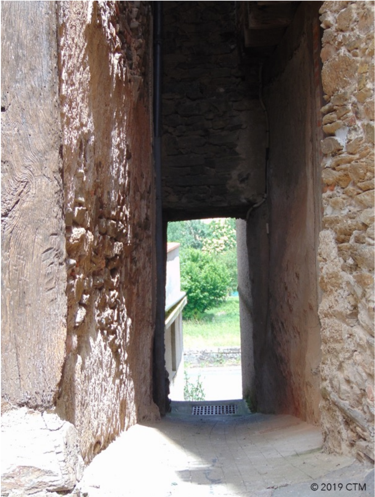
Fig. 222. Les Avalats, venelle, frange orientale de l'enceinte.
