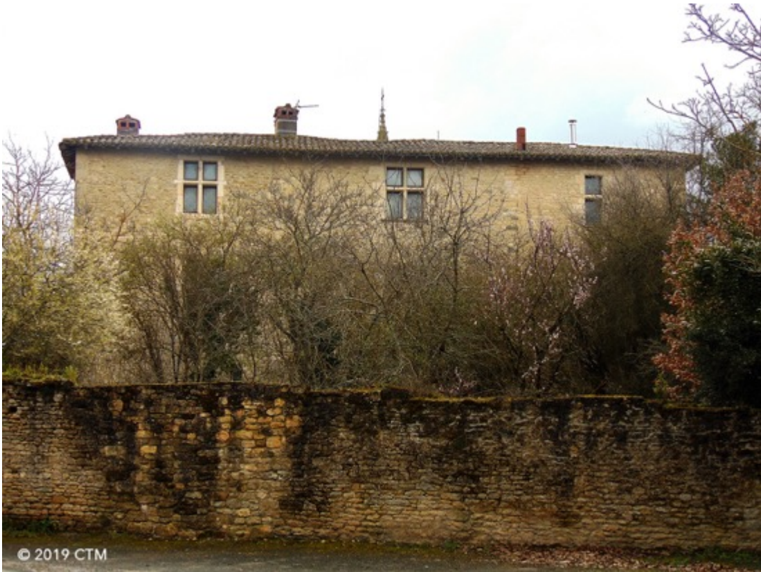
Fig. 279. Poulan, maison forte, corps de logis, façade septentrionale.
