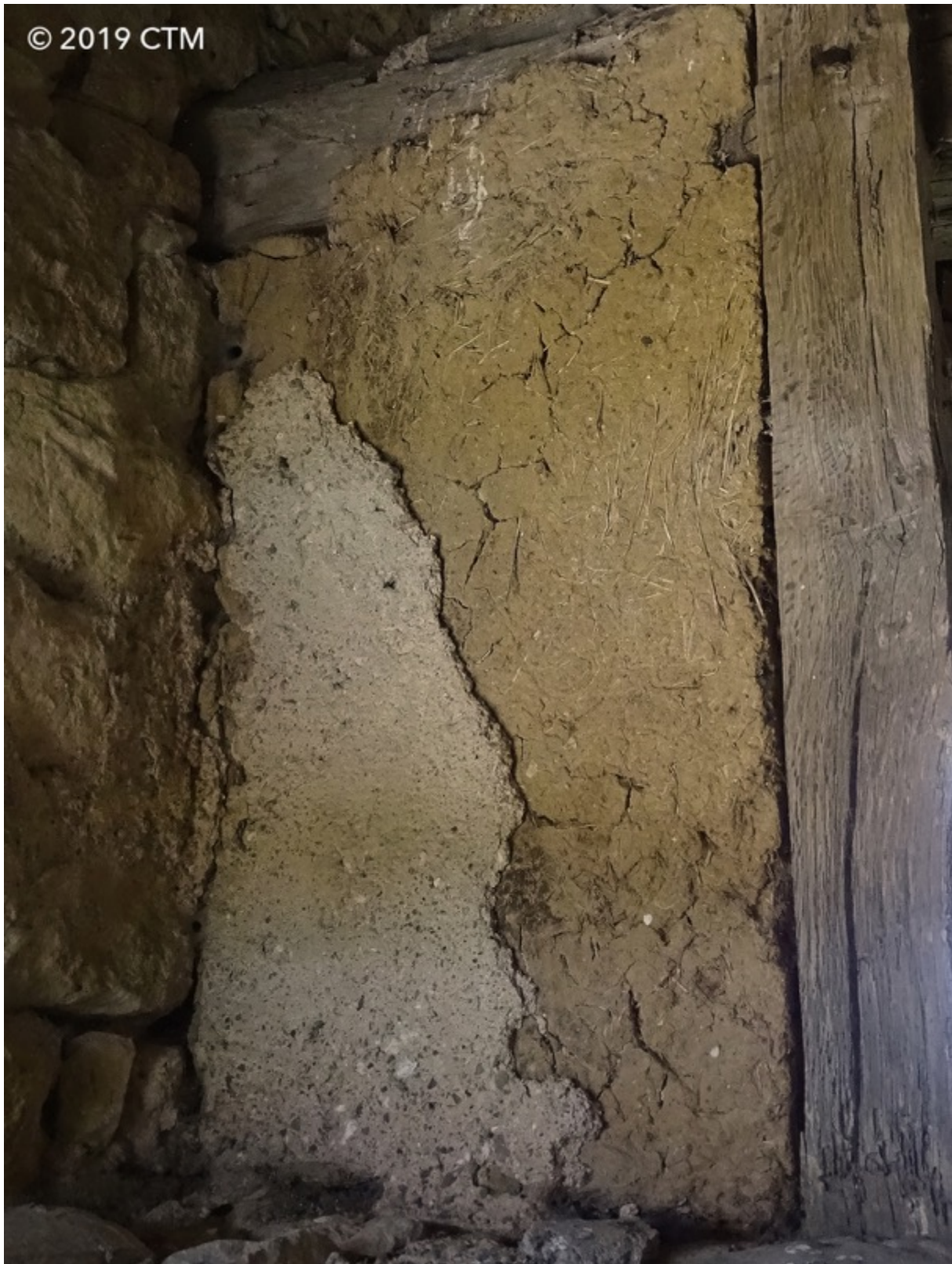
Fig. 100. Dénat, clocher fortifié, vestiges du cloisonnement sommital (ossature en bois et remplissage en terre).
