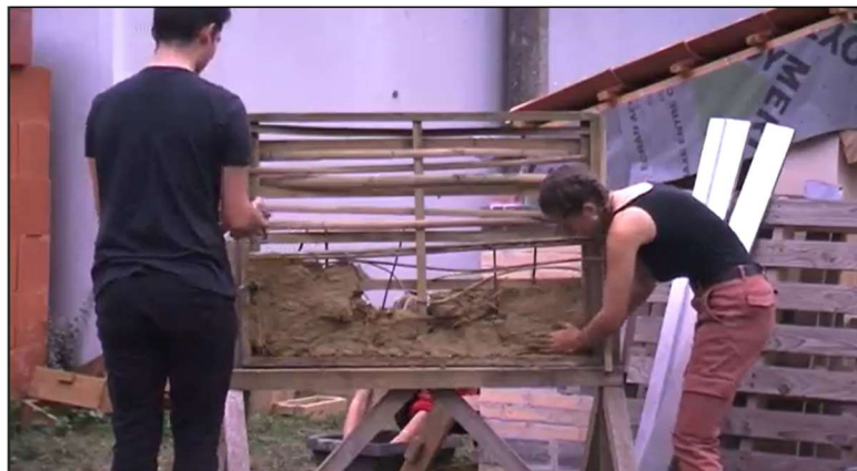
Figure 14. Atelier « Construction ». L'étudiante Jeanne aplatisant le torchis sur l'ossature en exerçant une force avec les mains
