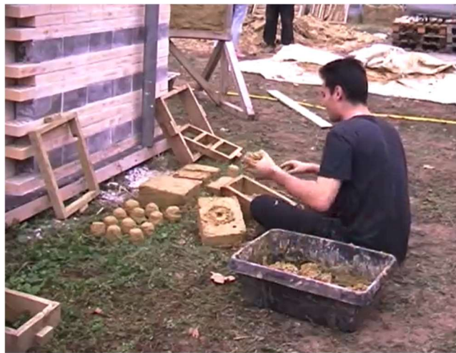
Figure 13. Atelier « Construction ». L'étudiant Louis engagé dans une activité de fabrication de briques en torchis
