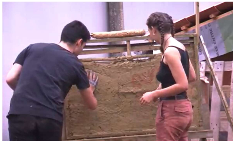
Figure 18. Atelier « Construction ». Les deux étudiants appliquant la peinture sur le mur en utilisant leurs doigts
