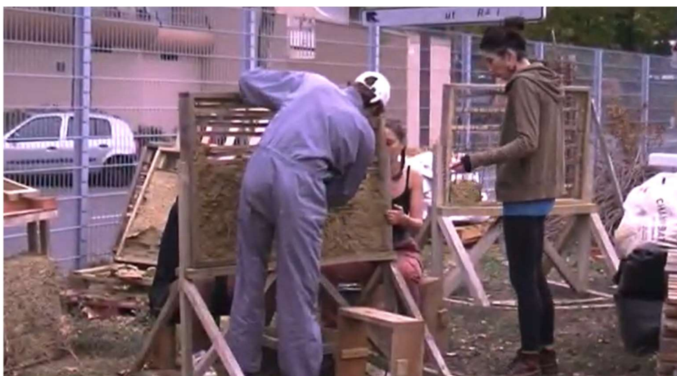
Figure 6. Atelier « Construction ». Des étudiants impliqués dans une activité de construction d'un mur en torchis
