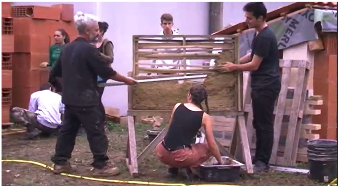
Figure 17. Atelier « Construction ». L'enseignant Juan fait la démonstration de l'utilisation de la règle du maçon à ses étudiants.
