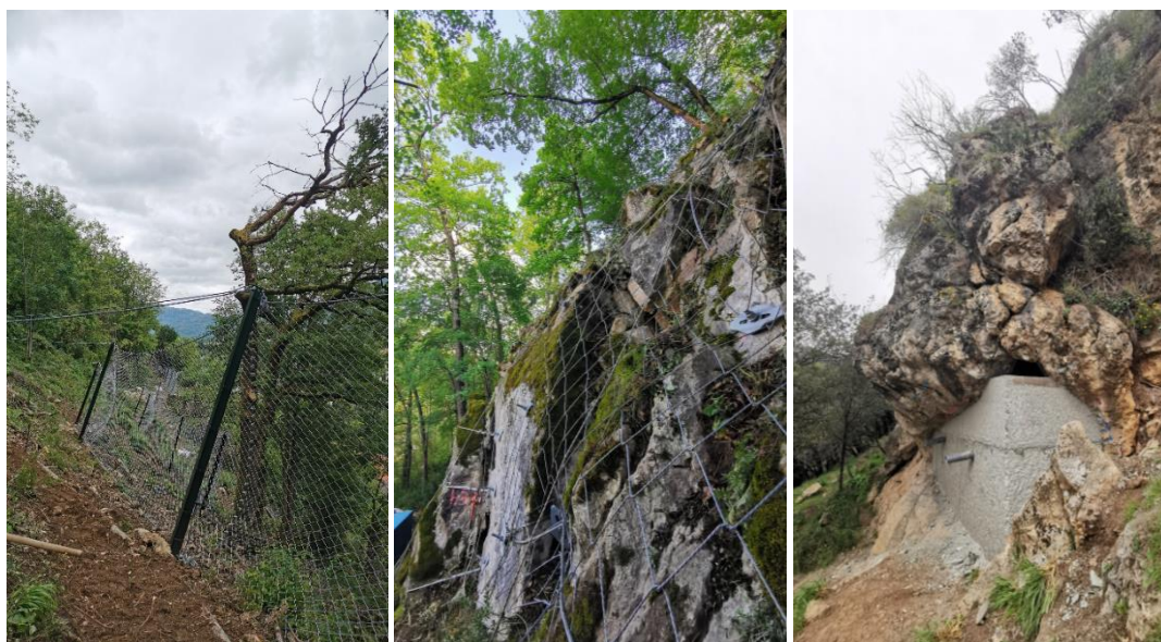
Figure 88 : Photographie - protections pare-blocs sur le Pech de Foix, RAPHOZ-LUQUET I.
