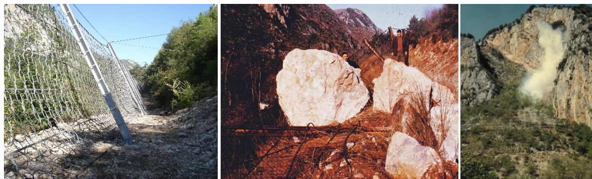
Figure 57 : Photographie - Clot de la Carbonnière protections pare-blocs, RTM 09/31
