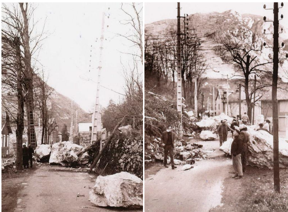
Figure 59 : Photographie - Evènement Clot de la Carbonnière 1966, RTM 09/31
