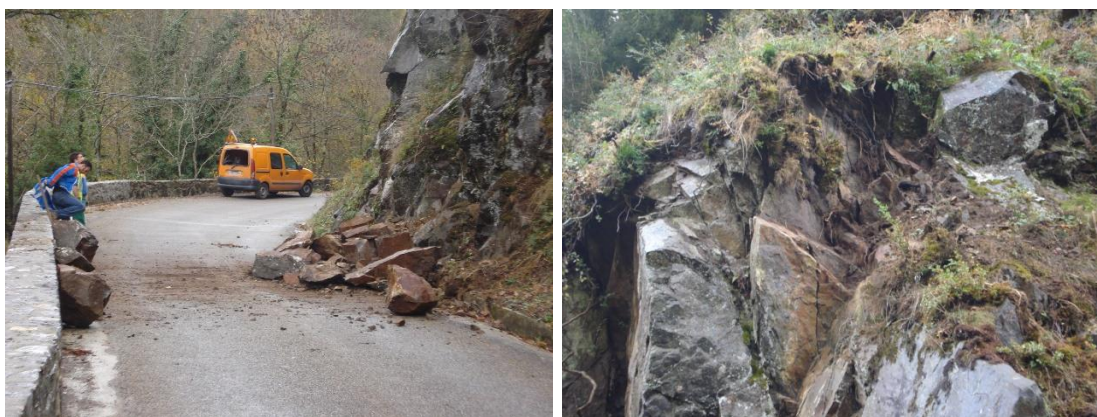
Figure 73 : Photographie - Evènement Espinart-Mouline (La) 2009, RTM 09/31
