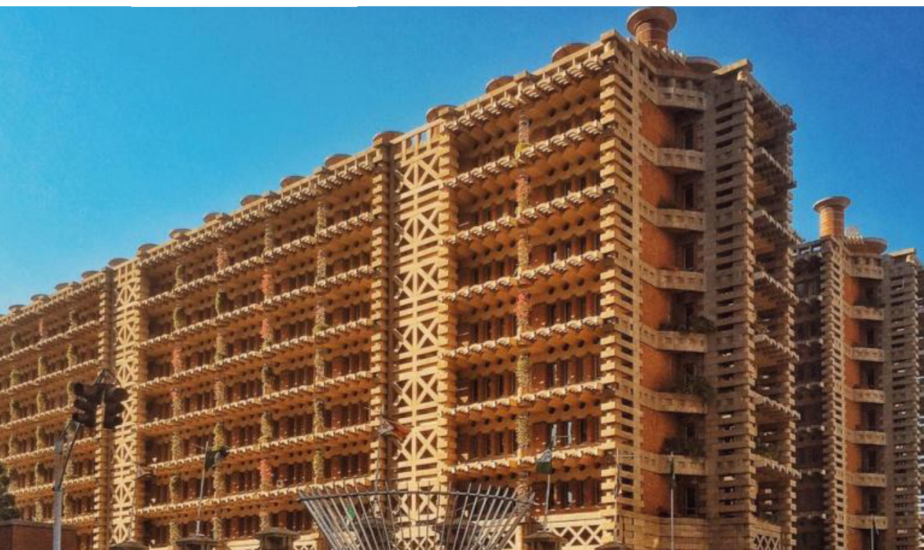
(fig.28) L'Eastgate Center d'Harare, au Zimbabwe, s'inspire du principe de la termitière. Extrait de Le Monde par David Brazier
