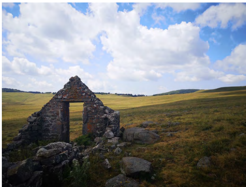
Figure 14 : Le buron, structure emblématique de l'Aubrac. Ici, buron en ruines, mars 2020
