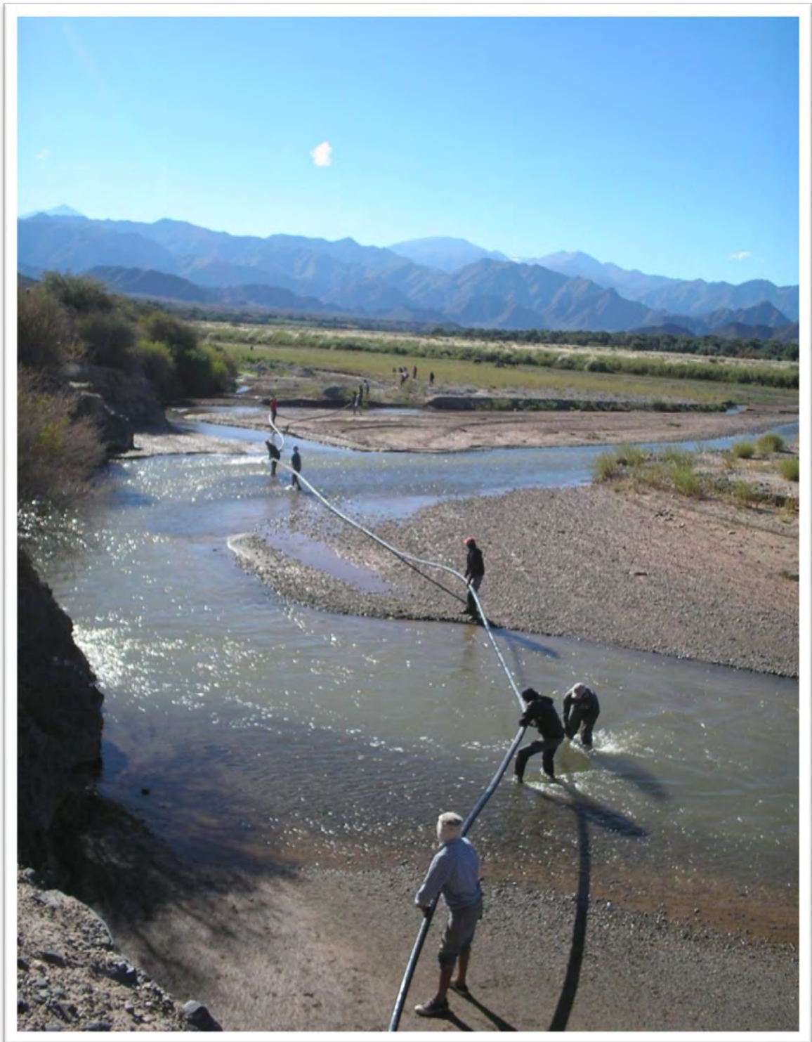
Figura 65: Traslado de materiales para la obra de agua de El Churcal.
