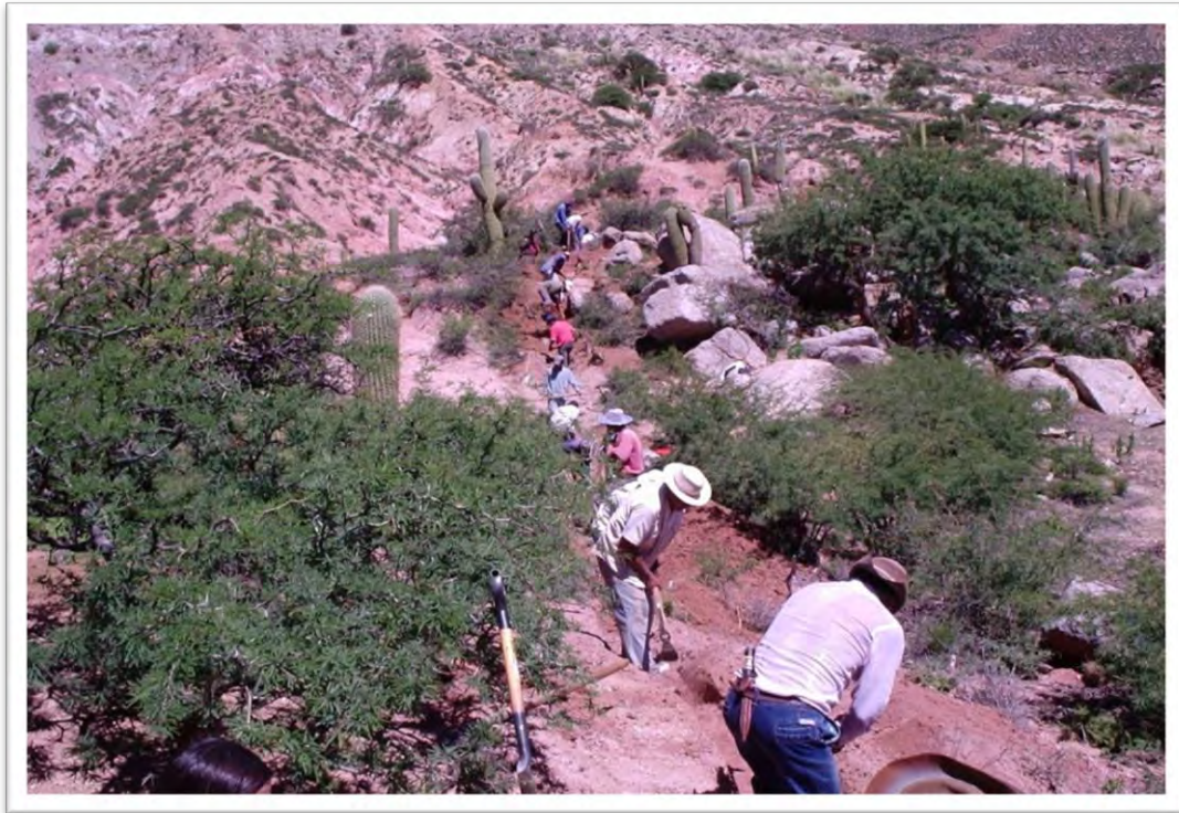
Figura 66: Cavado para enterrar la manguera de agua potable. Comunidad de Cieneguilla.
