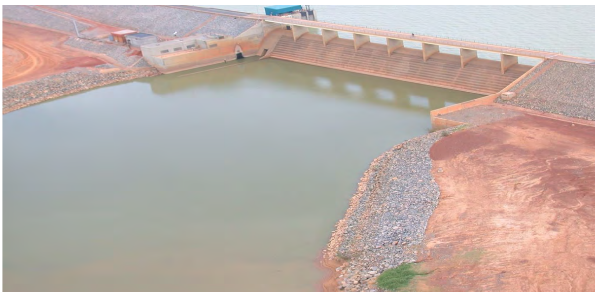
Photo 6. Déversoir du barrage de Ziga
