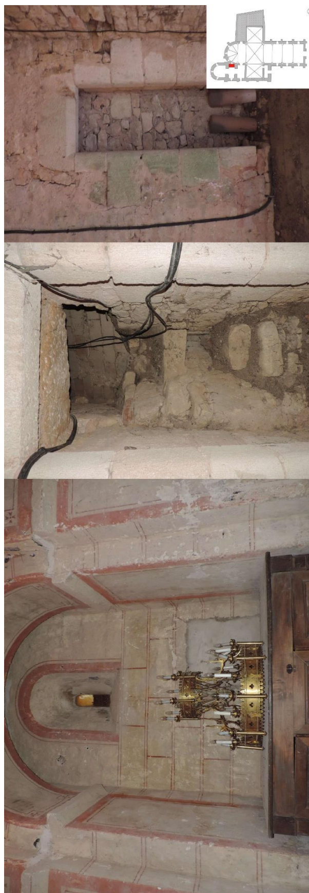
Figure 13 : Reste de la tour d'escaliers à l'intérieur de l'église romane
