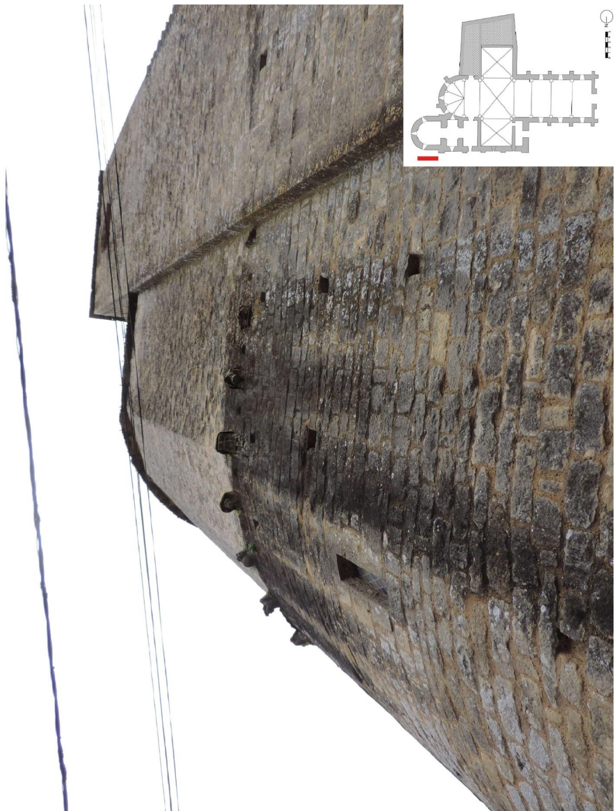
Figure 16 : Mur nord de l'abside
