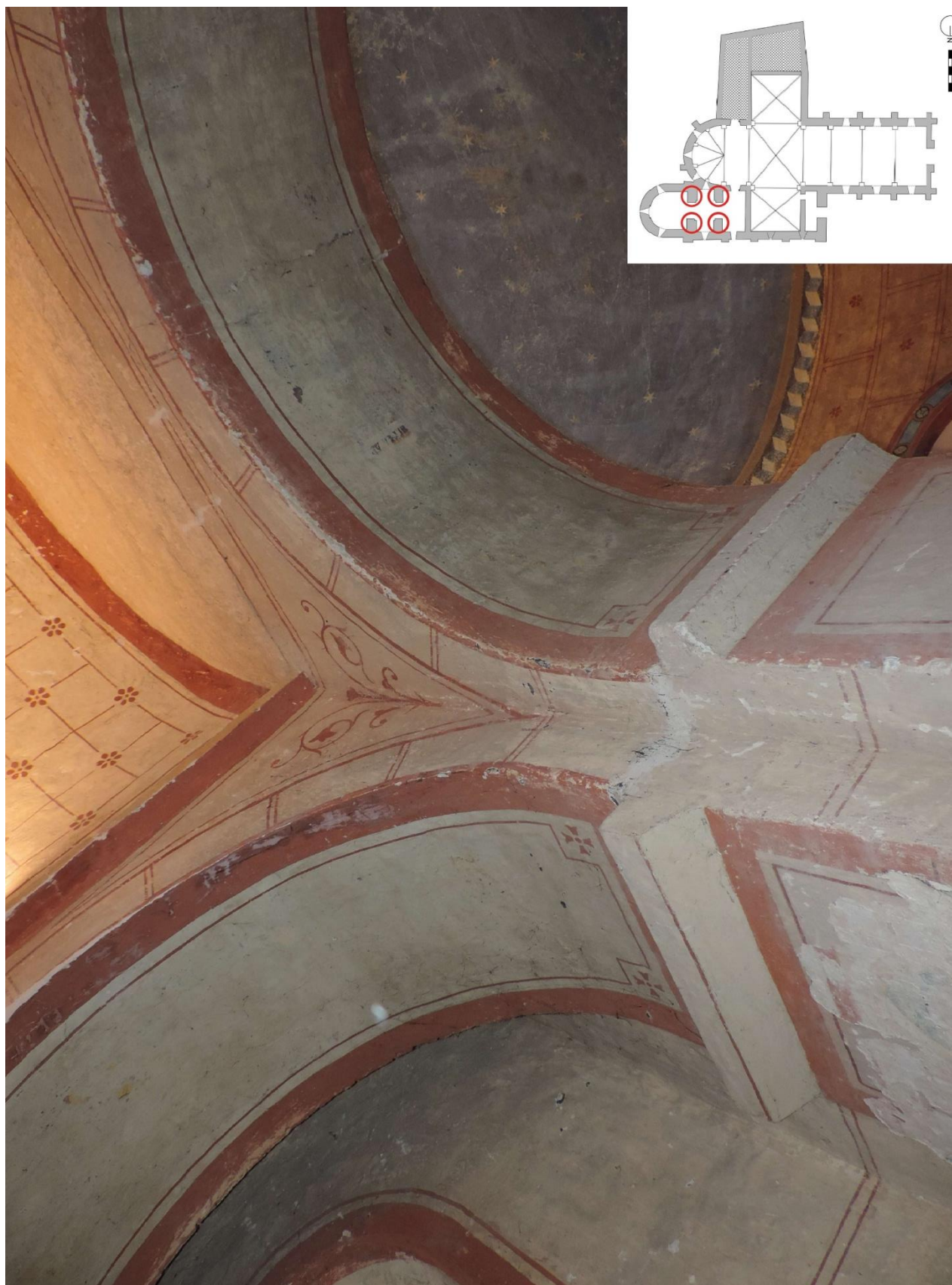
Figure 17 : Piliers massifs à l'intérieur de la travée de chœur
