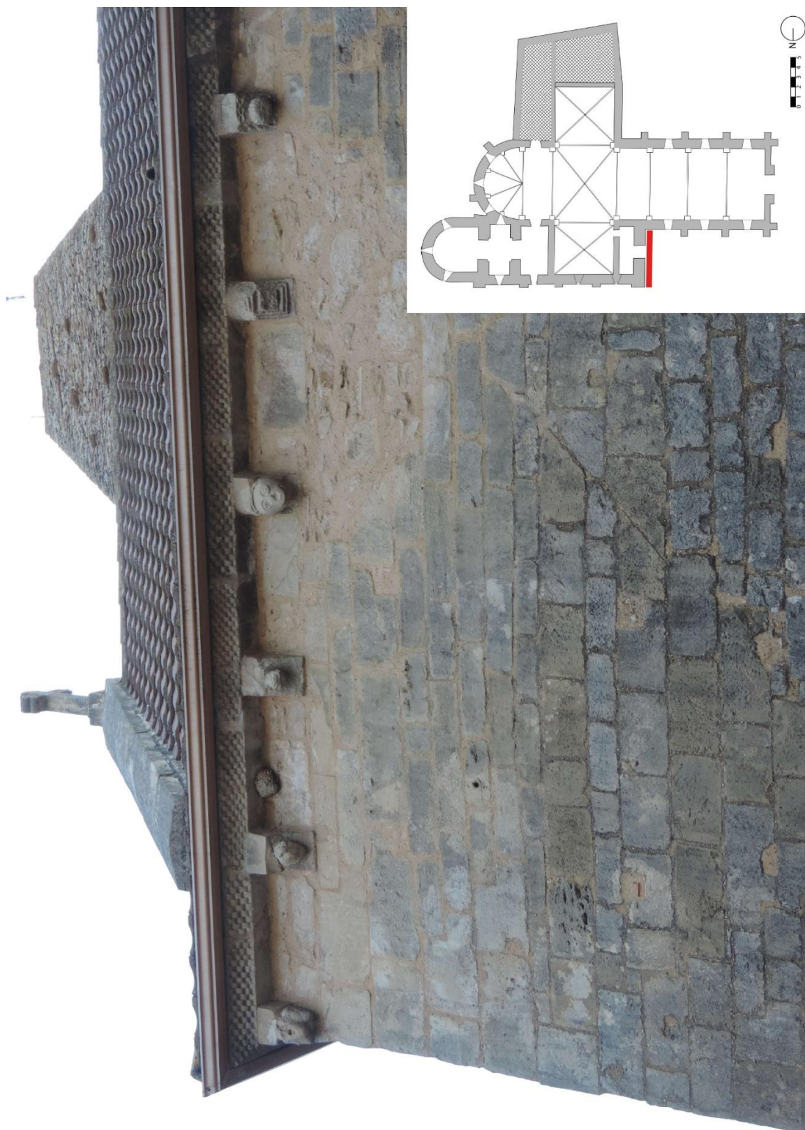
Figure 33 : Corniche chanfreinée à damier de la façade occidentale
