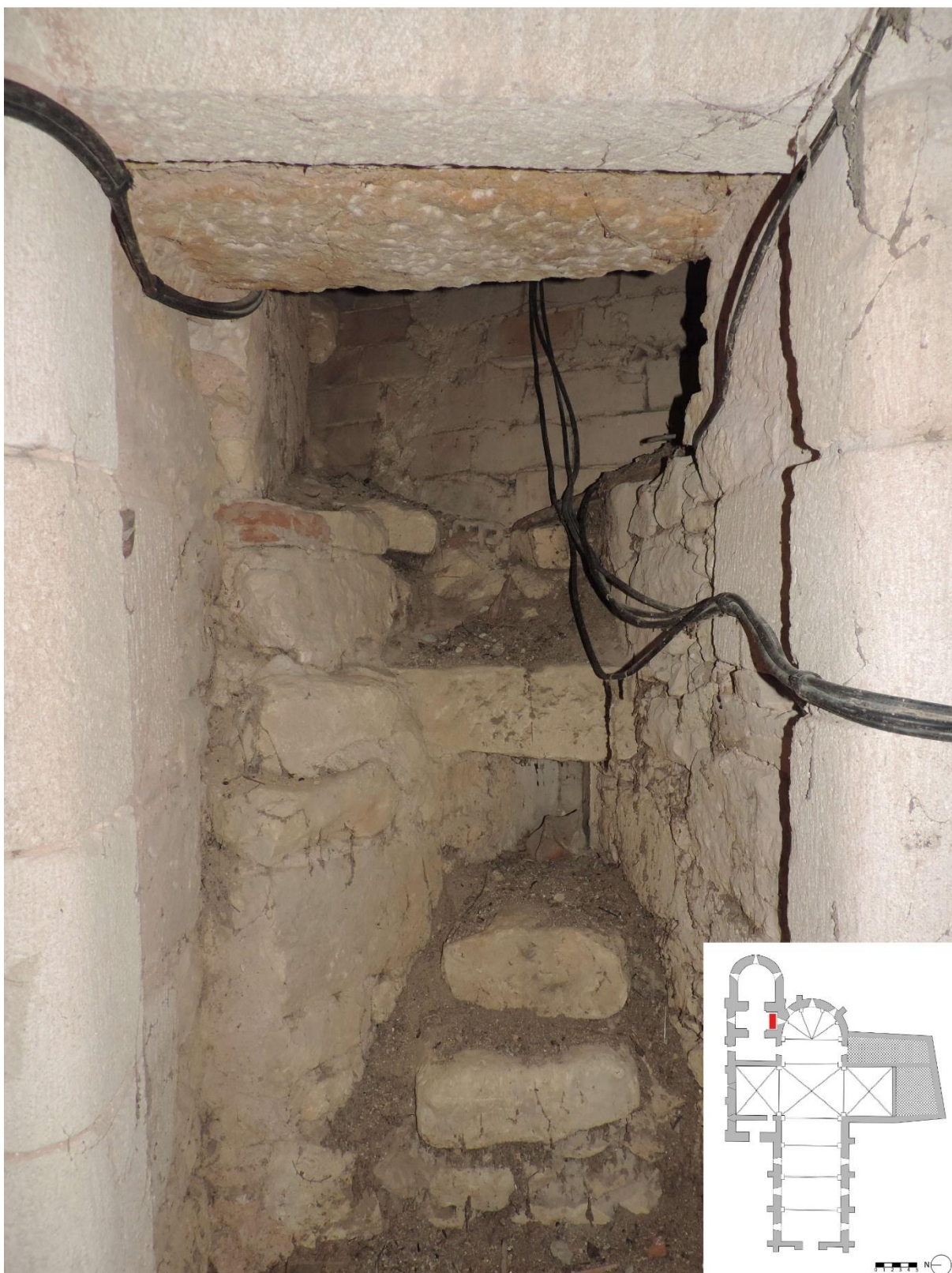
Figure 49 : Escaliers présent au deuxième étage de la tour de clocher
