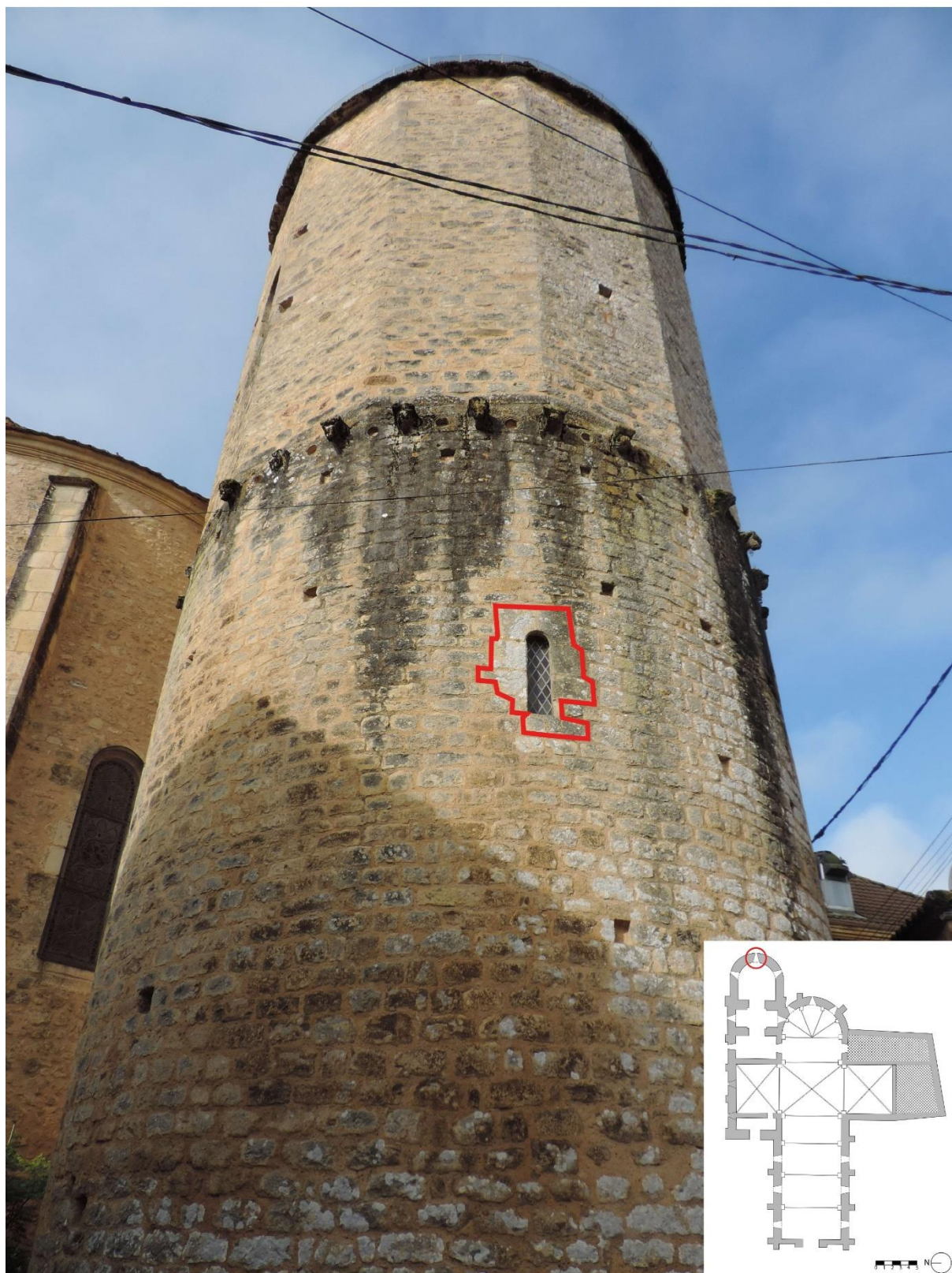
Figure 45 : Fenêtre d'axe de l'abside romane
