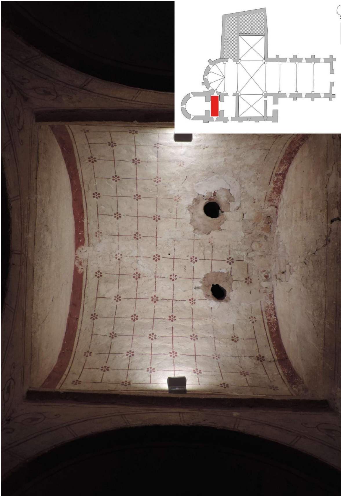
Figure 9 : Voûte de la travée de chœur
