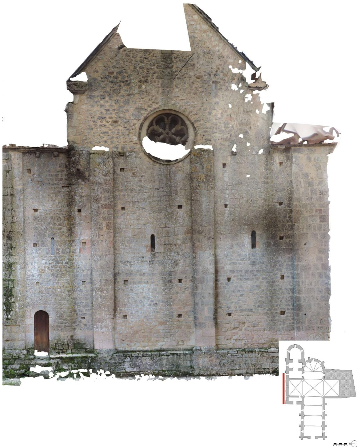
Figure 19 : Mur nord de la nef romane
