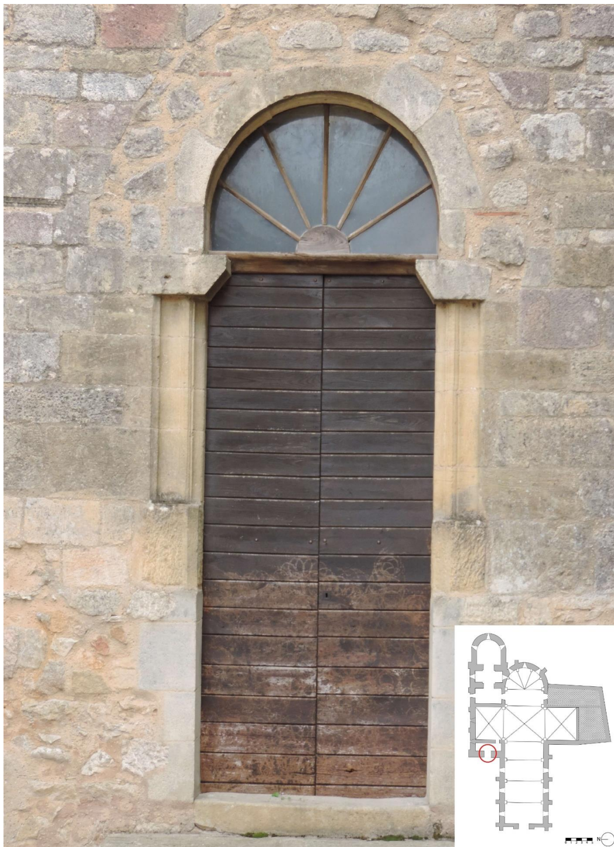
Figure 34 : Détail de la porte de la façade romane occidentale
