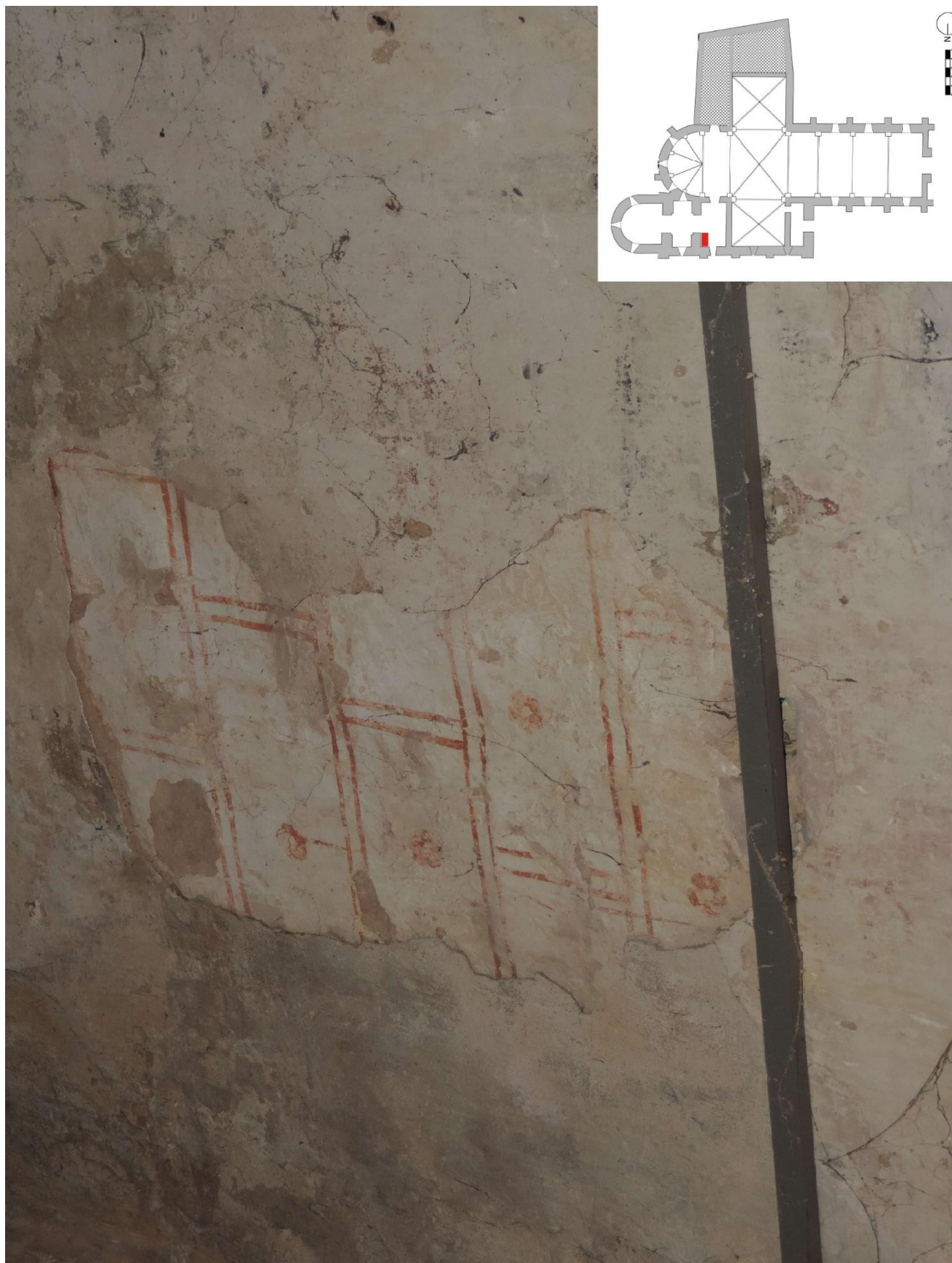
Figure 12 : Faux appareil présent sur le mur est du vestibule roman
