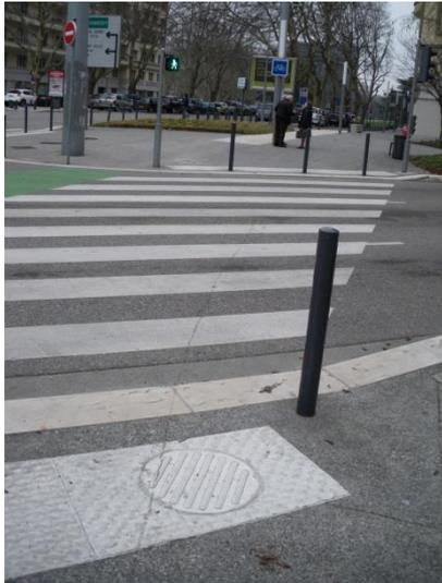
Figure 33 : Bande podo-tactile sur une traversée piétonne
