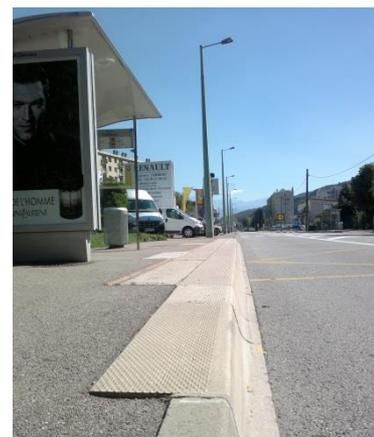
Figure 30 : Bandes podo-tactiles sur un arrêt de bus (Réalisation personnelle)
