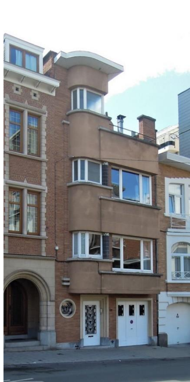
Fig. 132 : Attribué à Louis Tenaerts, immeuble , 42 rue Ernest Gossart, Bruxelles, 1936.
