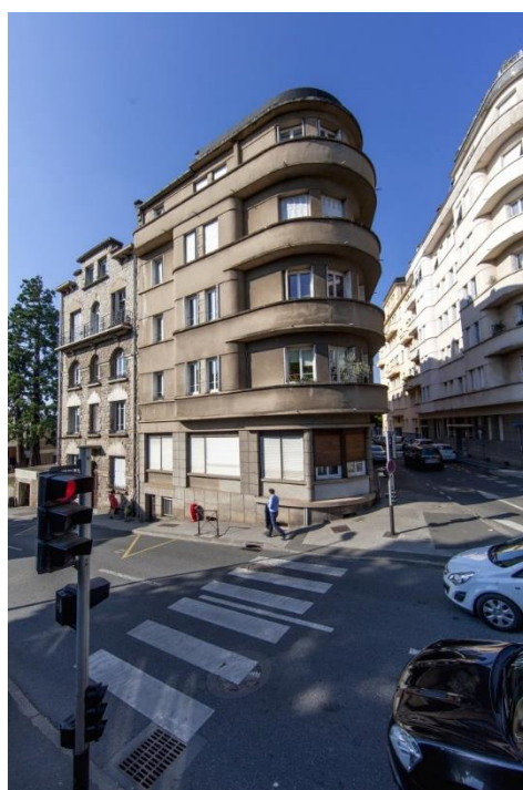
Fig. 134 : Rémus Henri (architecte), Cerri (entrepreneur), Immeuble , 1 rue de Séguret-Saincric, Rodez, 1941.
