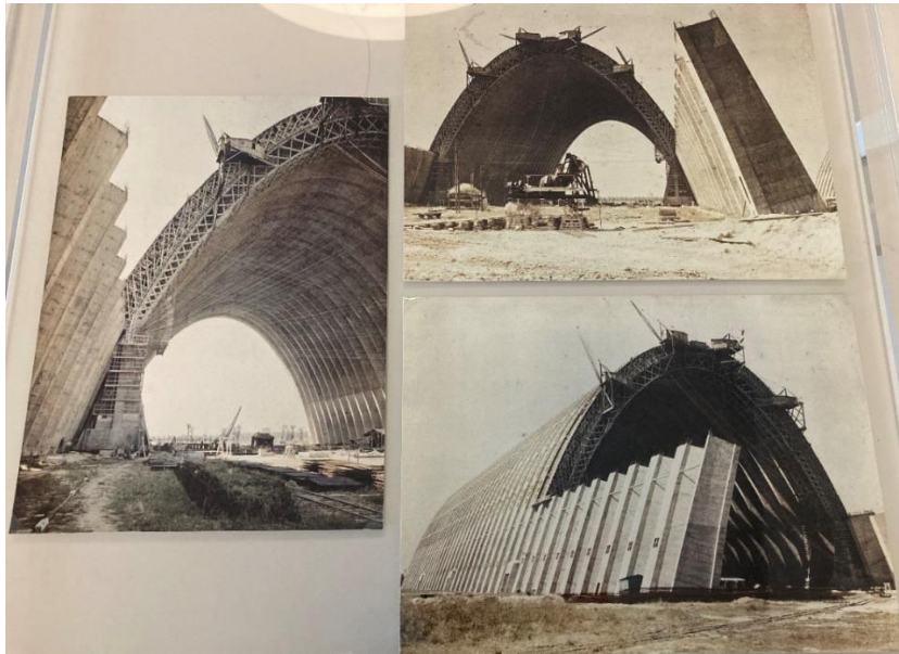
Fig. 1 : Eugène Freyssinet, Hangars à dirigeables de Orly , Cité de l'Architecture et du Patrimoine, Paris, 1921-1923.
