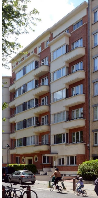
Fig. 129 : Louis Tenaerts, Immeubles , 20 et 21 rue Constantin Meunier, Bruxelles, 1936.
