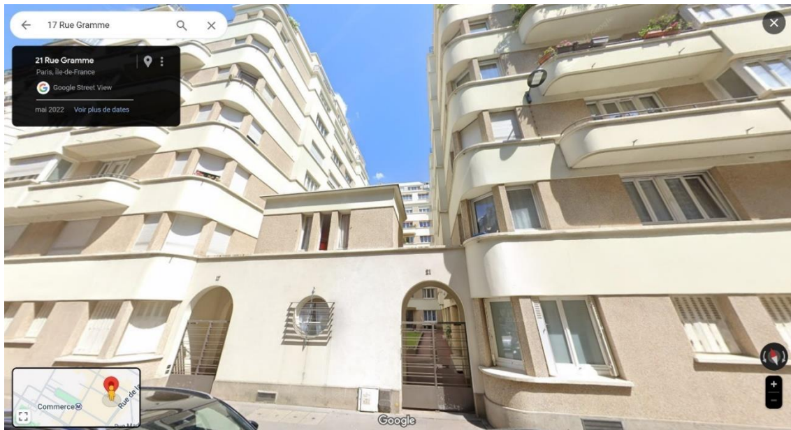
Fig. 136 : S. Kleiner, Immeuble , 17-21 rue Gramme, Paris, 1935.
