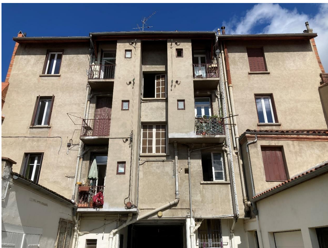
Fig. 93 : David Moretti, Communs et élévation donnant sur la cour , 20 rue Saint-Hilaire, Toulouse, 1936.
