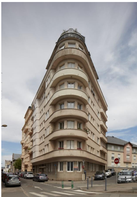
Fig. 133 : Rémus Henri (architecte), Bardet Maurice (maître d'œuvre), Immeuble Le Normandie , 2 rue de Séguret-Saincric, Rodez, 1941
