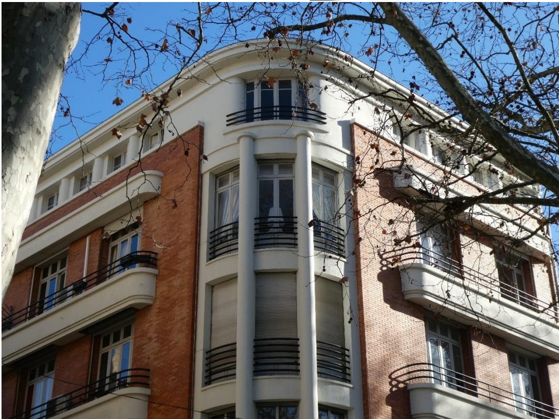
Fig. 40 : Antonin Thuriès, Pierre Thuriès, Immeuble Thuriès , 2 allées Forain-François Verdier, Toulouse, 1933.
