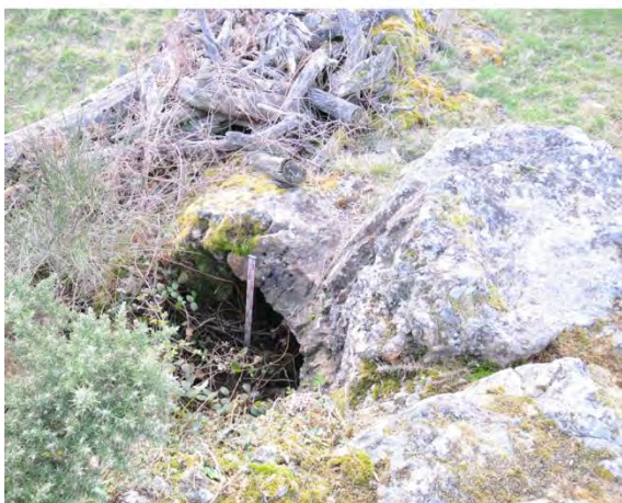
b. Voûte maçonnée dans la partie centrale de TUI3, vue depuis le sud.
