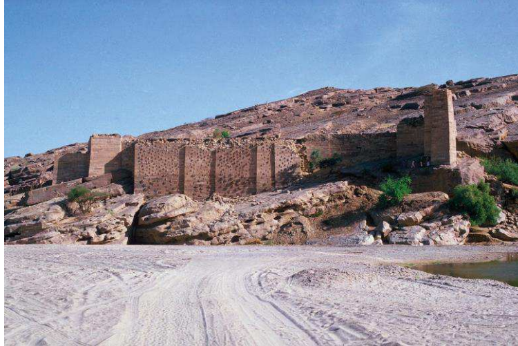
Fig.69 - Vue de l'Écluse méridionale de la digue et sa construction massive depuis le lit du wādī, dans Darles et al. 2014 : 19.
