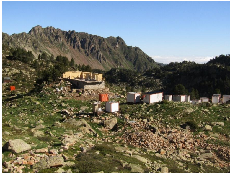
Figure 70 : l'emprise du chantier et de la base vie – refuge de Campana de Cloutou (crédit photo : GC, 25 juin 2021)
