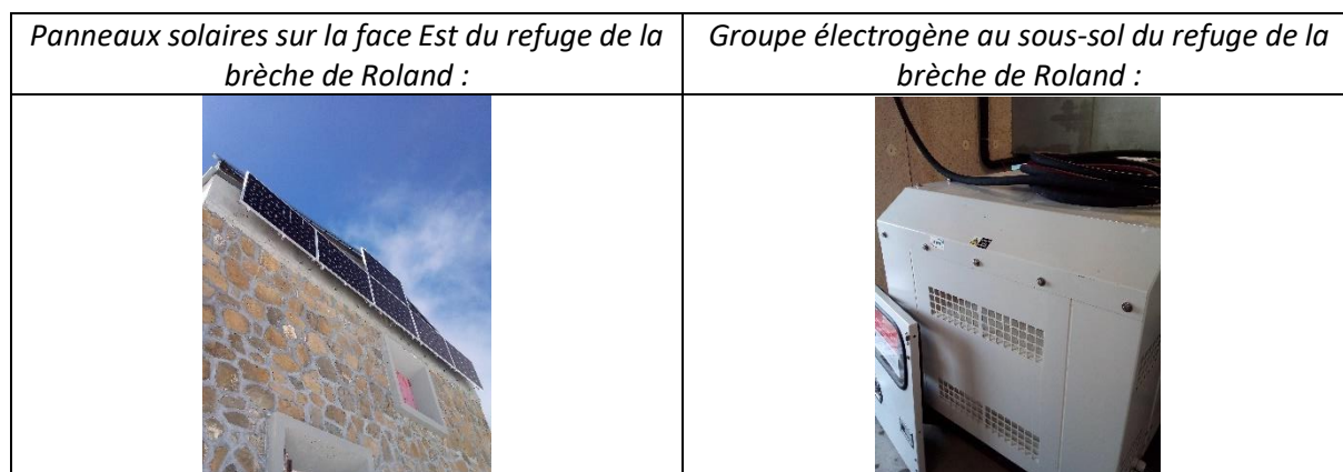
Figure 33 : Installations productrices d'électricité au refuge de la brèche de Roland (Photos : GC)
