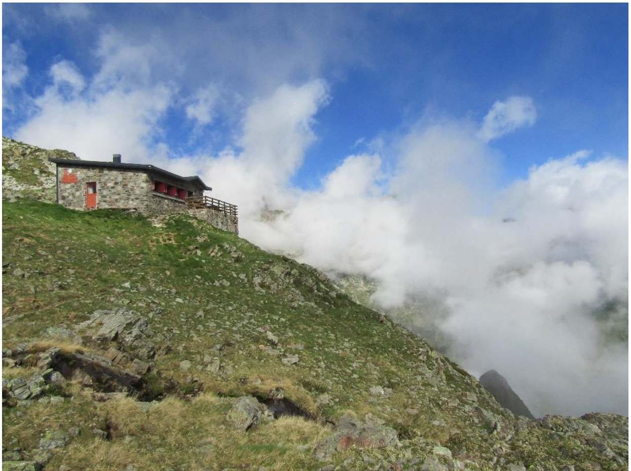
Figure 68 : Le refuge du Maupas (31) (photo : Gabin Charbonnel, juin 2021)
