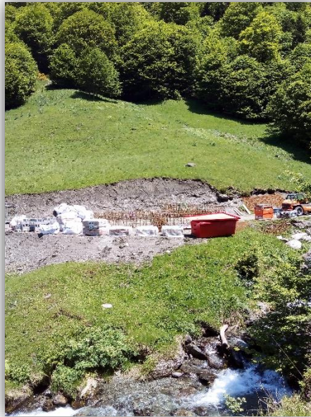
Figure 55 : nouvelle zone d'hélicoptage pour le chantier de Vénasque avec terrassement visible (crédit photo : Gabin Charbonnel)
