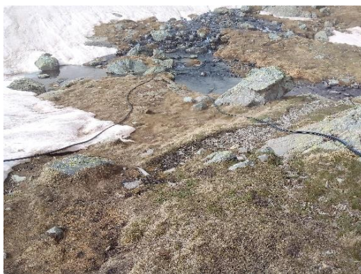
Figure 36 : conduite PEHD du réseau d'adduction d'eau du refuge de Vénasque (crédit photo : GC)
