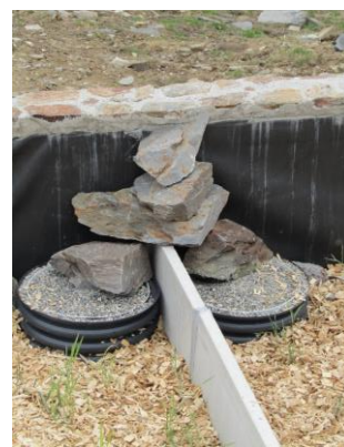
Figure 41 : bacs de traitement du filtre planté et escalier à faune (Crédits photos : GC, 30 mai 2021)
