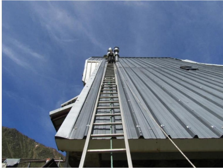
Figure 74 : Bénévole du CAF des montagnards ariégeois prenant des mesures pour réparer une bouche d'évacuation sur le toit du refuge de l'étang Pinet (photo : GC)
