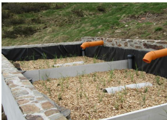
Figure 41 : bacs de traitement du filtre planté et escalier à faune (Crédits photos : GC, 30 mai 2021)
