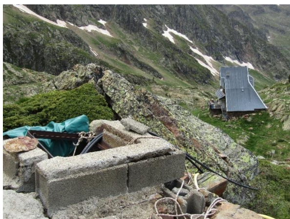
Figure 37 : Cuve reliée au refuge de l'étang Pinet (crédit photo : Gabin Charbonnel, juin 2021)
