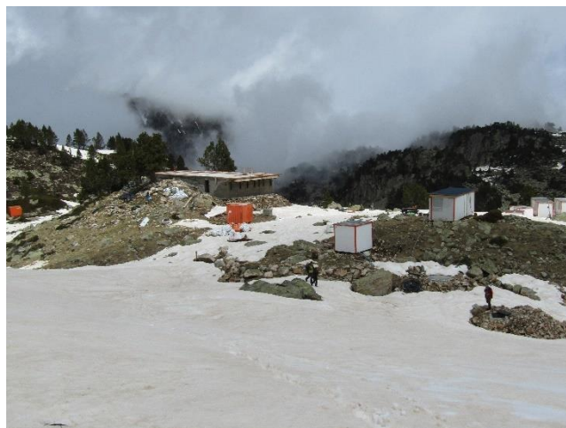
Figure 48 : Le site du refuge de Campana de Cloutou avant la reprise du chantier, 1 er mai 2021 (crédit photo : GC)
