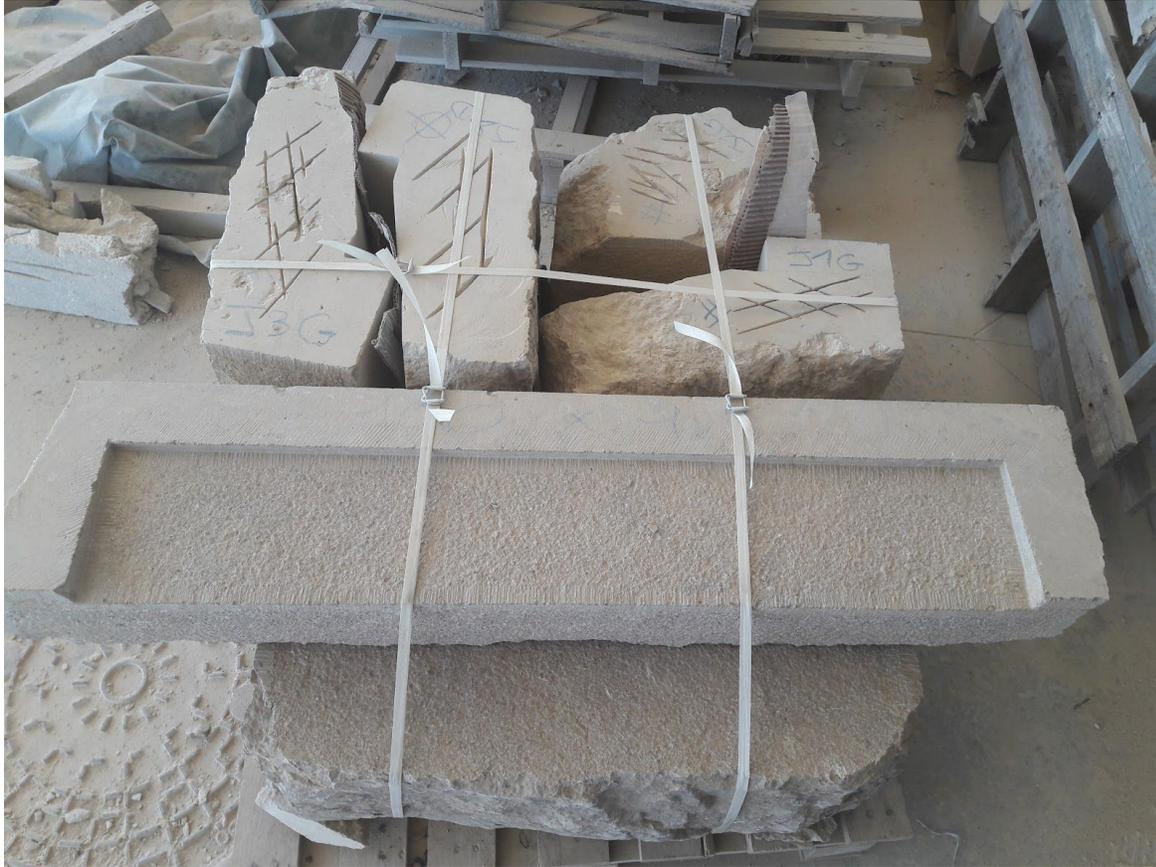
Figure n°31 : Pierres taillées et prêtées à être posées en suivant le marquage codifié. Photographie personnelle 2019
