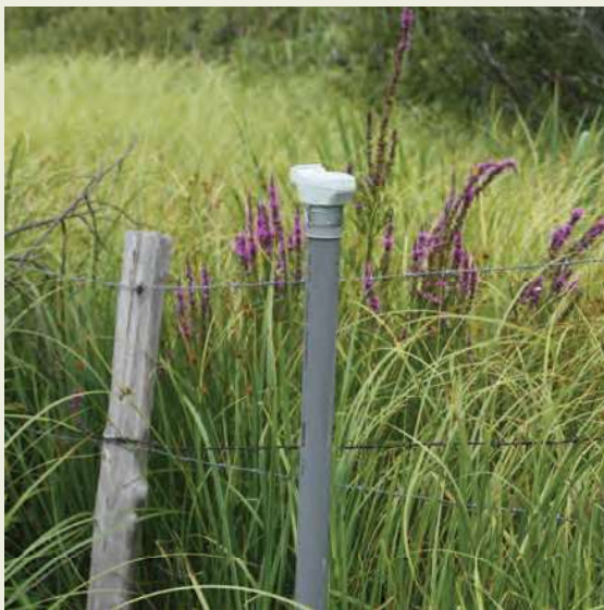
Piézomètre équipé d'une sonde de mesure automatique
