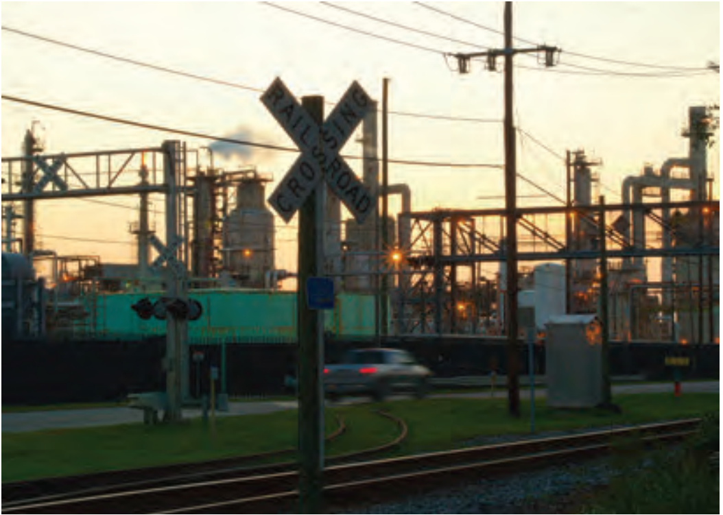
131 • Raffinerie de St Bernard Parish, Louisiane [juillet 2015].
