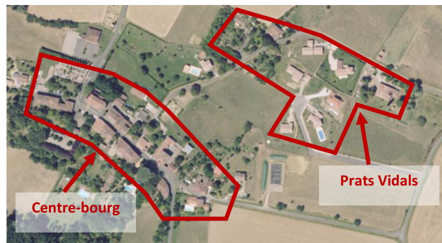
Figure 17 : Le quartier Prats Vidals par rapport au centre-bourg, Montpitol, source géoportail
