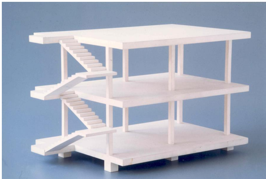
Figure 60 : Principe constructif du système Dom-ino utilisé par Le Corbusier
