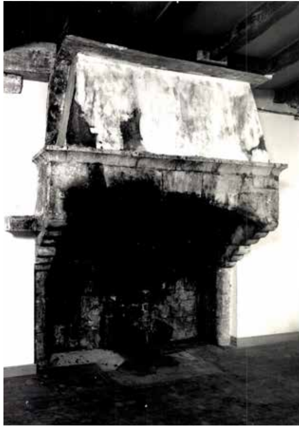
fig. 83 : cheminée de la maison faisant l'angle entre la rue Droite et l'impasse Prestat (photographie : LONCAN B. et al. , 1993, p. 229)
