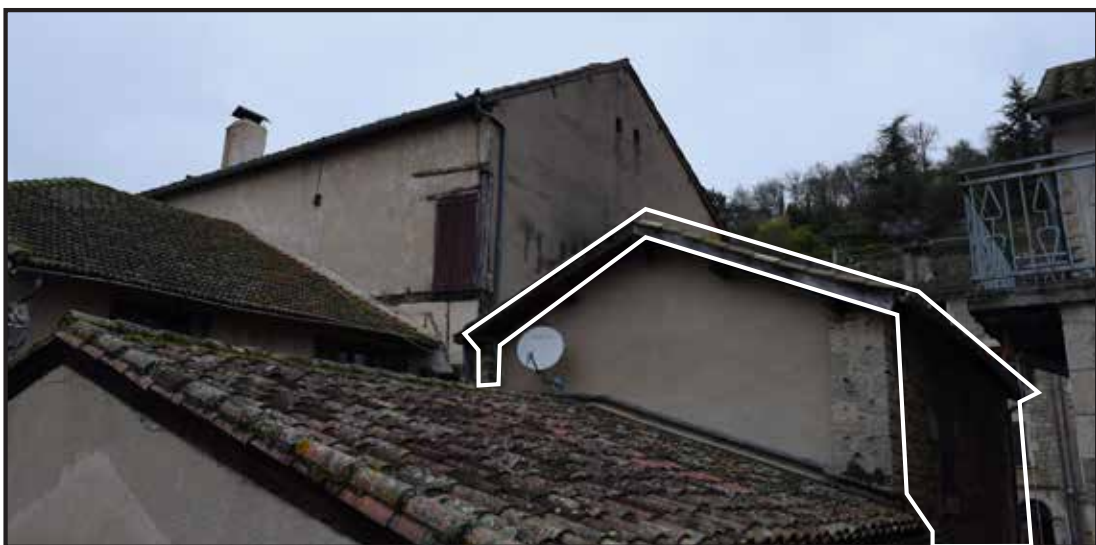
fig. 130 : parcelle 410. Photographie de la maison vue du niveau de toiture de l'îlot I7 (Photographie : Eric CHABANNE)
