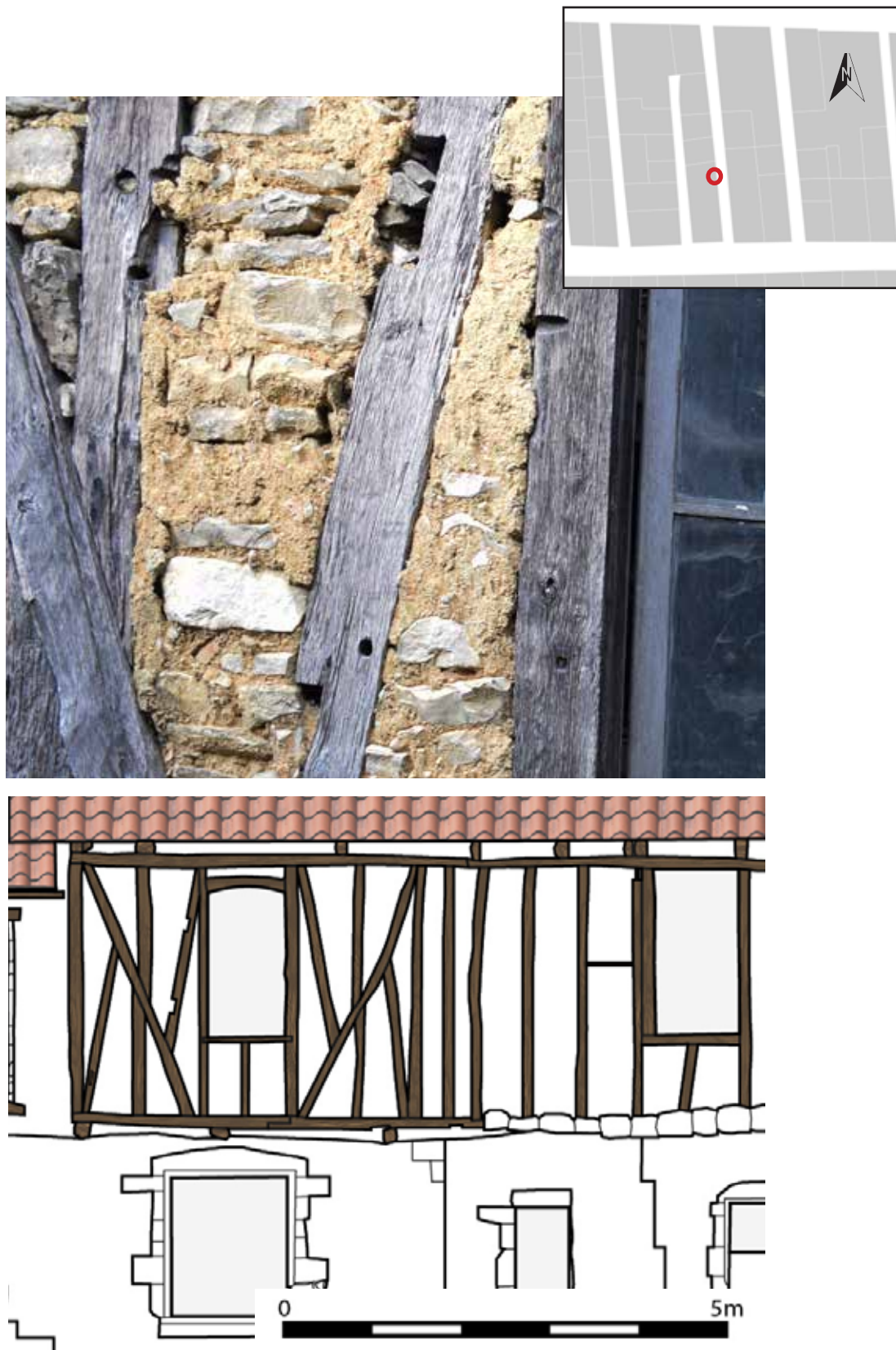
fig. 67 : surélévation en pan de bois de rempli (I6_2) (photographie et relevé : Eric CHABANNE)
