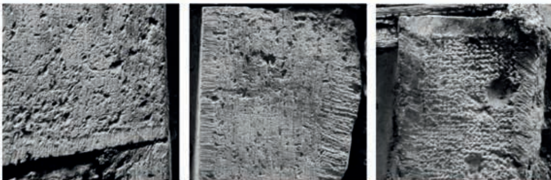
fig. 64 : exemples de ciselures (de gauche à droite I5_2_POR4 ; I6_1_FEN03 ; I8_1_POR3)
