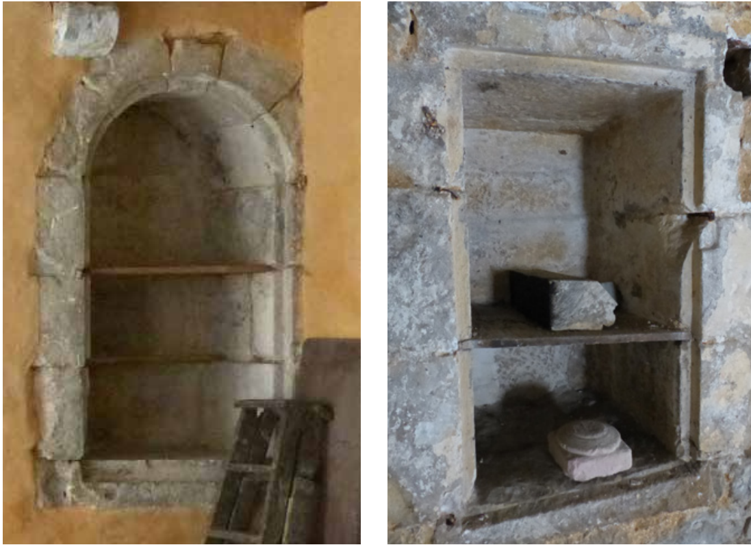
fig. 87 : armoires murales de la maison 23, rue Droite, Caylus (photographies : SÉRAPHIN G., 2019)
