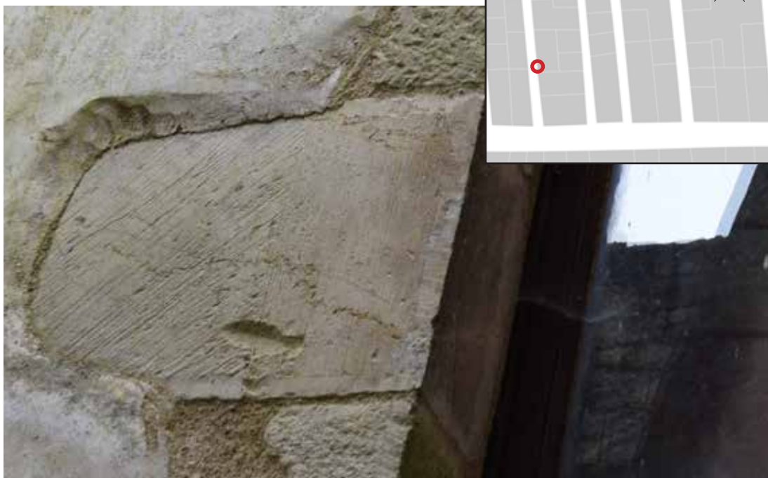
fig. 70 : exemple de bloc en partie ravalé (I5_1_FEN 7) (photographie : Eric CHABANNE)
