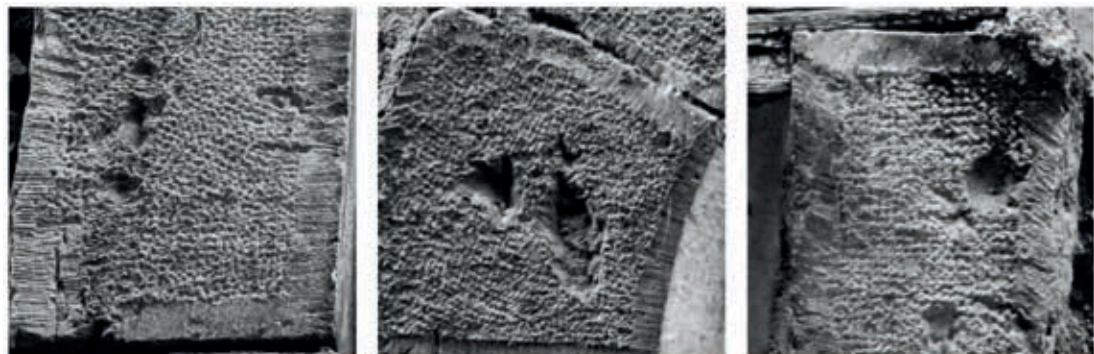
fig. 61 : exemples de tailles bouchardées (de gauche à droite I5_1_FEN03 ; I6_2_POR9 ; I8_1_POR3) (photographies : Eric CHABANNE)
