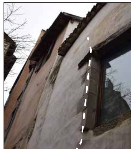
fig. 136 : parcelle 412. Déformation de la façade occidentale (photographie : Eric CHABANNE)
