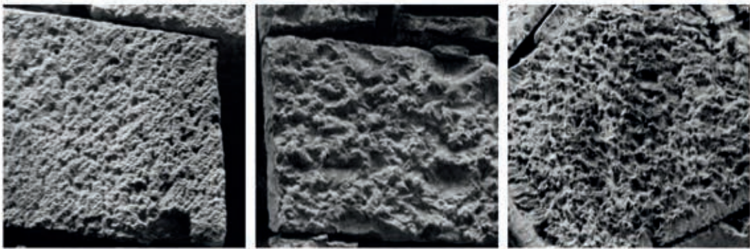
fig. 63 : exemples de tailles à la broche (de gauche à droite I5_2_FEN10 ; I6_2_FEN07 ; I6_2_POR9)
