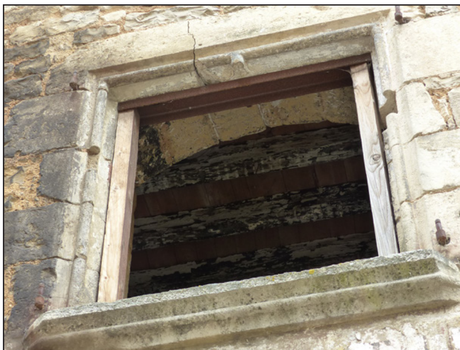
fig. 76 : exemples de fenêtres à croisée dont le remplage est bûché (Photographies : SÉRAPHIN G., Caylus, maison 23, rue Droite , 2019)
