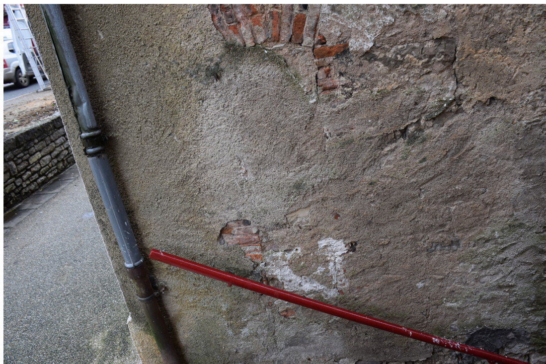
fig. 75 : jour (FEN 34) bouché, couvert d'un arc segmentaire en brique pleine (Photographie : Eric Chabanne)
