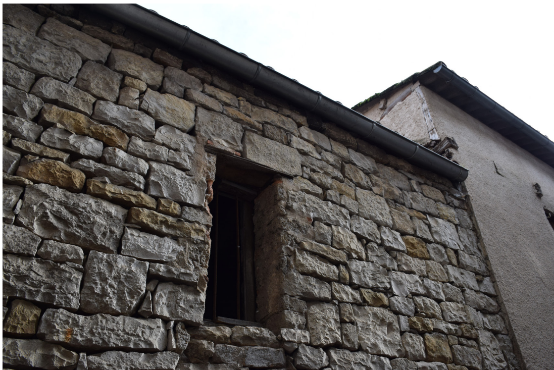
fig. 73 : fenêtre (FEN 16) constituée de moellons équarris (Photographie : Eric Chabanne)
