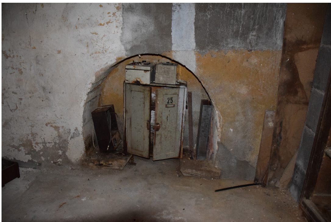
fig. 90 : intérieur de la seconde maison, mur est, niche pour évier (Photographie : Eric Chabanne)
