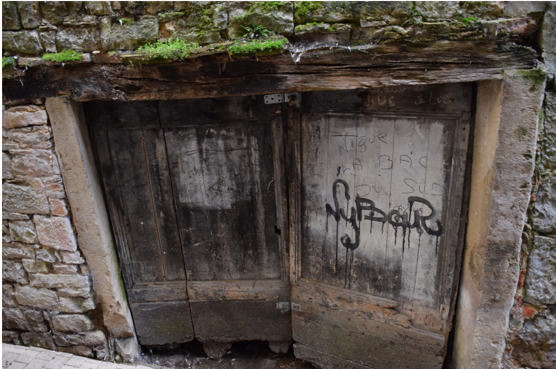
fig. 70 : Porte (POR 3), composée de piédroits monolithes et d'un linteau en bois (Photographie : Eric Chabanne)
