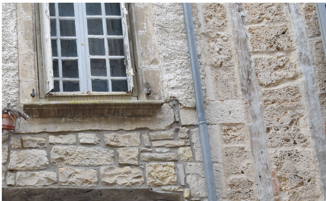
fig. 27 : maison 1 comportant un élément d'attente (à gauche) et maison 14 (à droite) (Photographie : Eric Chabanne)
