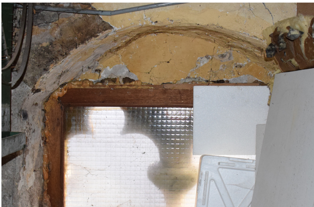
fig. 89 : revers de la fenêtre (FEN 7), embrasure sous arcade (Photographie : Eric Chabanne)
