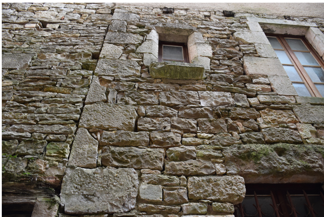
fig. 56 : chaînage d'angle (USC 29) sur la façade 3 (Photographie : Eric Chabanne)
