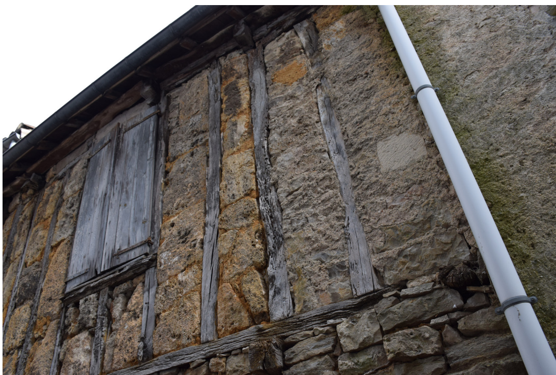
fig. 79 : enduit 19 qui recouvre une partie du hourdis de PB 2 (Photographie : Eric Chabanne)
