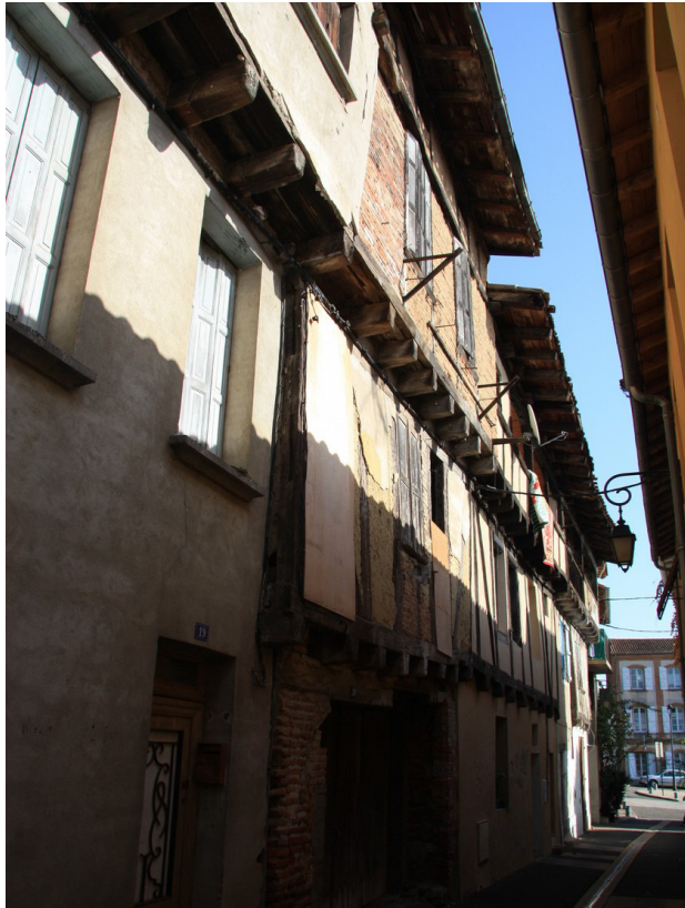
fig. 84 : Moissac, maisons rue Tourneuve (Photographie : Joris Moron)
