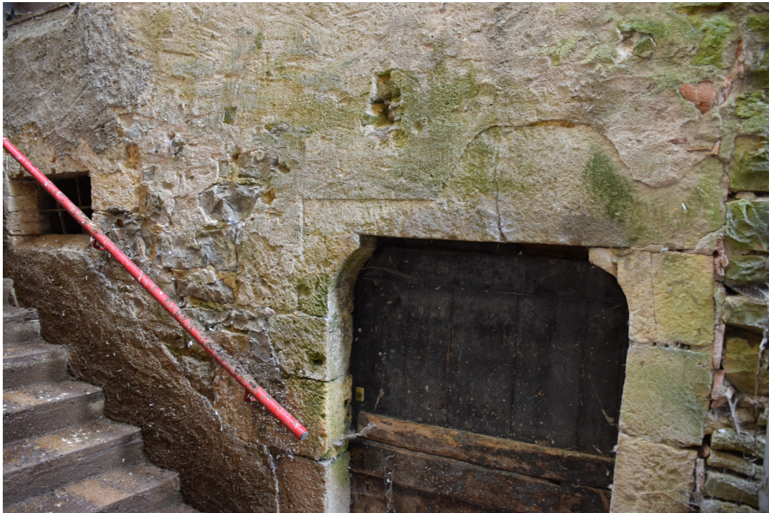
fig. 74 : porte (POR 5) couverte d'un linteau sur coussinets en cavet (Photographie : Eric Chabanne)
