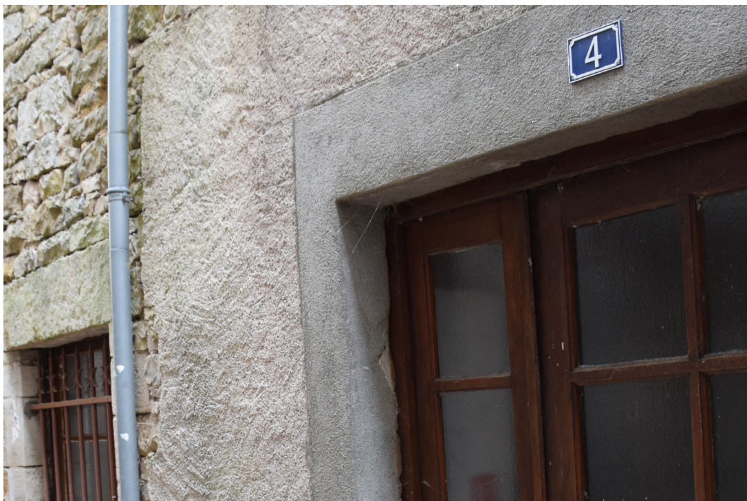
fig. 78 : enduit 14 qui occupe le rez-de-chaussée de la façade 2 (Photographie : Eric Chabanne)
