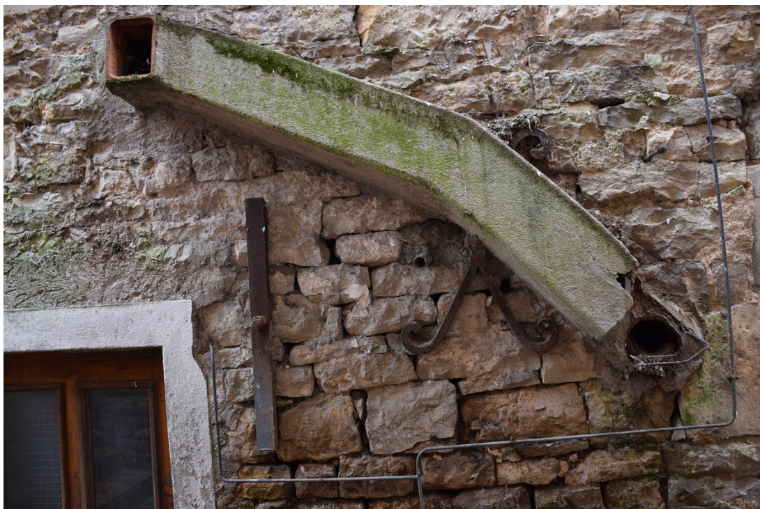
fig. 58 : exemple de parement (USC 54 et 163) de la façade 5 (Photographie : Eric Chabanne)
