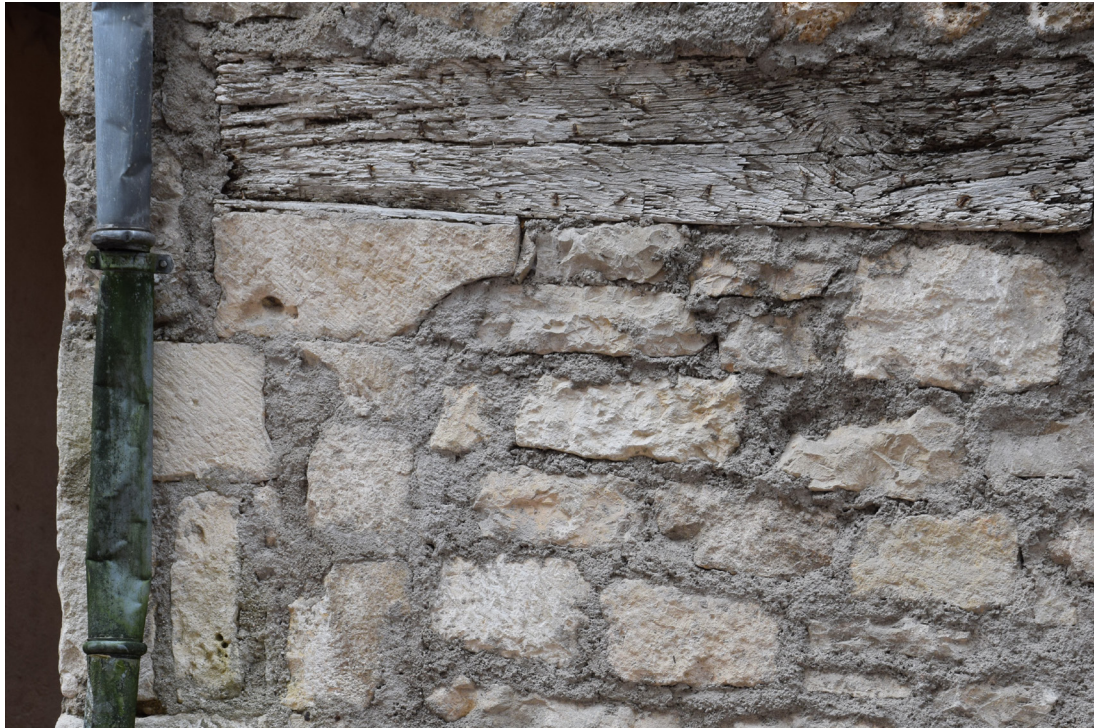
fig. 33 : linteau sur coussinet, maison 8 rue Droite (Photographie : Eric Chabanne)
