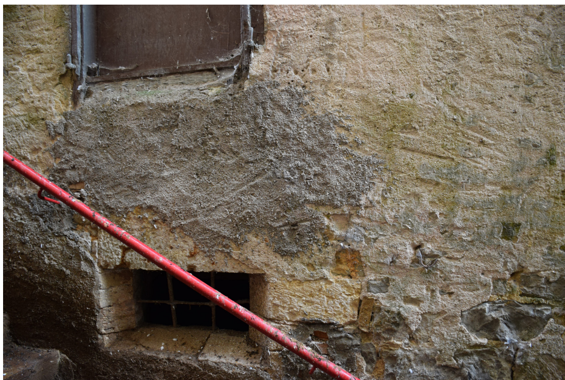
fig. 60 : superposition d'enduits (USC 42 et 161), façade 5 (Photographie : Eric Chabanne)
