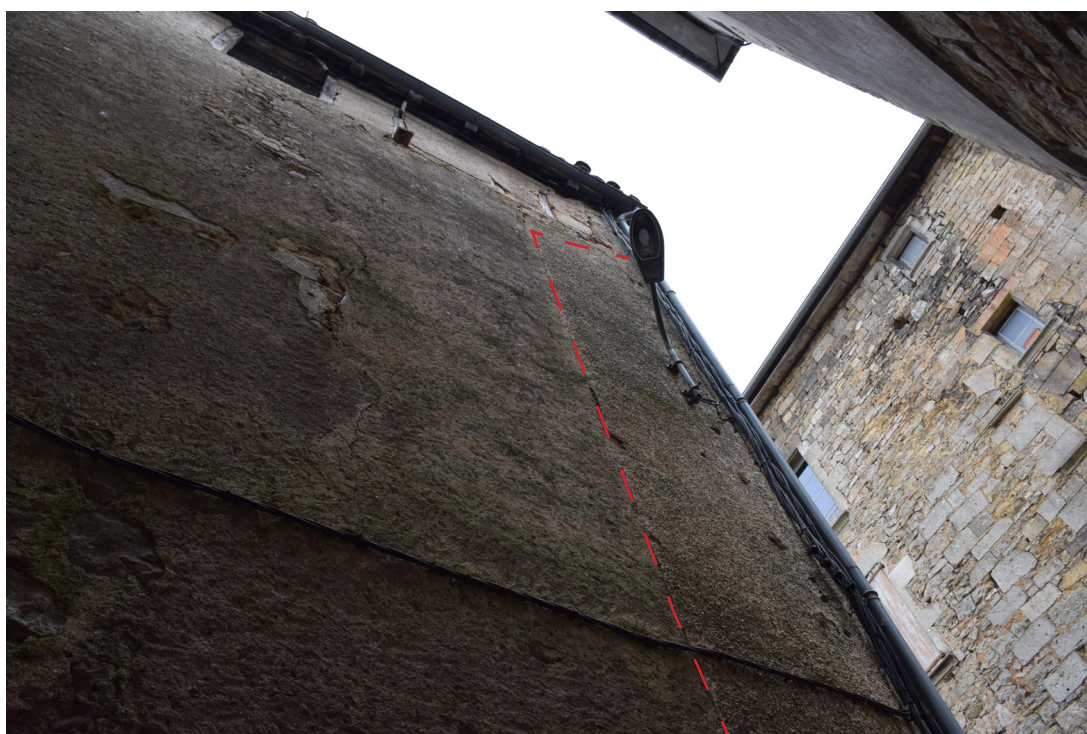
fig. 77 : enduit 2 qui recouvre l'enduit 4 sur la partie droite de la façade 1 (Photographie : Eric Chabanne)
