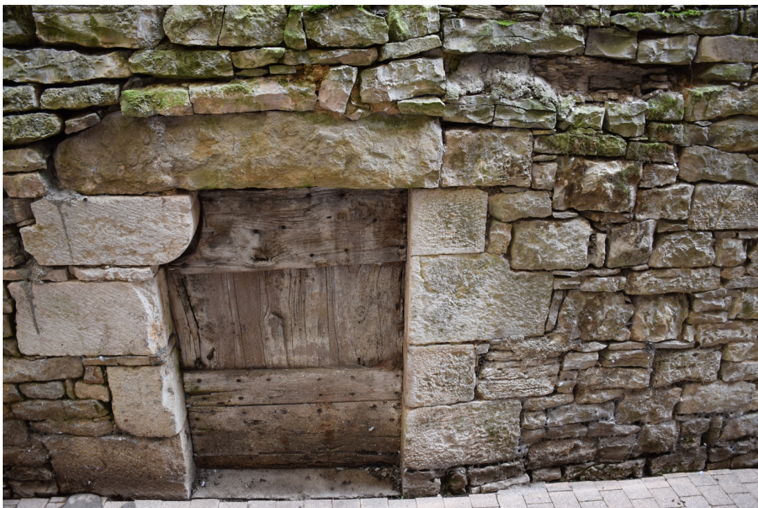
fig. 71 : Porte (POR 4), à linteau sur un unique coussinet en quart de rond (Photographie : Eric Chabanne)
