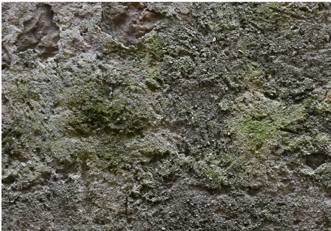
fig. 76 : détail de l'enduit 4 sur la façade 1 (Photographie : Eric Chabanne)
