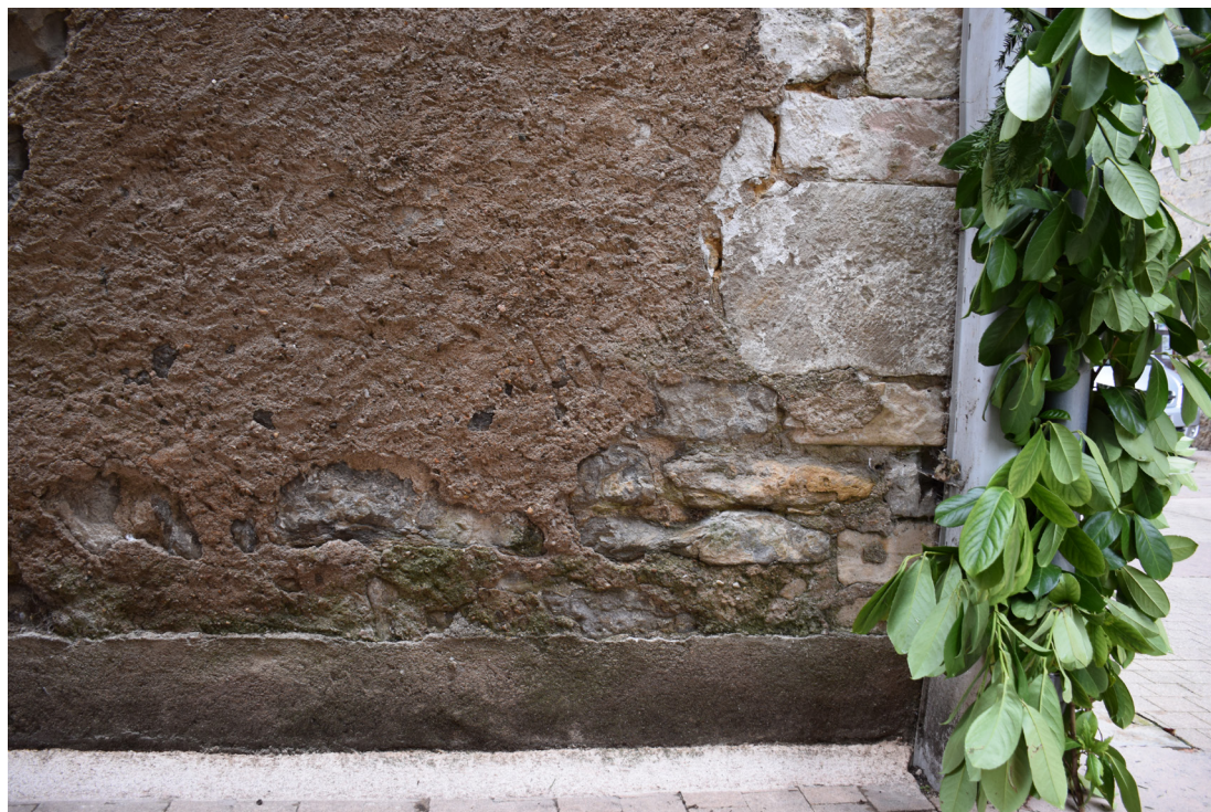
fig. 55 : détail des parements (USC 130, 173) sur la façade 1 (Photographie : Eric Chabanne)
