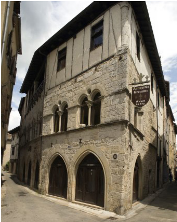
fig. 82 : Saint-Antonin-Noble-Val, maison dite « du roi » (Photographie : Cl. Inventaire Midi-Pyrénées, IVR73_20088201038NUCA, P. Poitou)
