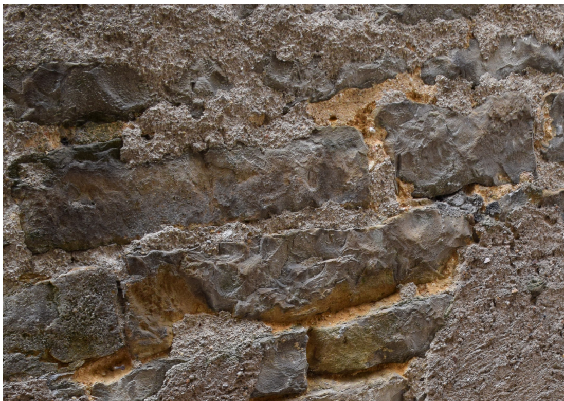
fig. 54 : détail du parement (USC 3) sur la façade 1 (Photographie : Eric Chabanne)
