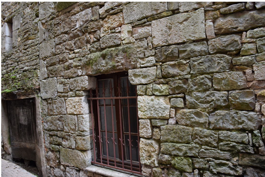
fig. 68 : fenêtre FEN 11 à linteau sur coussinets en quart de rond (Photographie : Eric Chabanne)
