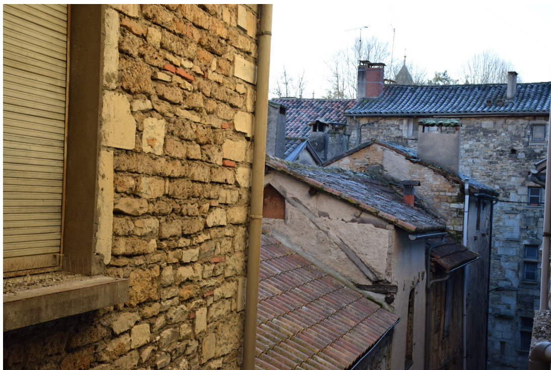
fig. 59 : exemple de parement (USC 46) de la façade 5 (Photographie : Eric Chabanne)
