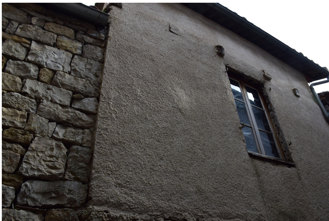
fig. 80 : enduit 27 qui recouvre le troisième niveau de la façade 3 (Photographie : Eric Chabanne)
