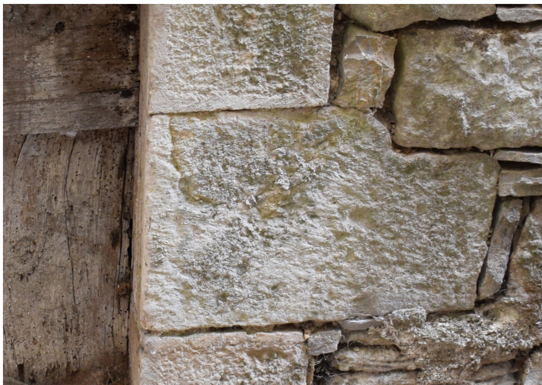
fig. 91 : traces d'outils, piédroit sud de l'ouverture POR 4 (Photographie : Eric Chabanne)
