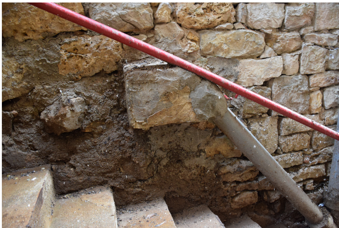
fig. 81 : enduit (USC 69) sur la façade 5 (Photographie : Eric Chabanne)
