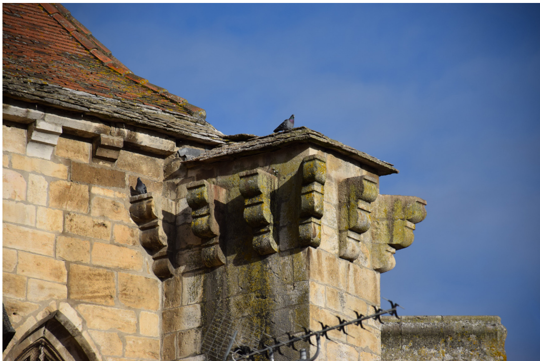
fig. 12 : contrefort du chevet de l'église, corbeaux supportant anciennement un hourd (Source : Eric Chabanne)
