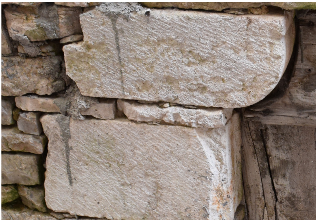
fig. 93 : traces d'outils, piédroit nord de l'ouverture POR 4 (Photographie : Eric Chabanne)
