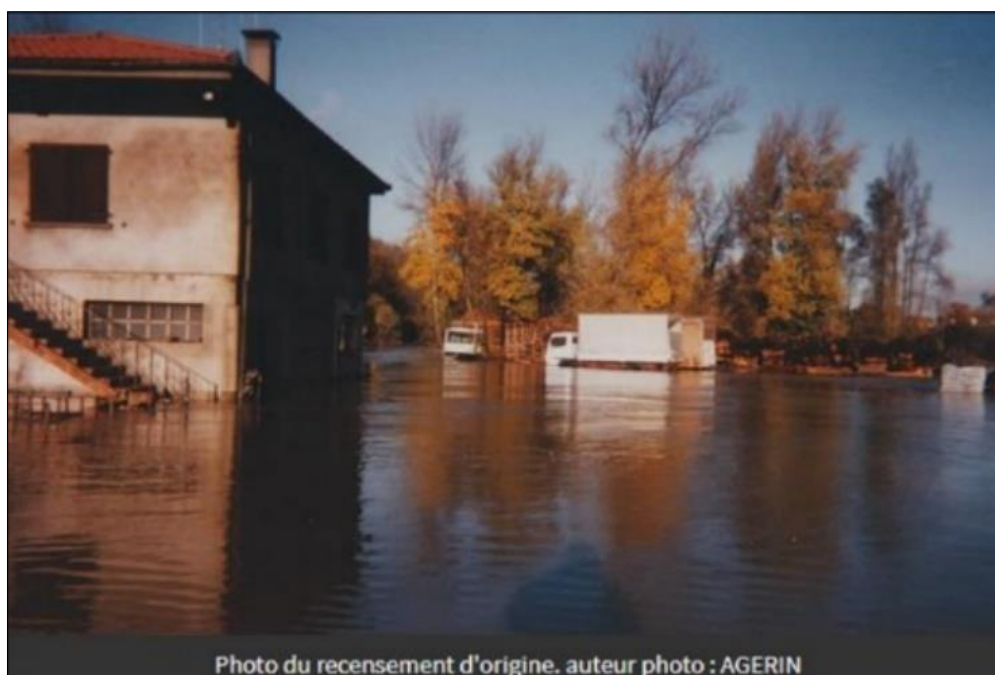
Figure 20 : Débordement de l'Ariège à Saverdun en décembre 1996 - © AGERIN, 1996
