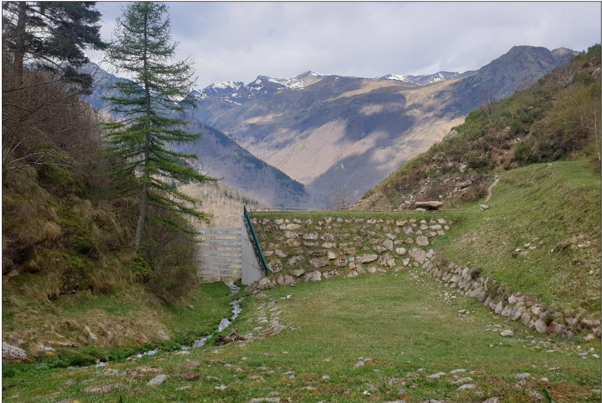
Figure 5 : Vue des reliefs depuis la retenue du barrage sédimentaire du Saint-Touret à Mérens-les-Vals sur la CCHA - © Hugo PINGRET, 2021
