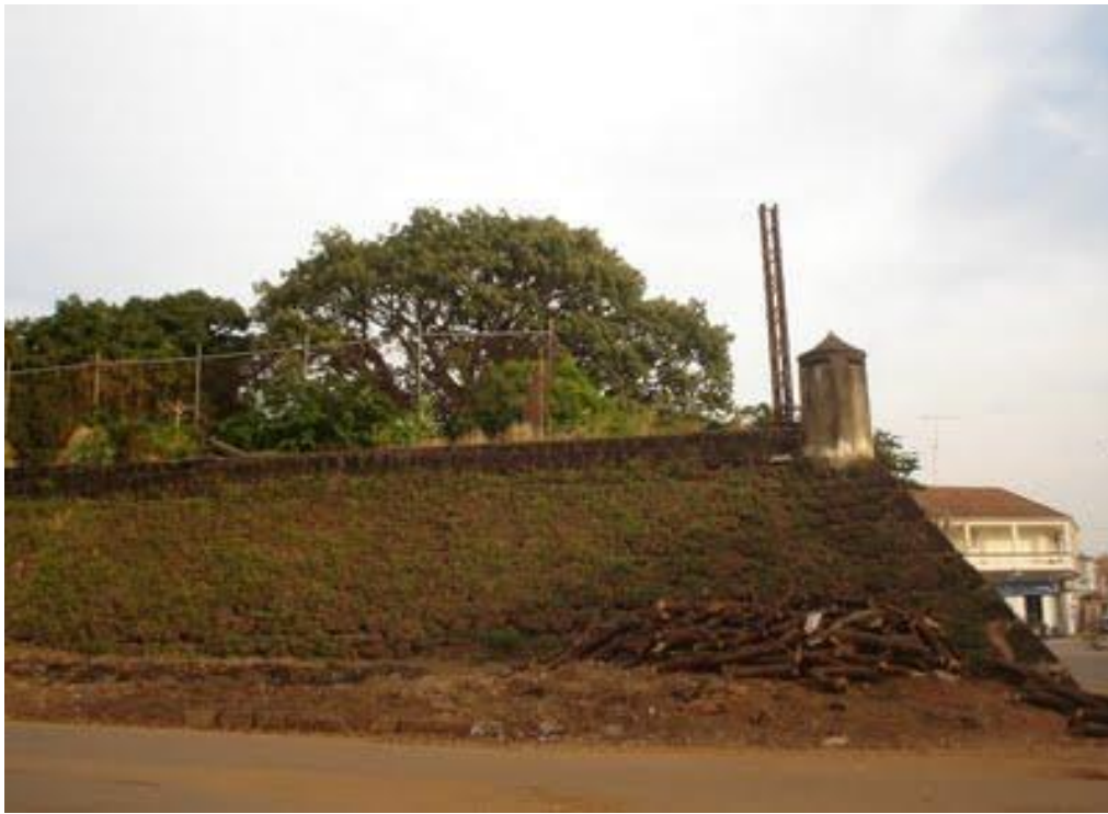
Photo 3: Mur de sécurité de la forteresse (Source : Gomis, E.N, août, 2018.)
