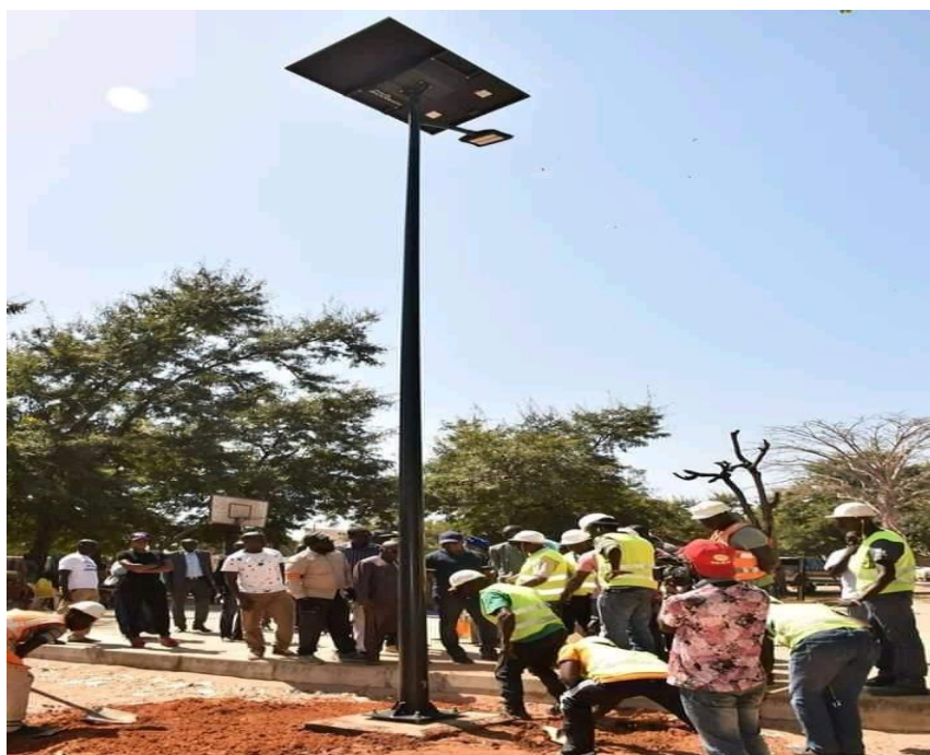
Photo 39: Lancement des travaux d'installation de lampadaires solaires à travers la ville de Ziguinchor par le maire Abdoulaye Baldé
