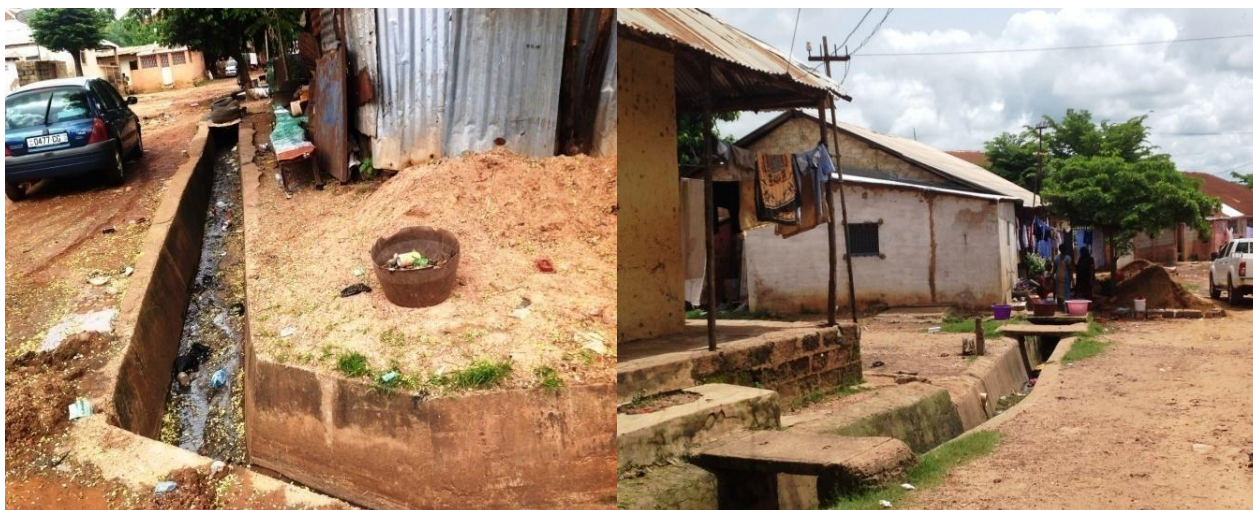
Photo 38: Canalisation pour l'évacuation des eaux usées en centre ville dans le quartier Q.G (Source : Gomis, E.N, 2019)
