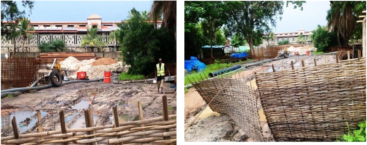
Photo 28: La STEP de Ziguinchor en construction
