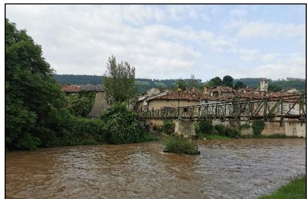
Figure 31 : Passerelle surélevée au Bordes-sur-Arize, 25/05/23, Ilona R-L
