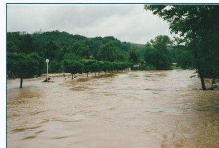
Crue du 11 juin 2000, Mairie
