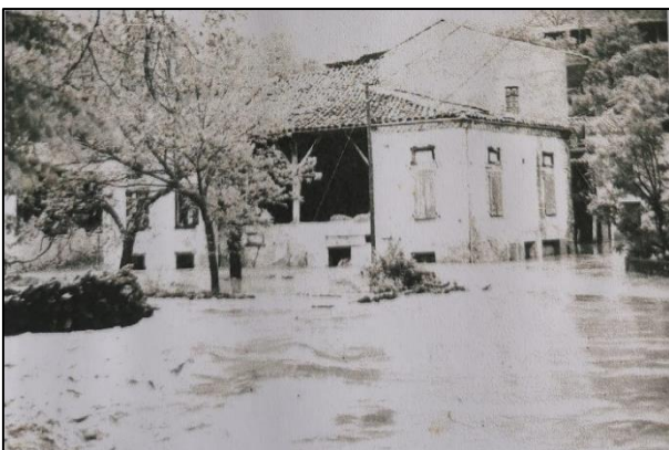
Figure 30 : Crue 1977 à Durban-sur-Arize, RTM 09
