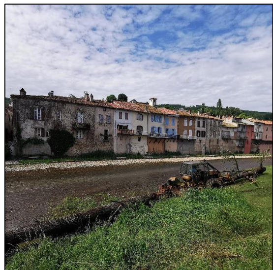
Figure 17 : Restauration de la berge en rive gauche de l'Arize au Bordes-sur-Arize, 06/06/23, Ilona R-L
