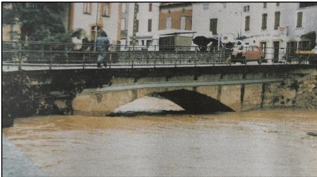
Figure 35 : Crue 1993, Campagne-sur-Arize, RTM 09
