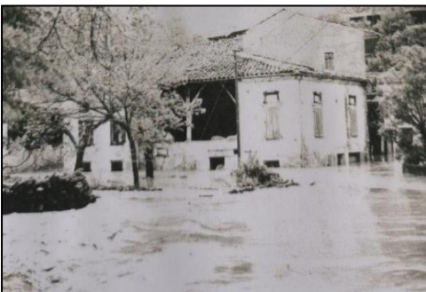
Figure 48 : Crue 1977 à Durban-sur-Arize, RTM 09
