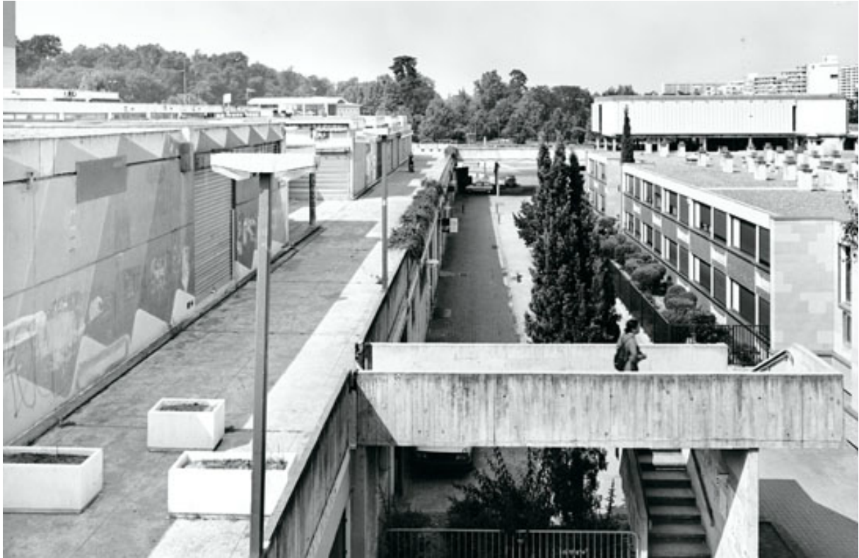
La dalle, survol du quartier par les piétons
