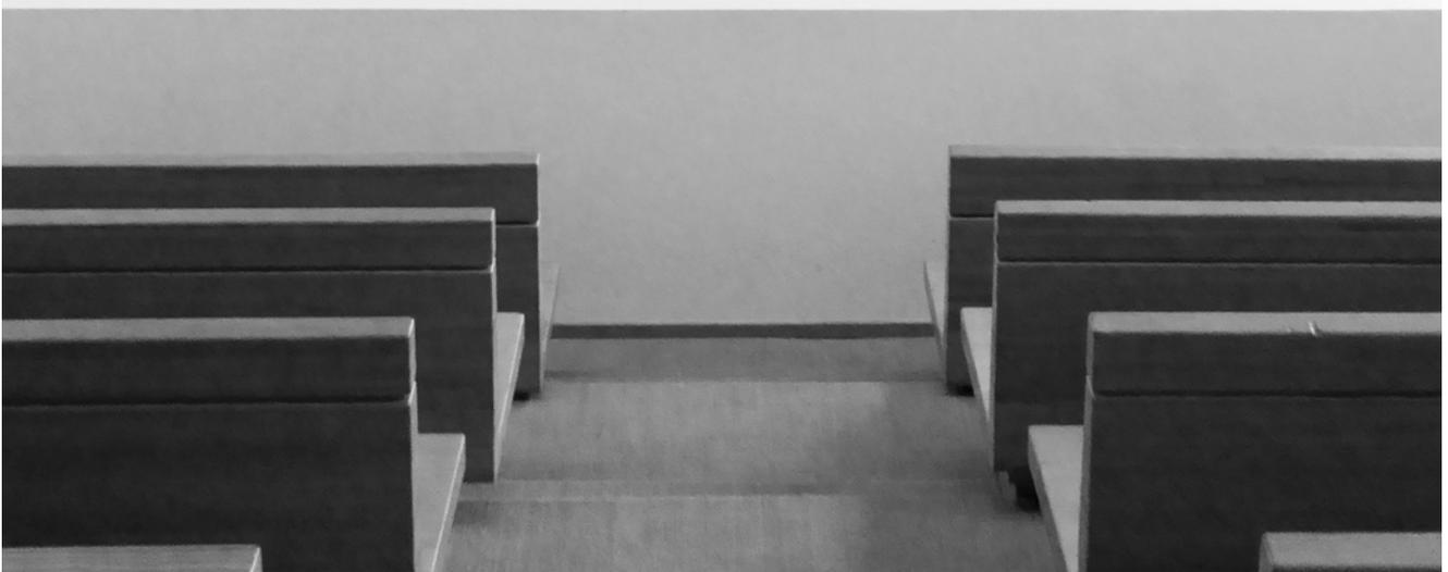
362 - Joints creux latéraux dissociant l'angle de jonction des surfaces verticales et horizontales - Lahti
