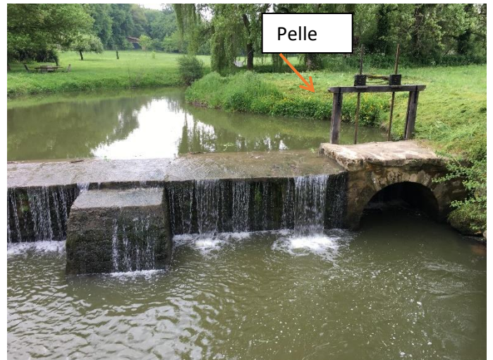
Figure 18 : Photographies de l'ouvrage du Moulin de Magnon
