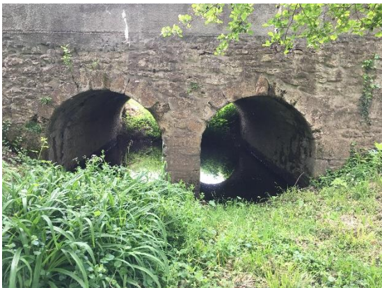
Figure 15 : Buses de décharge du moulin de Saint Loubert
