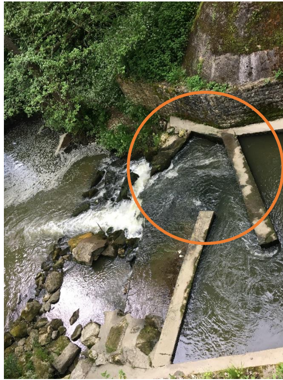
Figure 20 : Ouvrage de la D116 et problématiques observées
