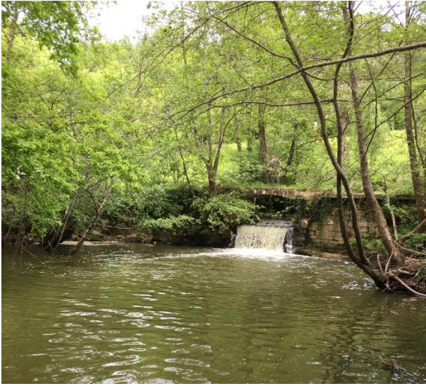
Figure 25 : Ouvrage du Moulin d'Auros
