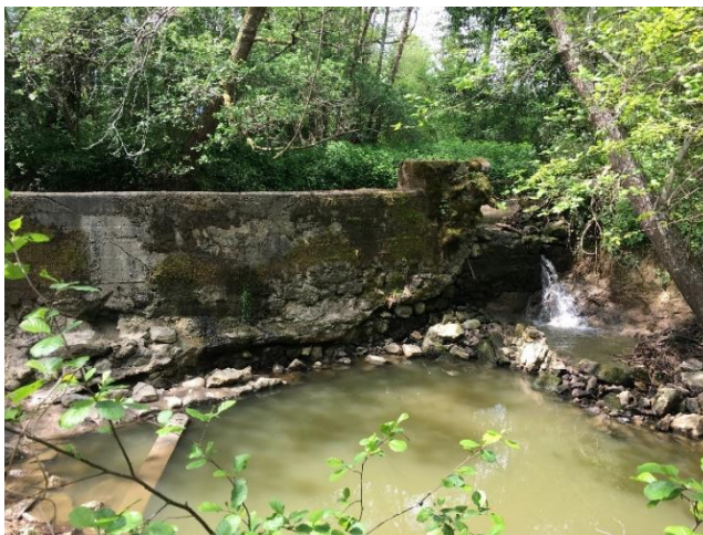
Figure 23 : Passe-mesure du moulin du Pont
