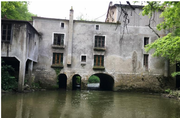
Figure 19 : Ouvrage du Moulin de Repassat
