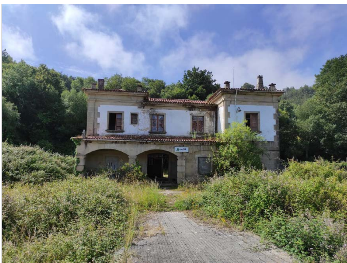
Figura 46 – Estación de O Castro – Silleda en la actualidad.
