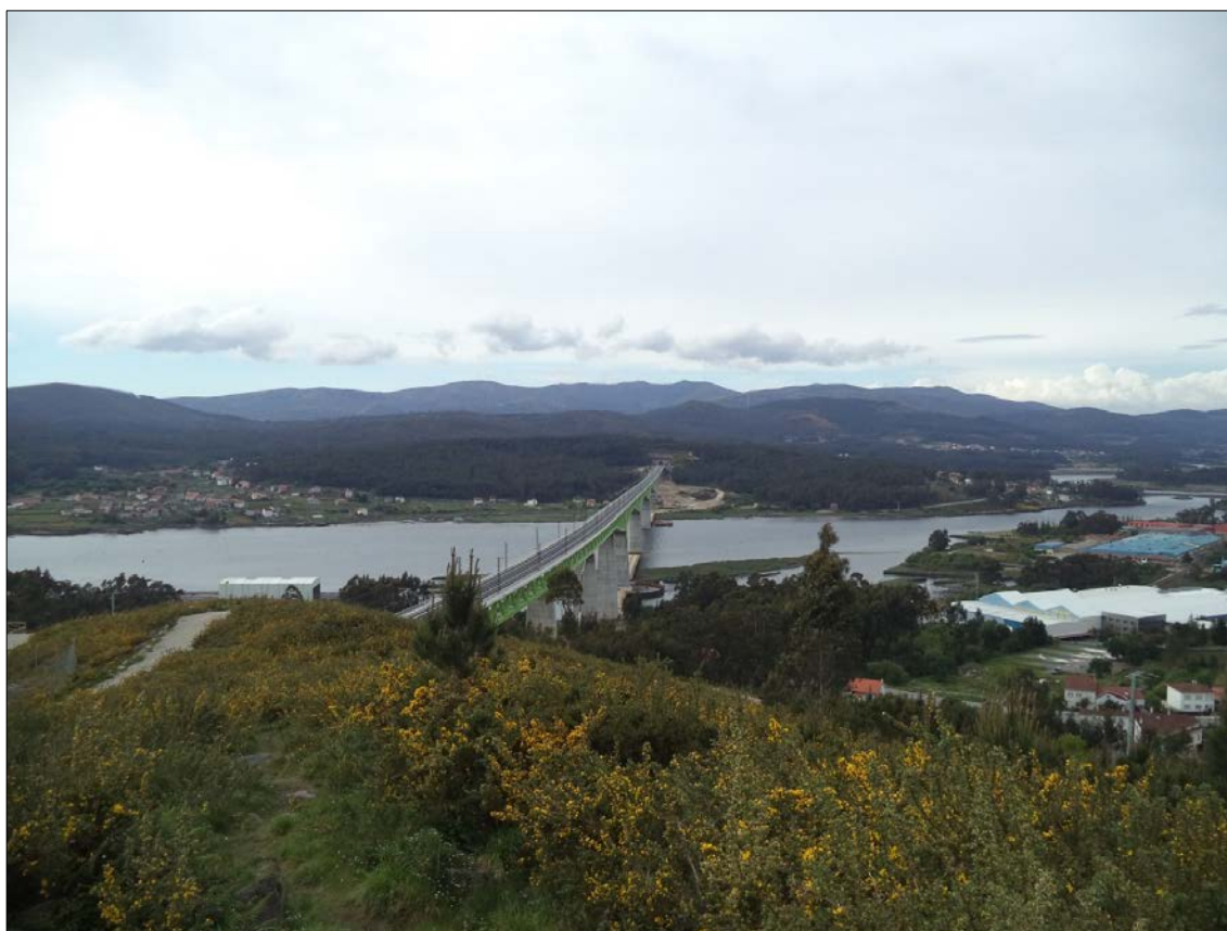
Figura 83 – Viaducto del Eje Atlántico sobre la desembocadura del río Ulla en la Ría de Arousa entre los municipios de Catoira (Pontevedra) y Rianxo (A Coruña). Fuente: Varela Cornado (2015)
