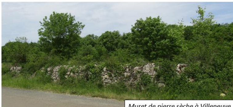
Muret de pierre sèche à Villeneuve
