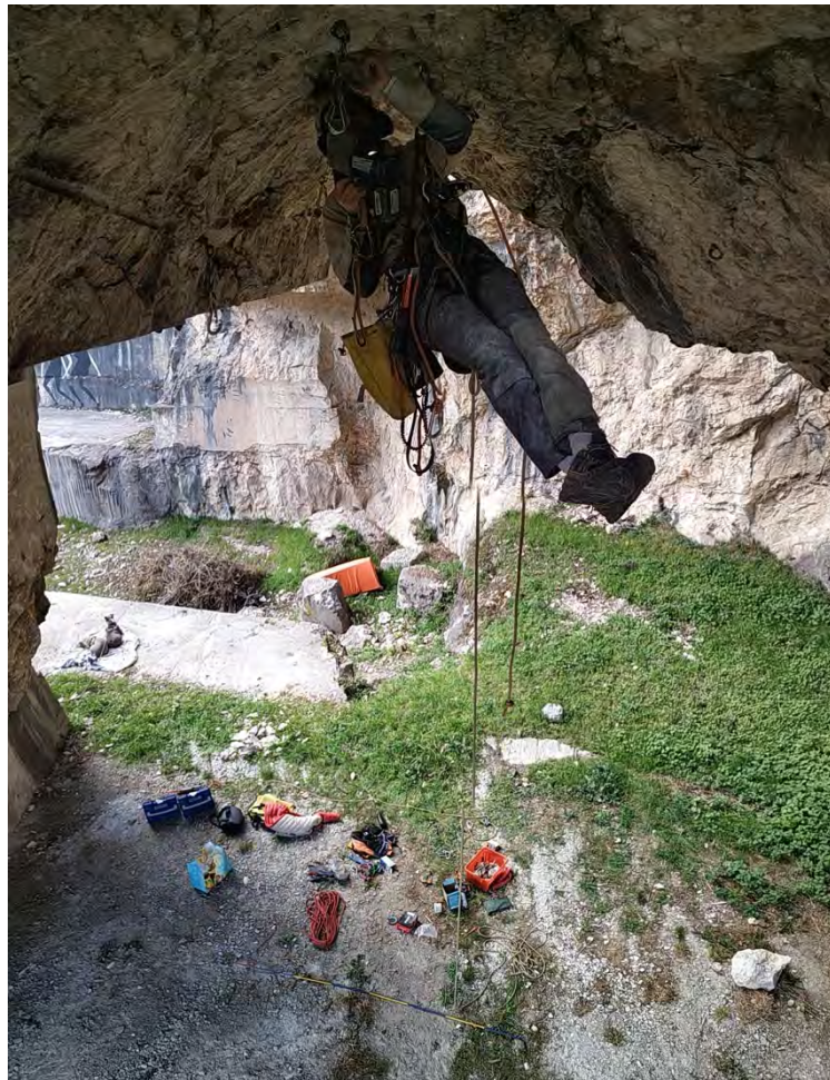
Figure 11 Philippe Mercanti, cadre technique réalisant l'équipement de de la falaise de Saint-Béat (31).
