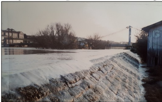
Photo : Line B. , la Garonne commençant à passer par dessus la digue au Rouergue, La Réole, 1981.
