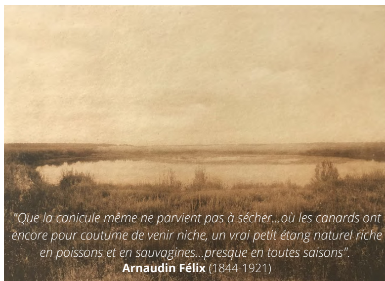
Figure 2 : Photographie ancienne lagune de Lardoune à Trensacq, Arnaudin Félix (1844-1921). ***
