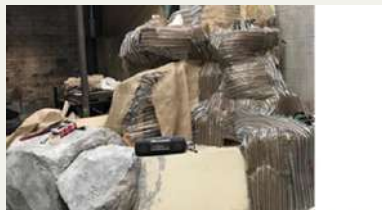
rochers : OSB + Negello + peau de vache fine + masticage plâtre et fibre de bois
