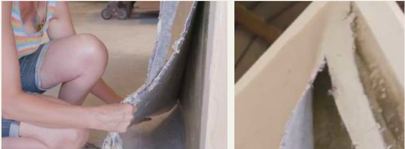
Circuit'Art 2 : Optimizer set construction | Optimiser vos décors.
