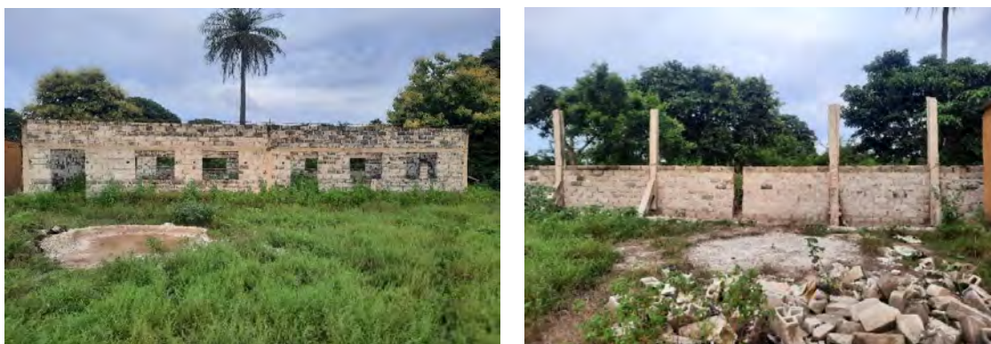
Image 14 : Salles de classe et mur en construction à l'école élémentaire de Tabi
