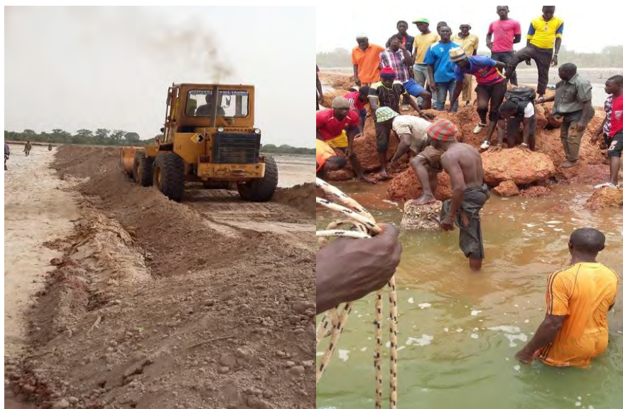
Image 6 : Aménagement de la route de Baranlir
