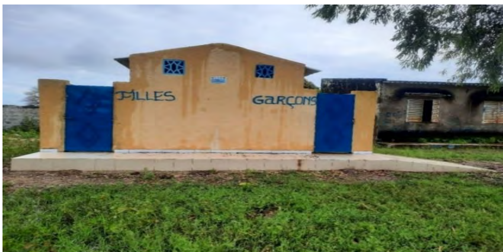
Image 11 : Toilettes du Collège d'Enseignement Moyen (CEM) de la commune de Diembéring
