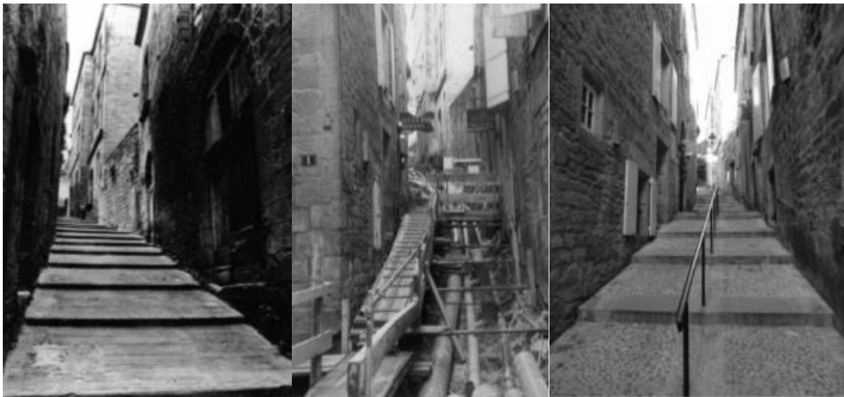
Illustration 3 : Travaux Côte de Toulouse 1995, photographie : Mairie de Sarlat
