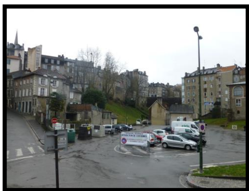
Figure 21 : Hédas avant travaux Source : SIAB
