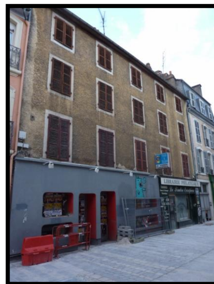
Figure 27 : 5 rue Lamothe avant travaux Source : SIAB
