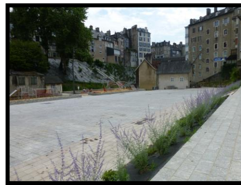
Figure : 22 Hédas après travaux Source : SIAB
