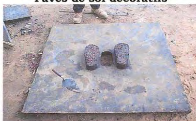
Dalle de latrine
