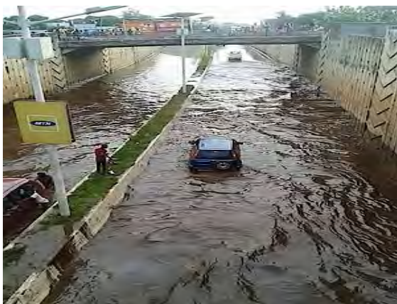
Photo 21: Pont de l'aéroport inondé
