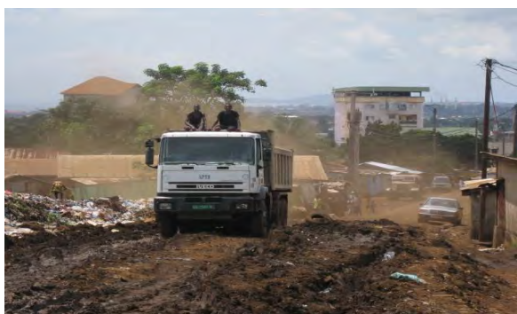
Entrée de la décharge complètement dégradée
