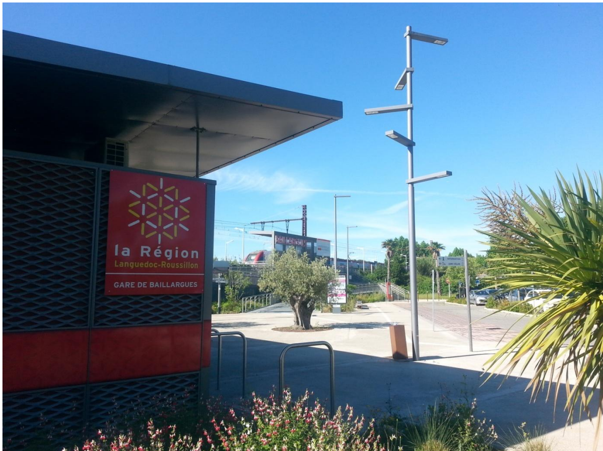
Figure 46 : Le PEM de Baillargues (34), et sa consigne à vélos au premier plan, photographie par l'auteur
